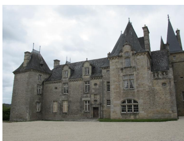
Vue générale, façade nord-ouest sur la cour Phot. Véronique Orain IVR53_20132215273NUCA
