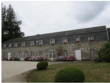
Communs Phot. Véronique Orain IVR53_20132215280NUCA
