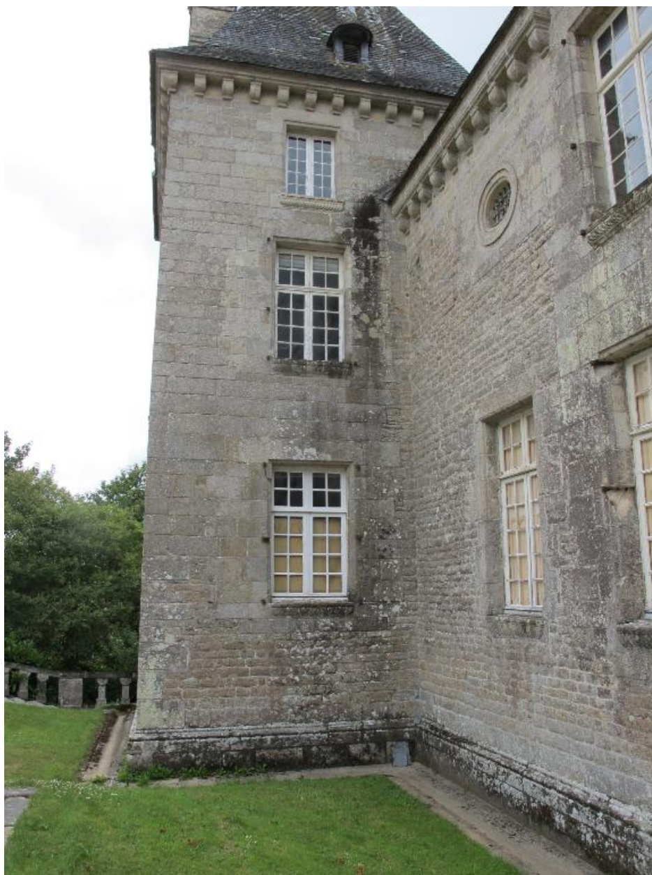
Pavillon nord est, façade sur cour
