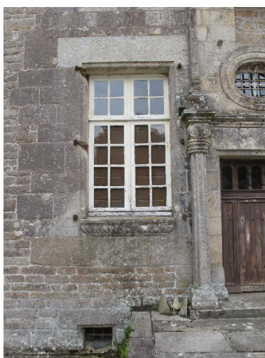
Détail, fenêtre du rez-de- chaussée, appui à godrons Phot. Véronique Orain IVR53_20132215274NUCA
