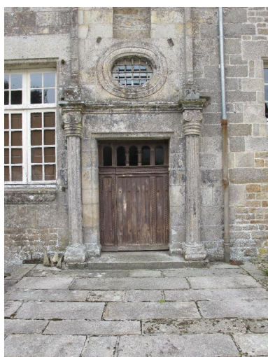
Porte de style renaissance, façade nord-ouest Phot. Véronique Orain IVR53_20132215283NUCA
