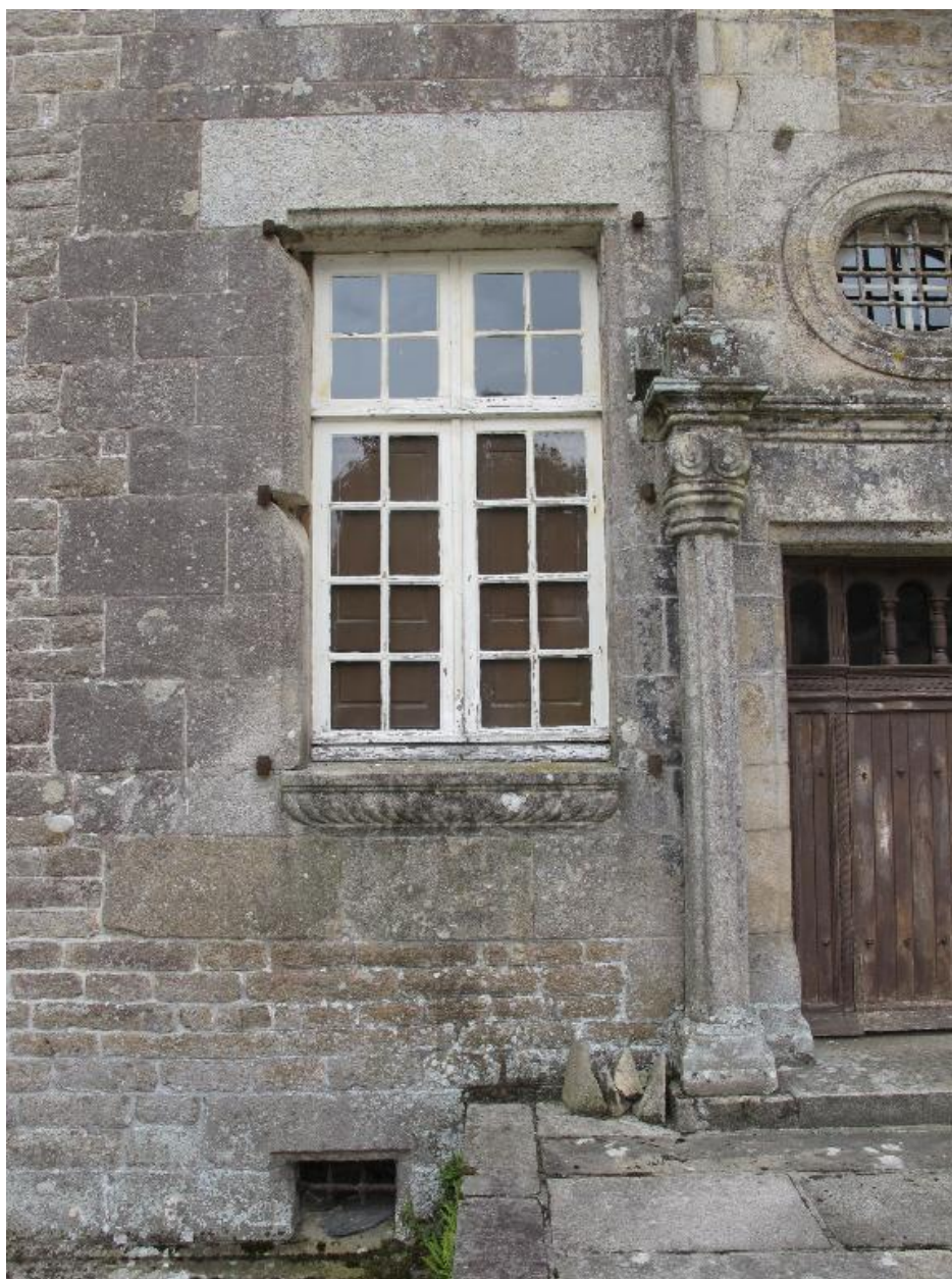
Détail, fenêtre du rez-de-chaussée, appui à godrons
