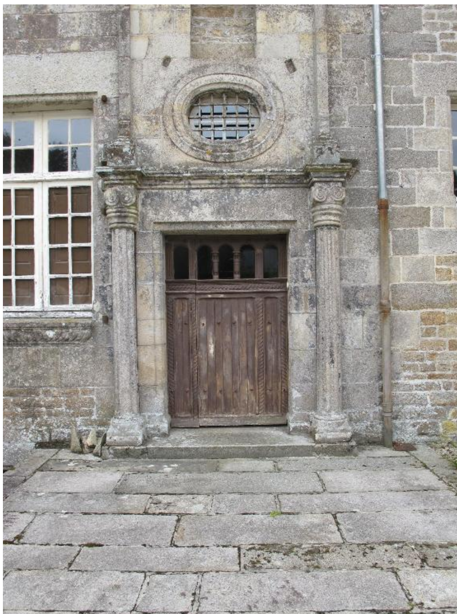
Porte de style renaissance, façade nord-ouest
