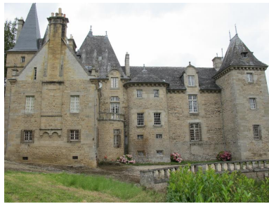
Vue générale sud est sur jardin Phot. Véronique Orain IVR53_20132215276NUCA
