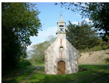
Primelin, chapelle Saint- Chrysanthe : élévation ouest Phot. Gwénaél Fauchille IVR53_20082905755NUCA
