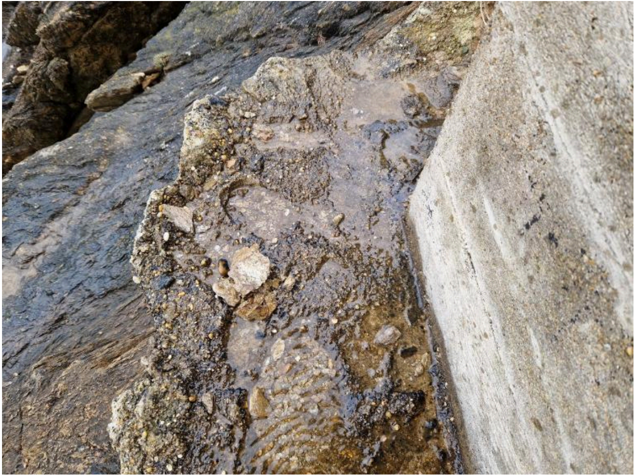
Vue de détail. La semelle de béton du bunker montre des traces de pas
