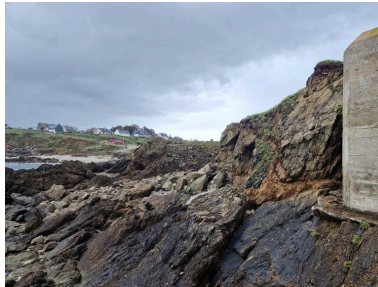
Vue de situation. Du côté ouest de l'îlot, l'érosion marine est forte. En arrière-plan, le mur en maçonnerie de moellon cache le bunker - abri Phot. Guillaume Lécueillier IVR53_20242911188NUCA
