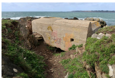
Vue générale. L'entrée est partiellement remblayée Phot. Guillaume Lécueillier IVR53_20242911187NUCA
