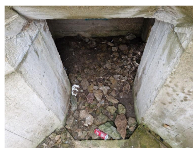
Vue intérieure : plan octogonal. En face, escalier d'accès au poste d'observation et de tir Phot. Guillaume Lécueillier IVR53_20242911195NUCA
