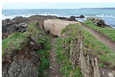
Vue générale. Au premier plan, la tranchée de communication creusée dans le roc Phot. Guillaume Lécueillier IVR53_20242911186NUCA
