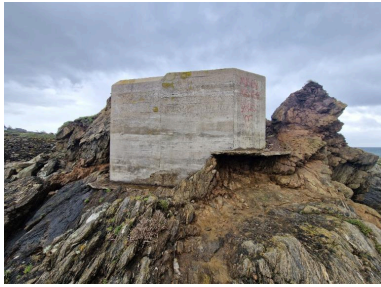
Vue générale. Du côté ouest de l'îlot, l'érosion marine est forte Phot. Guillaume Lécueillier IVR53_20242911189NUCA
