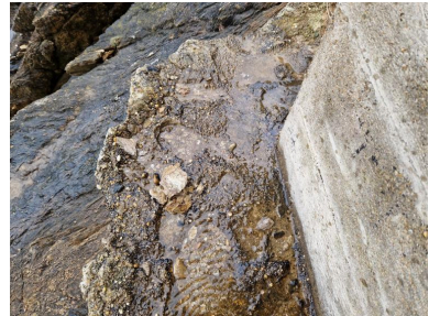
Vue de détail. La semelle de béton du bunker montre des traces de pas Phot. Guillaume Lécueillier IVR53_20242911191NUCA
