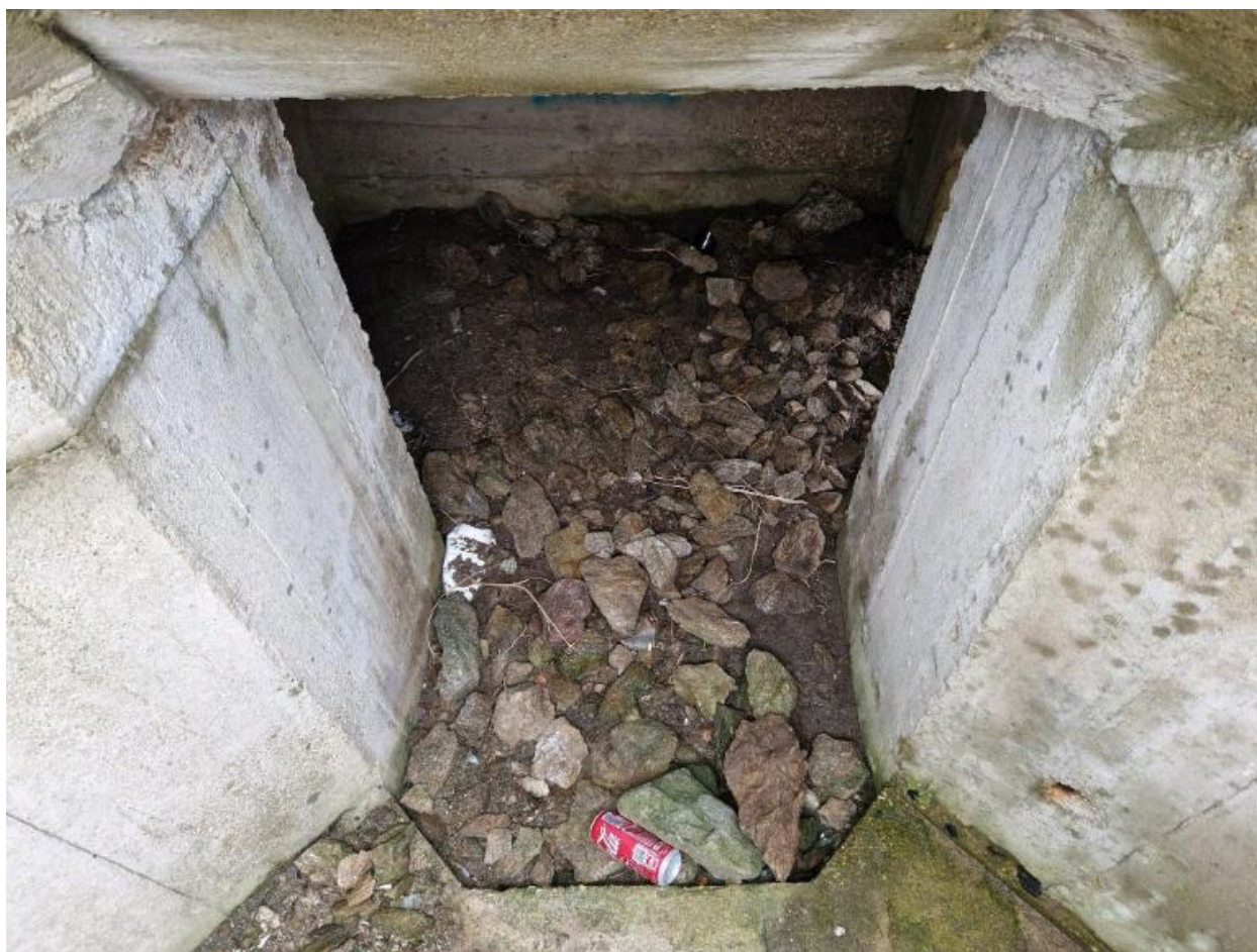
Vue intérieure : plan octogonal. En face, escalier d'accès au poste d'observation et de tir
