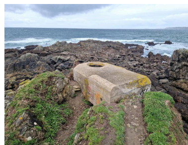
Vue générale. L'entrée est partiellement remblayée Phot. Guillaume Lécueillier IVR53_20242911192NUCA
