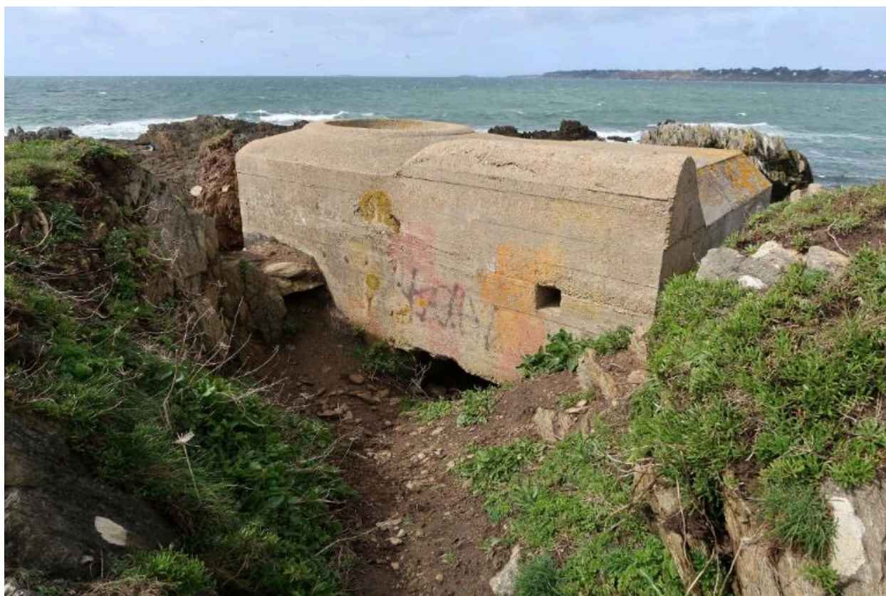
Vue générale. L'entrée est partiellement remblayée
