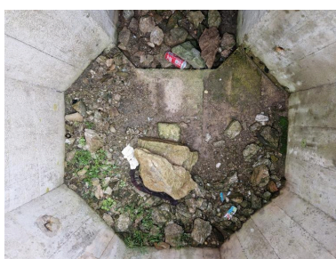
Vue intérieure : plan octogonal. En haut, escalier d'accès au poste d'observation et de tir Phot. Guillaume Lécueillier IVR53_20242911194NUCA
