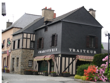
Vue générale sud-est Phot. Elise Lauranceau IVR53_20063512007NUCA
