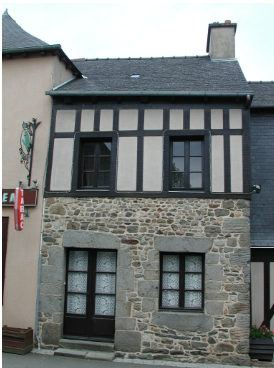
Elévation ouest : partie gauche du bâtiment
