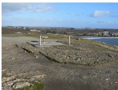
Vue générale du sémaphore de la pointe des tas de Pois Phot. Julien Amghar IVR53_20072908584NUCA
