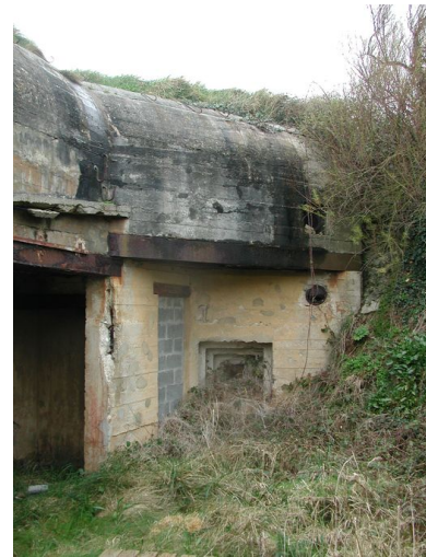
Vue de l'entrée flanquée par un créneau de défense (état en 2002). La couleur jaune est d'origine Phot. Guillaume Lécueillier IVR53_20022901529NUCA
