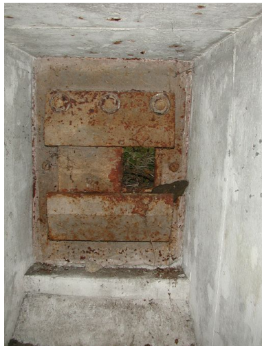
Vue intérieure d'un créneau de défense (état en 2002). Le volet blindé est en place Phot. Guillaume Lécueillier IVR53_20022901530NUCA
