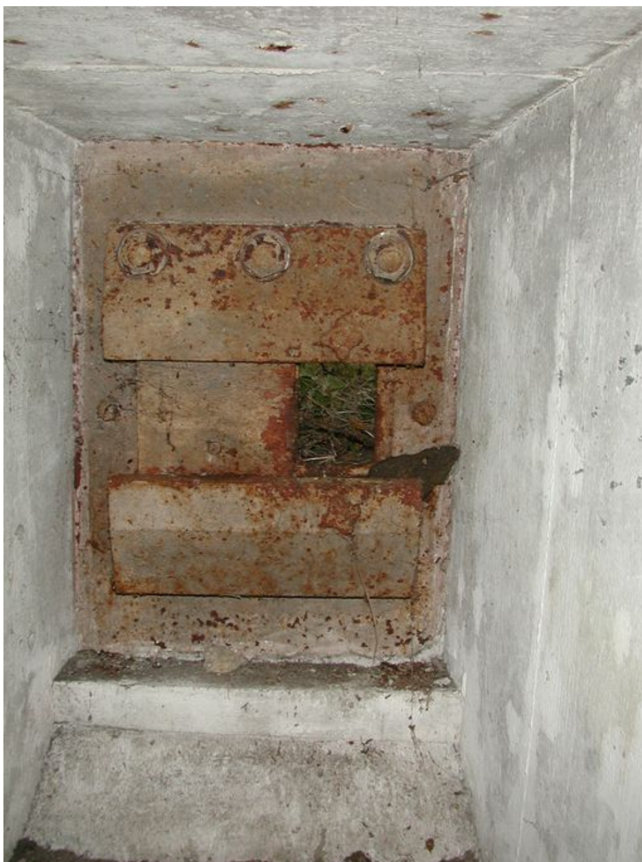
Vue intérieure d'un créneau de défense (état en 2002). Le volet blindé est en place
