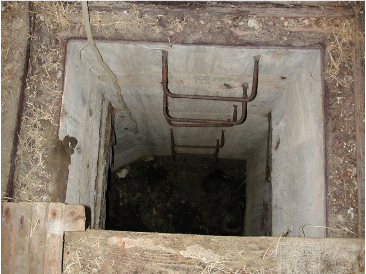
Vue de la trappe d'accès de la fosse de récupération des douilles situées dans la chambre de tir (état en 2002). L'accès se fait par des échelons
