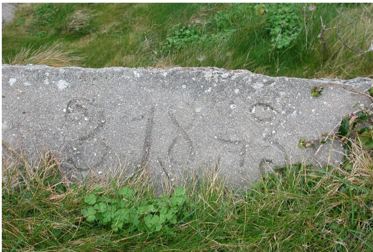
Vue d'un millésime tracé dans le béton frais : 31 8 43 (état en 2004)
