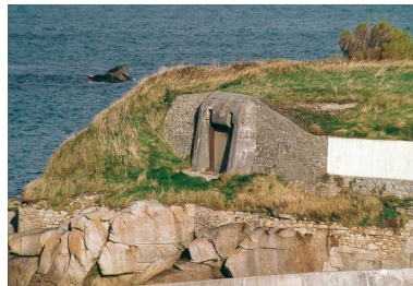
Vue générale depuis le sud-ouest (état en 2002). L'embrasure du bunker est flanquée de murs en maçonnerie de moellon de granite. Une portion de ce mur est enduite et peinte en blanc car servant à la signalisation maritime Phot. Guillaume Lécueillier IVR53_20022901525NUCA
