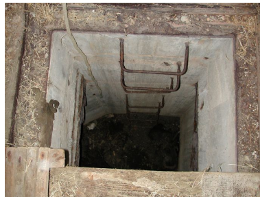
Vue de la trappe d'accès de la fosse de récupération des douilles situées dans la chambre de tir (état en 2002). L'accès se fait par des échelons Phot. Guillaume Lécueillier IVR53_20022901531NUCA
