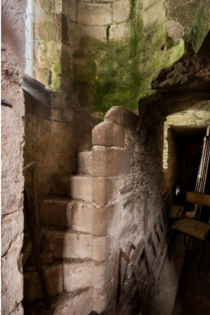
Elevation ouest, détail d'un escalier en vis
