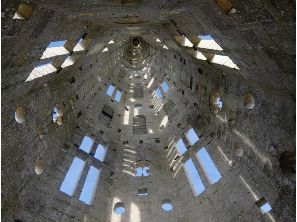
Détail de la flèche de la tour des Cloches
