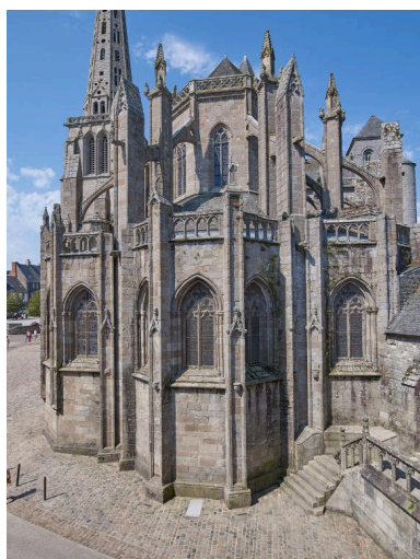
Vue générale du chevet Phot. Bernard Bègne IVR53_20202200127NUCA
