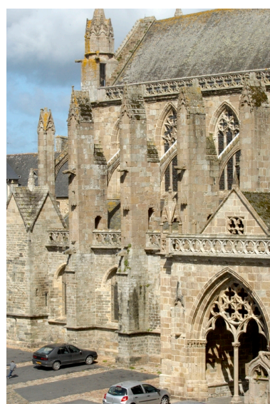
Détail de l'élévation sud de la nef
