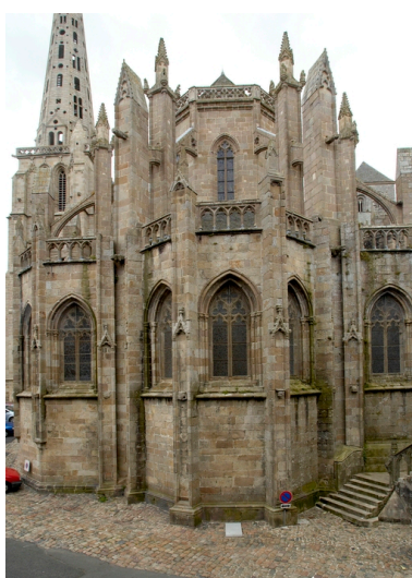
Vue générale du chevet, 2008 Phot. Norbert Lambart
