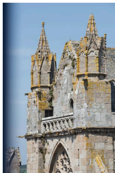
Détail de la façade occidentale Phot. Charlotte Barraud IVR53_20172200770NUCA
