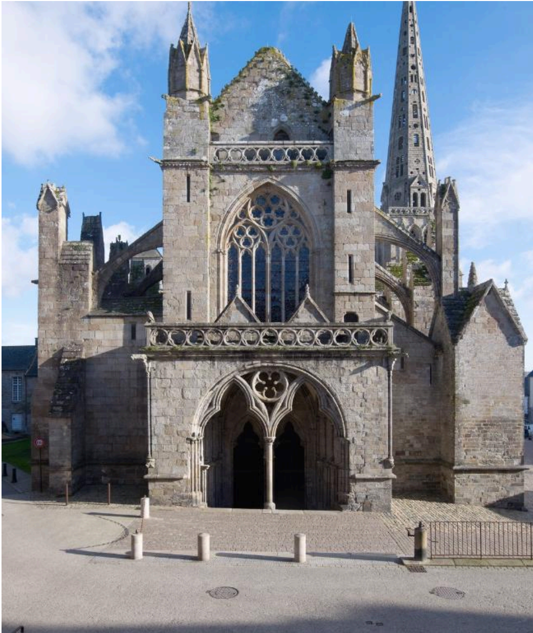
Façade occidentale, vue générale
