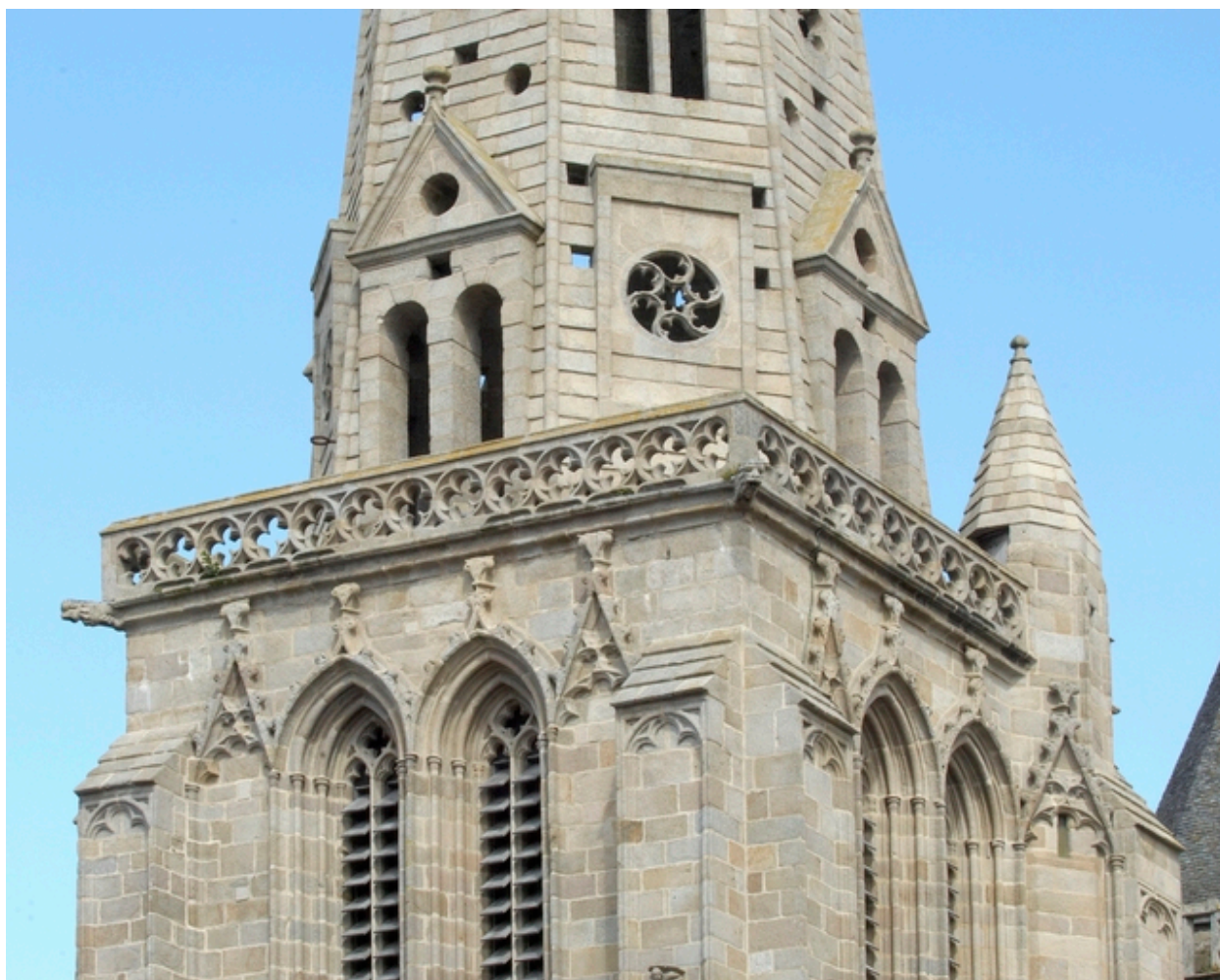
Détail de la tour des Cloches
