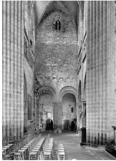
Elévation sud de la tour Hasting, vers le croisillon Phot. Auteur inconnu IVR53_19832200059V
