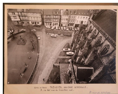
Tréguier : cathédrale Saint-Tugdual, la nef depuis le croisillon sud, 1966 (archives de la Conservation régionale des Monuments historiques de Bretagne) IVR53_20182205852NUCA
