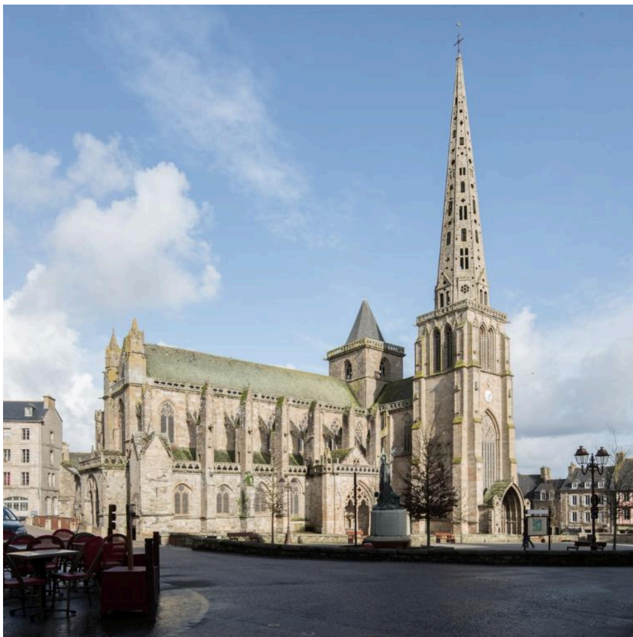
Vue générale sud-ouest, 2018 : la cathédrale Saint-Tugdual et la place du Martray
