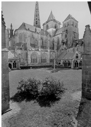
Transept nord, tour Hasting et choeur vus du cloître Phot. Guy Artur IVR53_19832200053V
