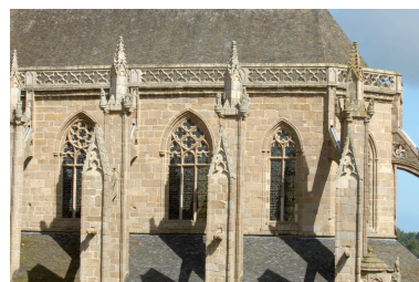
Détail du chevet Phot. Norbert Lambart IVR53_20082200005NUCA
