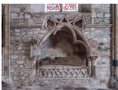
Collatéral sud, enfeu gothique et gisant Phot. Delia Gaulin-Crespel IVR53_20182200248NUCA
