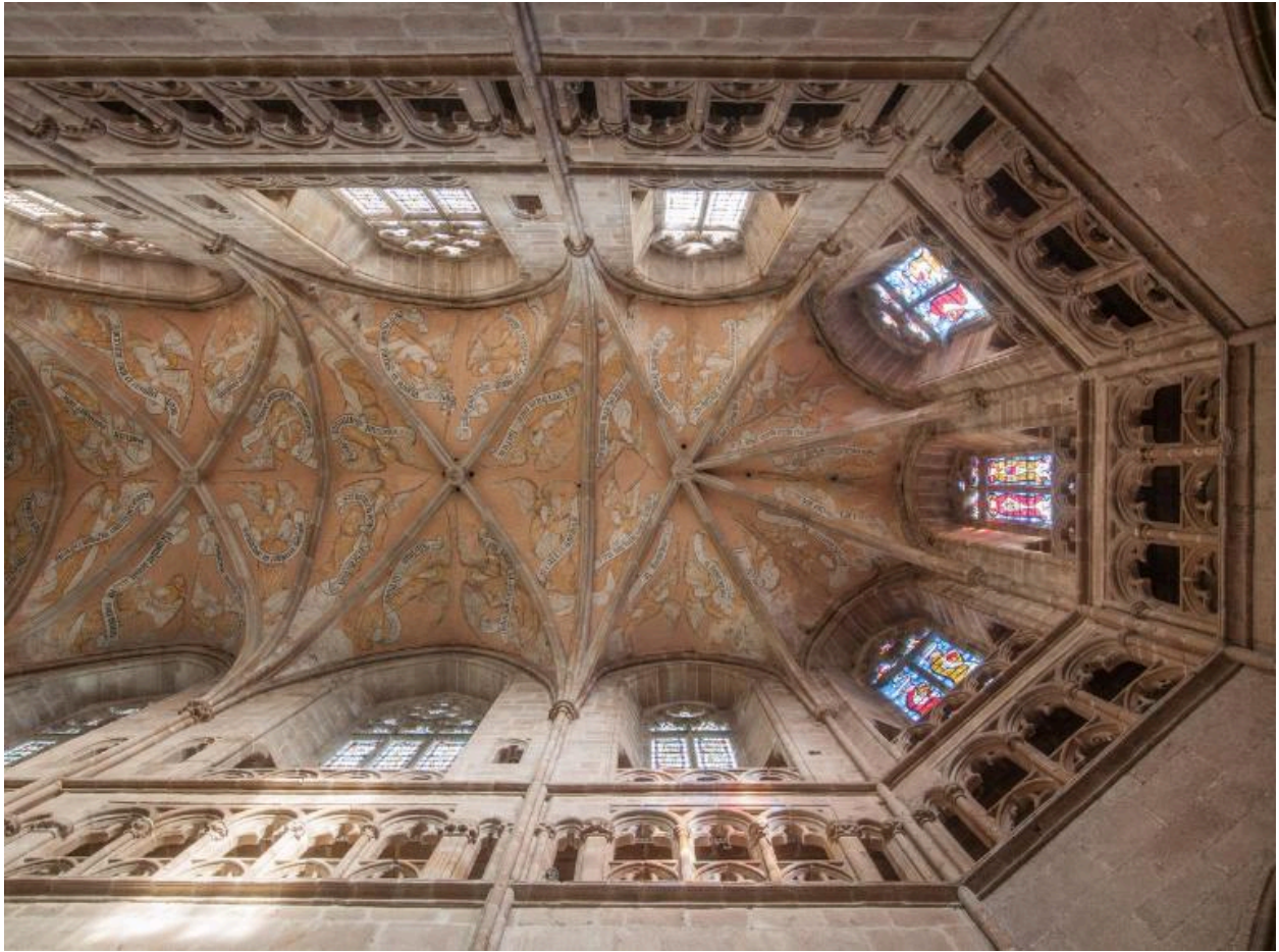
Voûtes sur croisées d'ogives du chœur
