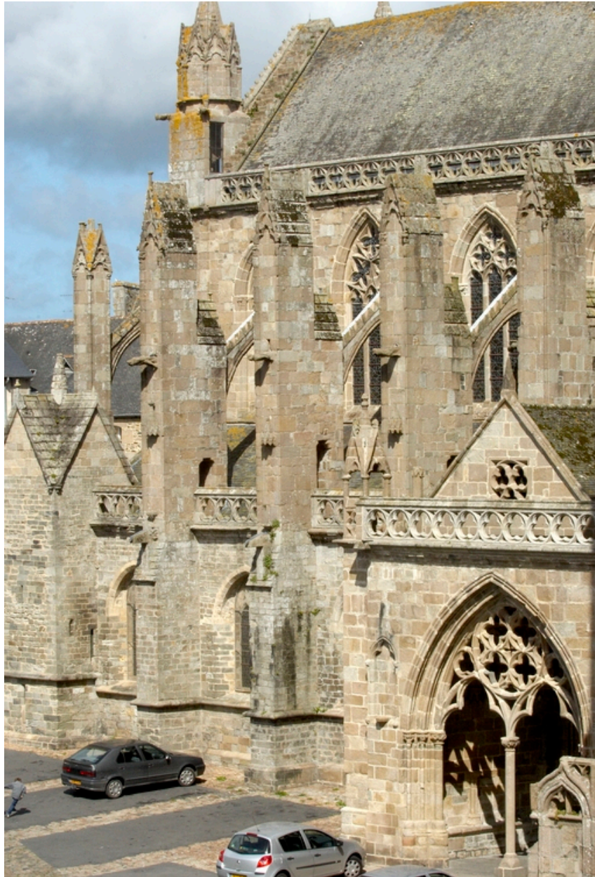
Détail de l'élévation sud de la nef
