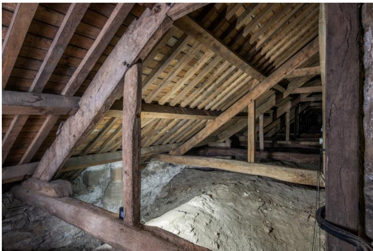
Détail du bas-côté nord : extrados de la voûte et charpente
