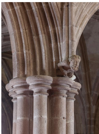
Détail de l'un des piliers orné d'une tête humaine Phot. Delia Gaulin-Crespel IVR53_20182200271NUCA
