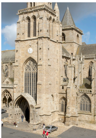
Détail de la tour des Cloches Phot. Norbert Lambart IVR53_20082200012NUCA
