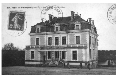
Carte postale ; façade nord-ouest Repro. Guy Artur, Repro. Norbert Lambart IVR53_19883500444X
