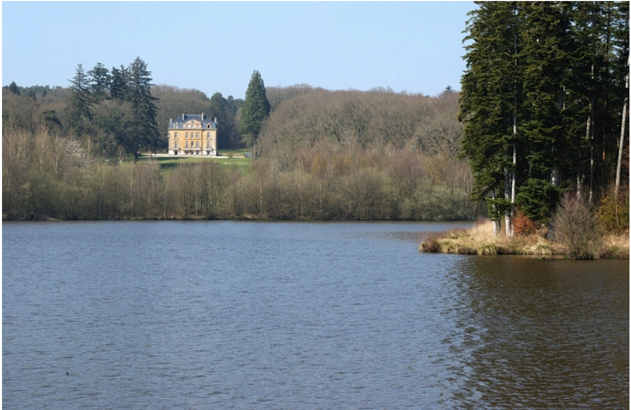
Vue de situation sud-est
