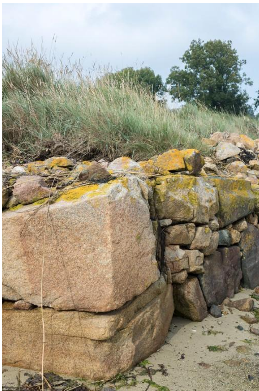
Détail de gros blocs de granite d'un mur de soutènement au fond de l'anse de Pellinec
