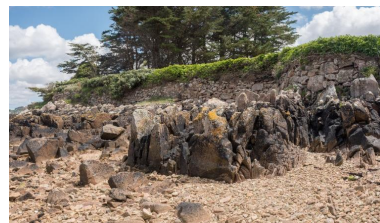
Vue d'un mur de soutènement de forme sinusoïdale, surplombant un affleurement rocheux, à côté du port de Buguélès Phot. Charlotte Barraud IVR53_20242200575NUCA
