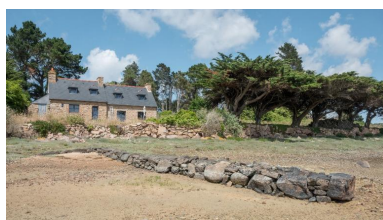
Jetée et mur de soutènement en pierre sèche au sud de l'île Balanec Phot. Charlotte Barraud IVR53_20242200589NUCA
