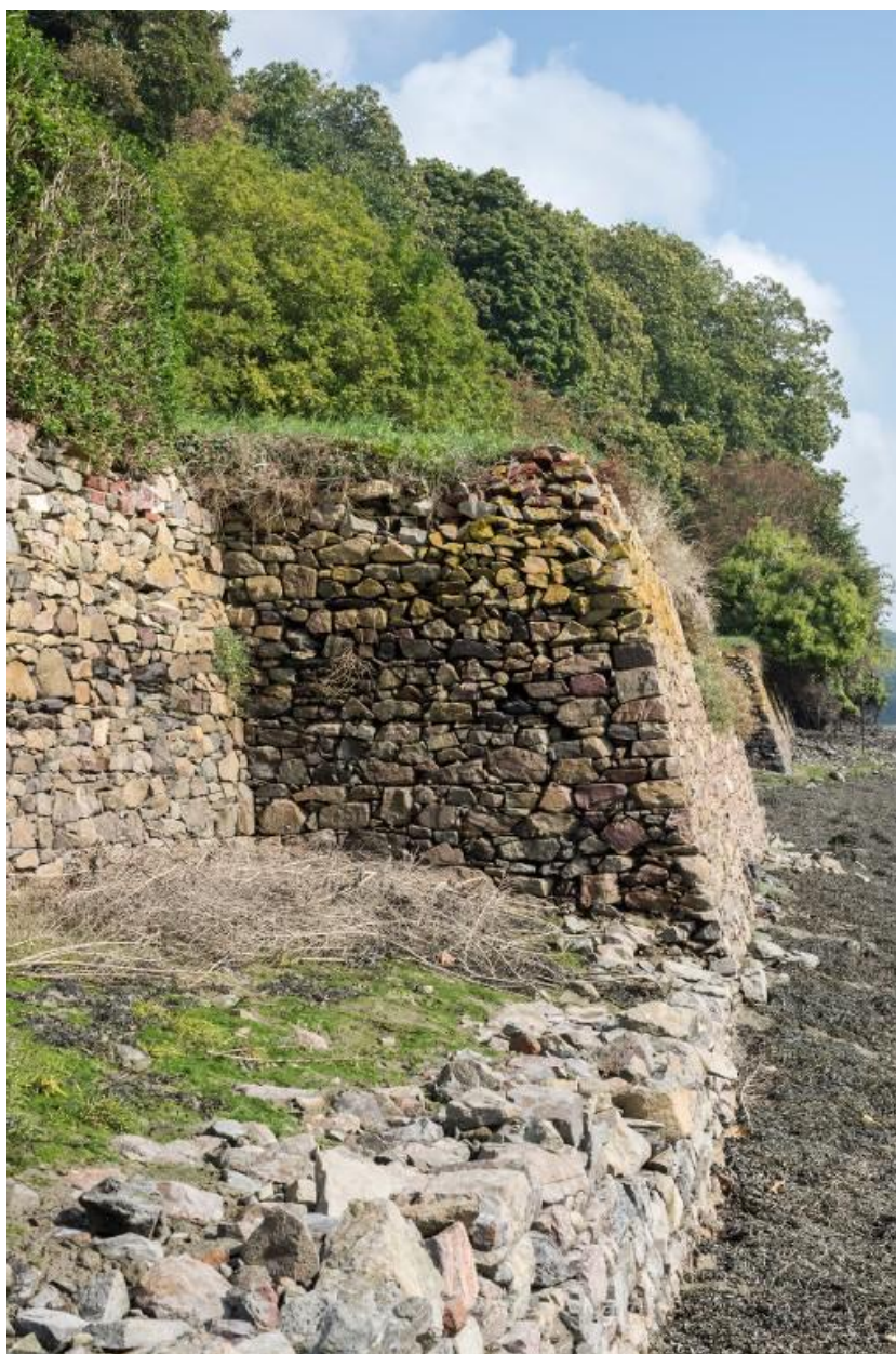
Vue de profil de la cale en pierre sèche du four à chaux, sur la rive Ouest du Jaudy
