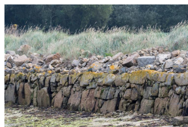
Mur de soutènement avec un travail en couches, sur la rive ouest de l'anse de Pellinec Phot. Charlotte Barraud IVR53_20242200678NUCA
