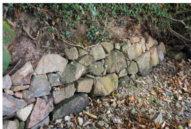
Vue d'un mur de soutènement sur la rive ouest de la baie de l'Enfer Phot. Charlotte Barraud IVR53_20242200703NUCA
