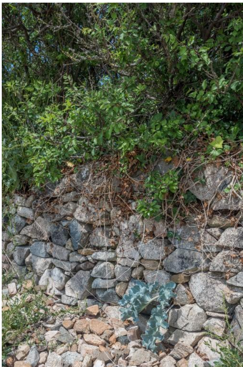
Vue d'une partie d'un mur de soutènement de la plage de Raluzet, sur lequel pousse du chou marin
