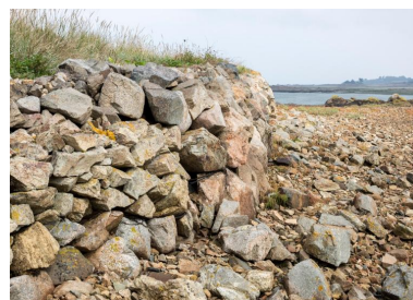
Vue d'un mur en pierre sèche prolongé par un enrochement au niveau de la façade sud du Palud Phot. Charlotte Barraud IVR53_20242200724NUCA
