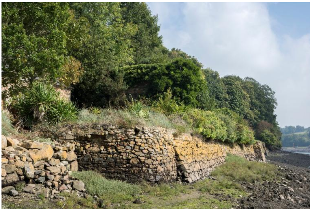
Cale en pierre sèche au fruit prononcé d'un four à chaux, sur la rive ouest du Jaudy
