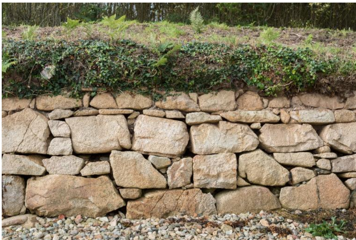
Mur de soutènement avec un travail en couches, sur la rive ouest de l'anse de Pelinec
