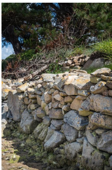
Vue d'une partie d'un mur de soutènement de Buguelès, sur lequel pousse des algues dont de la pelvétie, sur la partie basse de l'ouvrage Phot. Charlotte Barraud IVR53_20242200592NUCA
