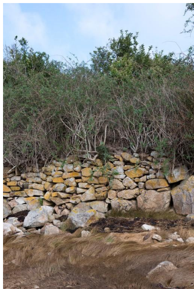
Mur de soutènement aux moellons à l'empilement décalé, au niveau de l'anse de Pellinec Phot. Charlotte Barraud IVR53_20242200692NUCA
