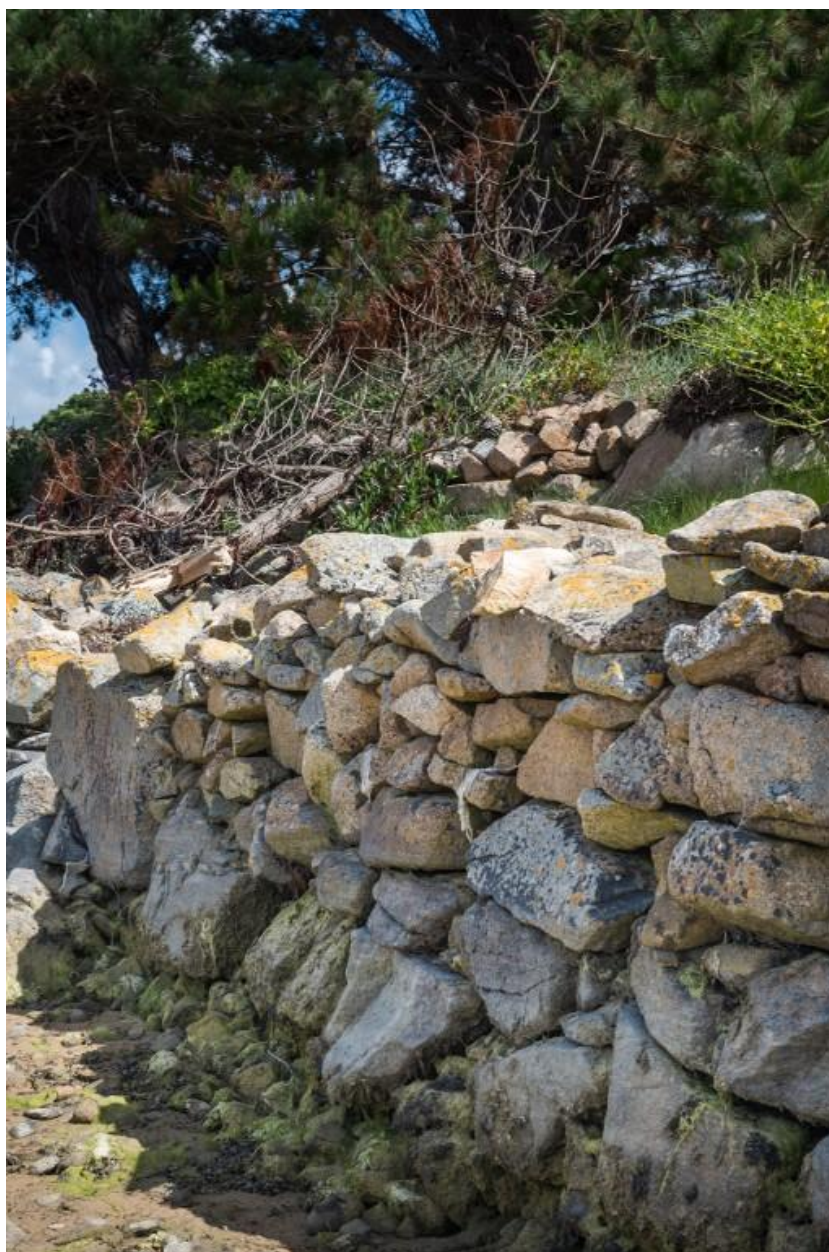
Vue d'une partie d'un mur de soutènement de Buguélès, sur lequel pousse des algues dont de la pelvétie, sur la partie basse de l'ouvrage
