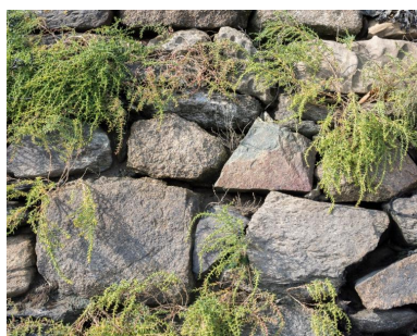
Détail de moellons d'une cale entre lesquels pousse de la soude maritime ( Suaeda maritima ), au niveau du Pont Noir Phot. Charlotte Barraud IVR53_20242200750NUCA
