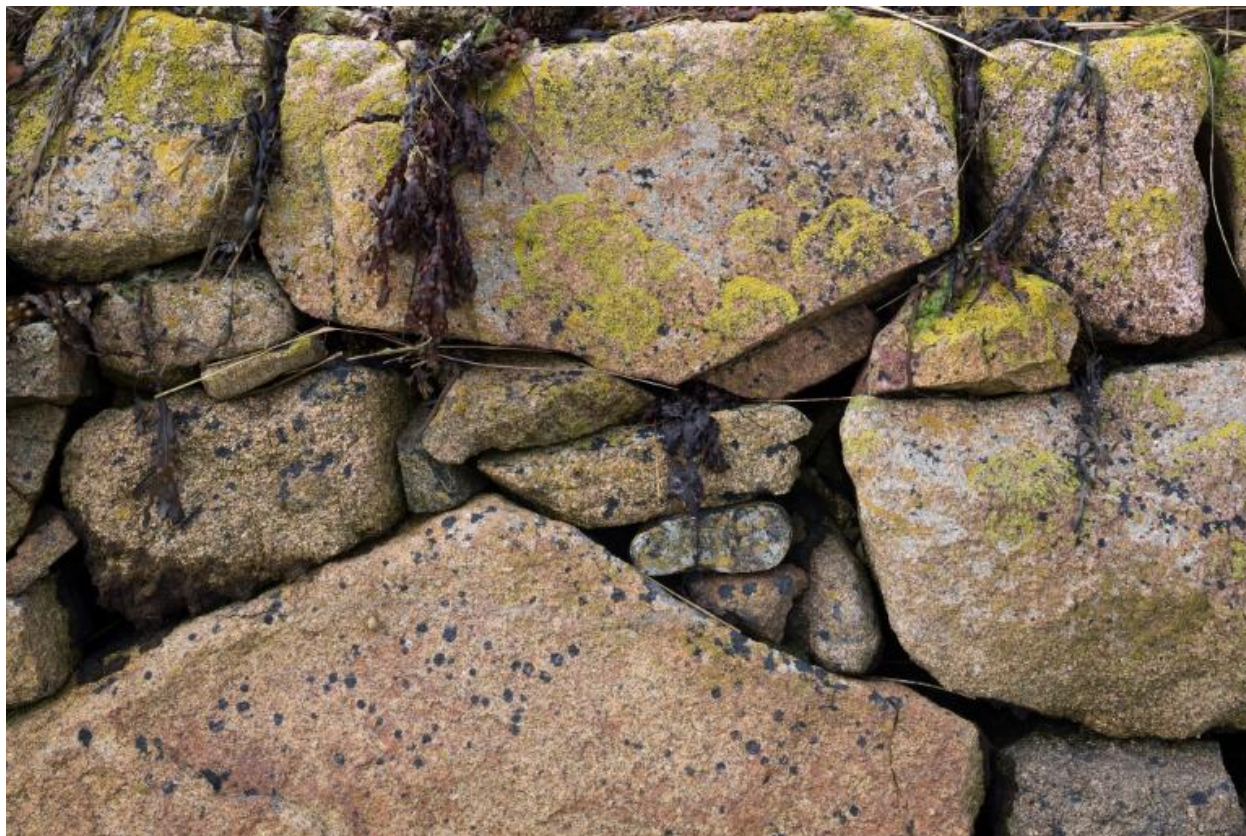
Détail de moellons insérés dans des blocs de granite du mur de soutènement sur la rive ouest de l'anse de Pellinec
