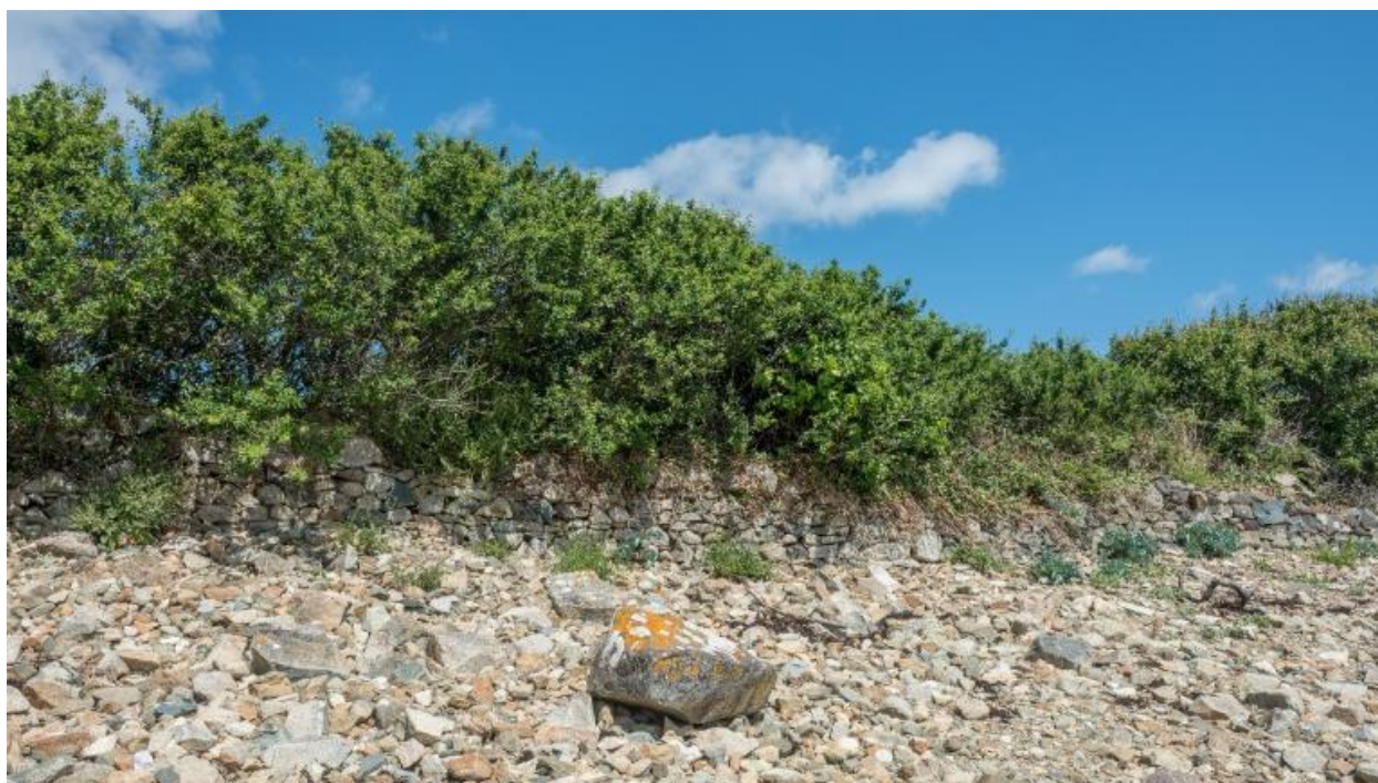
Vue d'ensemble d'un mur de soutènement de la plage d'alluvions de Raluzet, sur laquelle pousse de la bette maritime et du chou marin
