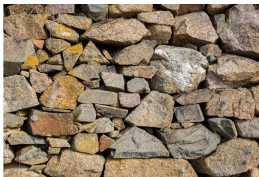
Détail de l'empilement de moellons d'un mur de soutènement de l'anse de Pellinec Phot. Charlotte Barraud IVR53_20242200691NUCA
