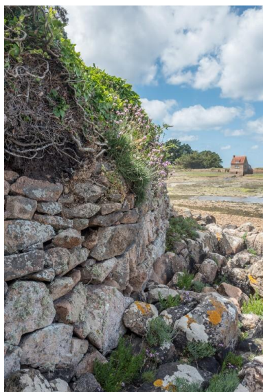
Vue du mur de soutènement orienté Nord sur lequel pousse de l'armérie maritime aux fleurs roses, faisant face au moulin à marées des îles Balanec et Ozac'h Phot. Charlotte Barraud IVR53_20242200581NUCA
