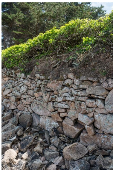
Détail du mur de soutènement à côté du port de Buguélès, comprenant de nombreux petits moellons Phot. Charlotte Barraud IVR53_20242200582NUCA
