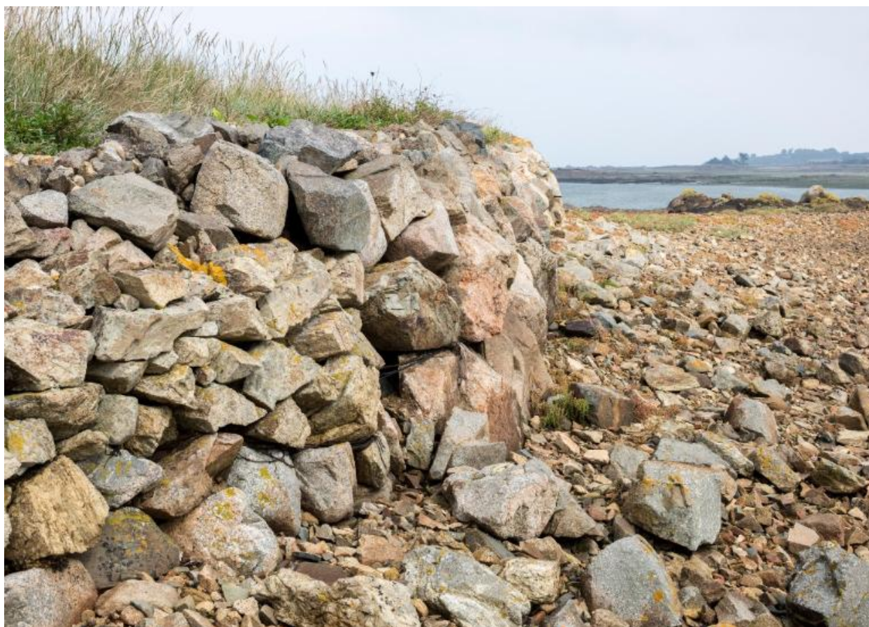
Vue d'un mur en pierre sèche prolongé par un enrochement au niveau de la façade sud du Palud
