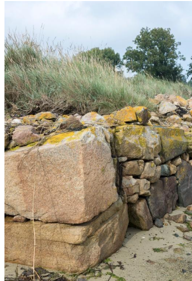
Détail de gros blocs de granite d'un mur de soutènement au fond de l'anse de Pellinec Phot. Charlotte Barraud IVR53_20242200670NUCA
