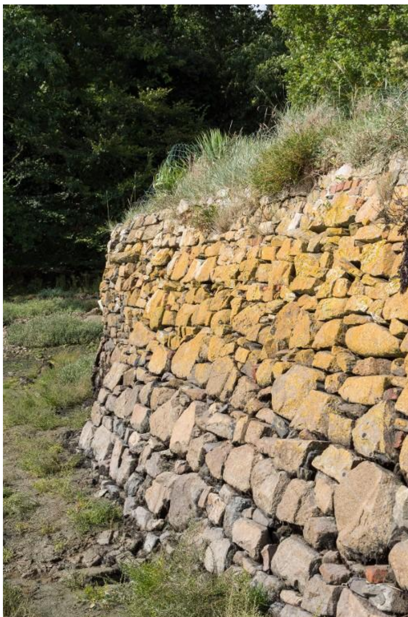
Vue du parement de la cale en pierre sèche avec un fruit prononcé, sur la rive ouest du Jaudy
