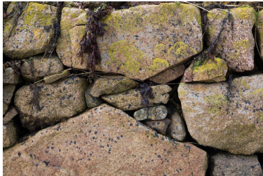
Détail de moellons insérés dans des blocs de granite du mur de soutènement sur la rive ouest de l'anse de Pellinec Phot. Charlotte Barraud IVR53_20242200665NUCA
