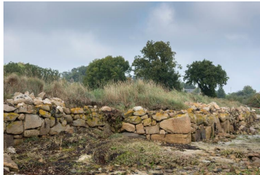
Vue d'ensemble d'un mur de soutènement composé de gros blocs de granite, sur la rive ouest de l'anse de Pellinec Phot. Charlotte Barraud IVR53_20242200668NUCA
