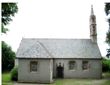
Brest, chapelle Notre-Dame du Bon Port : élévation nord Phot. Gwénaél Fauchille IVR53_20082906010NUCA
