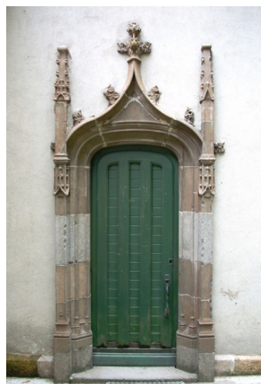
Brest, chapelle Notre-Dame du Bon Port : détail porte nord Phot. Gwénaél Fauchille IVR53_20082906011NUCA
