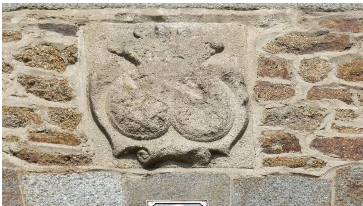
Détails sur la façade est
