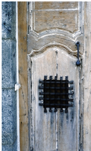
Détail du judas de porte. Phot. Guy Artur, Phot. Norbert Lambart IVR53_19853500421ZA
