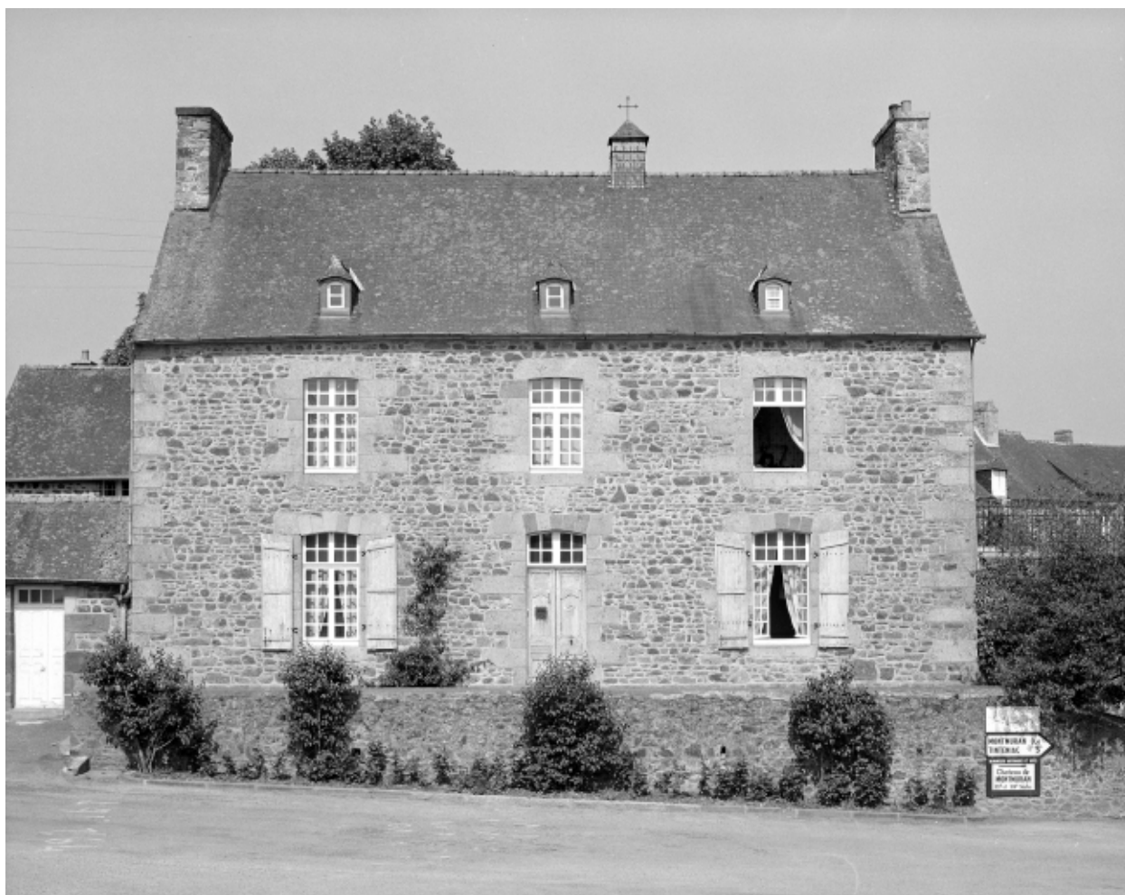
Façade antérieure, vue générale.
