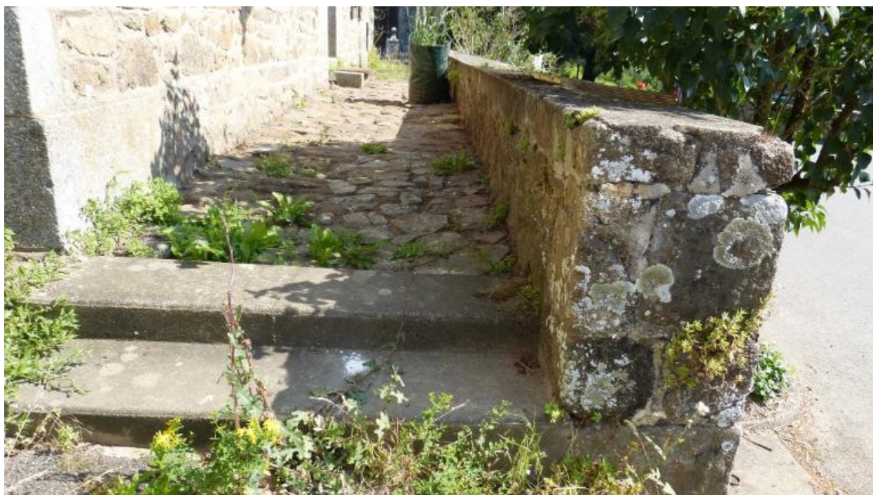
Détails du perron, façade est
