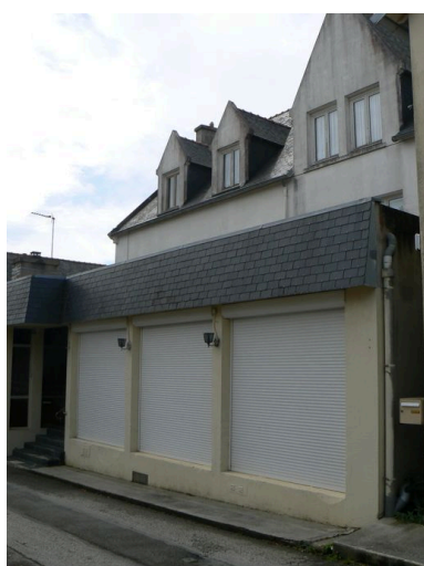
Vue générale de l'hôtel Kreis-Ar-Mor Phot. Lénaïg L'Aot IVR53_20072908918NUCA
