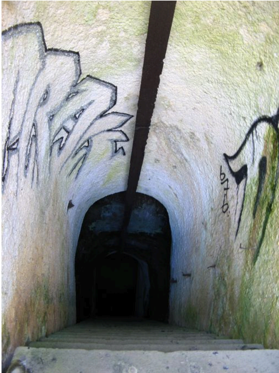
Intérieur du magasin à poudre sous roc des Capucins
