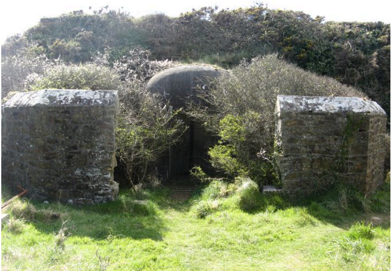
Magasin à poudre sous roc des Capucins
