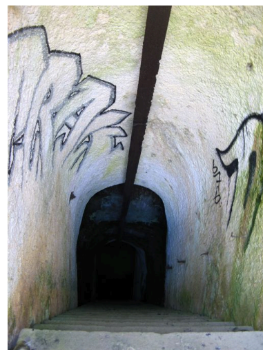
Intérieur du magasin à poudre sous roc des Capucins Phot. Guillaume Marie IVR53_20082908451NUCA
