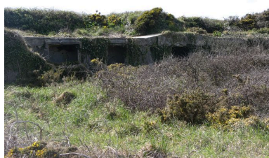
Batterie de 100 mm des Capucins Phot. Guillaume Marie IVR53_20082908453NUCA
