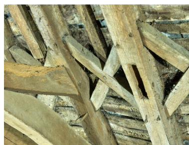
Croix de Saint-André s'intercalant entre chaque ferme. Phot. Bernard Bègne IVR53_20243501222NUCA
