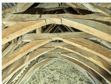
Cette charpente est datée par dendrochronologie de l'automne-hiver 1550-1551. Phot. Bernard Bègne IVR53_20243501221NUCA
