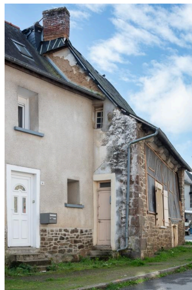
Bâtiment construit en maçonnerie, pan de bois (caché par les bâches) et terre pour les pignons. Phot. Léna Leroy IVR53_20243501365NUCA
