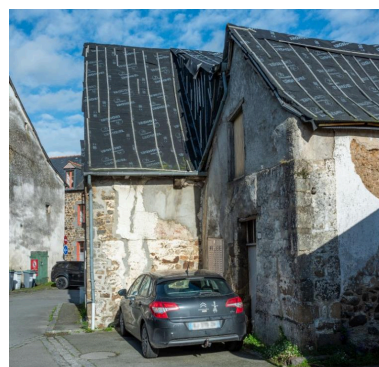
Le bâtiment en extension inclut le pilier d'entrée de la Grande Cour. Phot. Léna Leroy IVR53_20243501374NUCA
