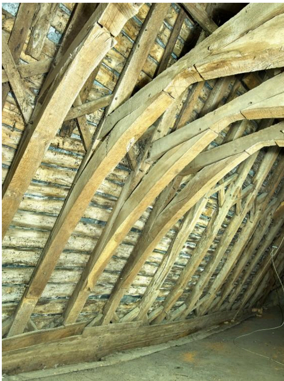
Alignement des fermes de la charpente.
