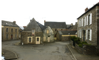
Vue de situation depuis la place André Ferré Phot. Norbert Lambart IVR53_20063501216NUCA
