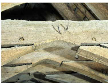
Assemblage en embrèvements des aisseliers. Phot. Bernard Bègne IVR53_20243501223NUCA
