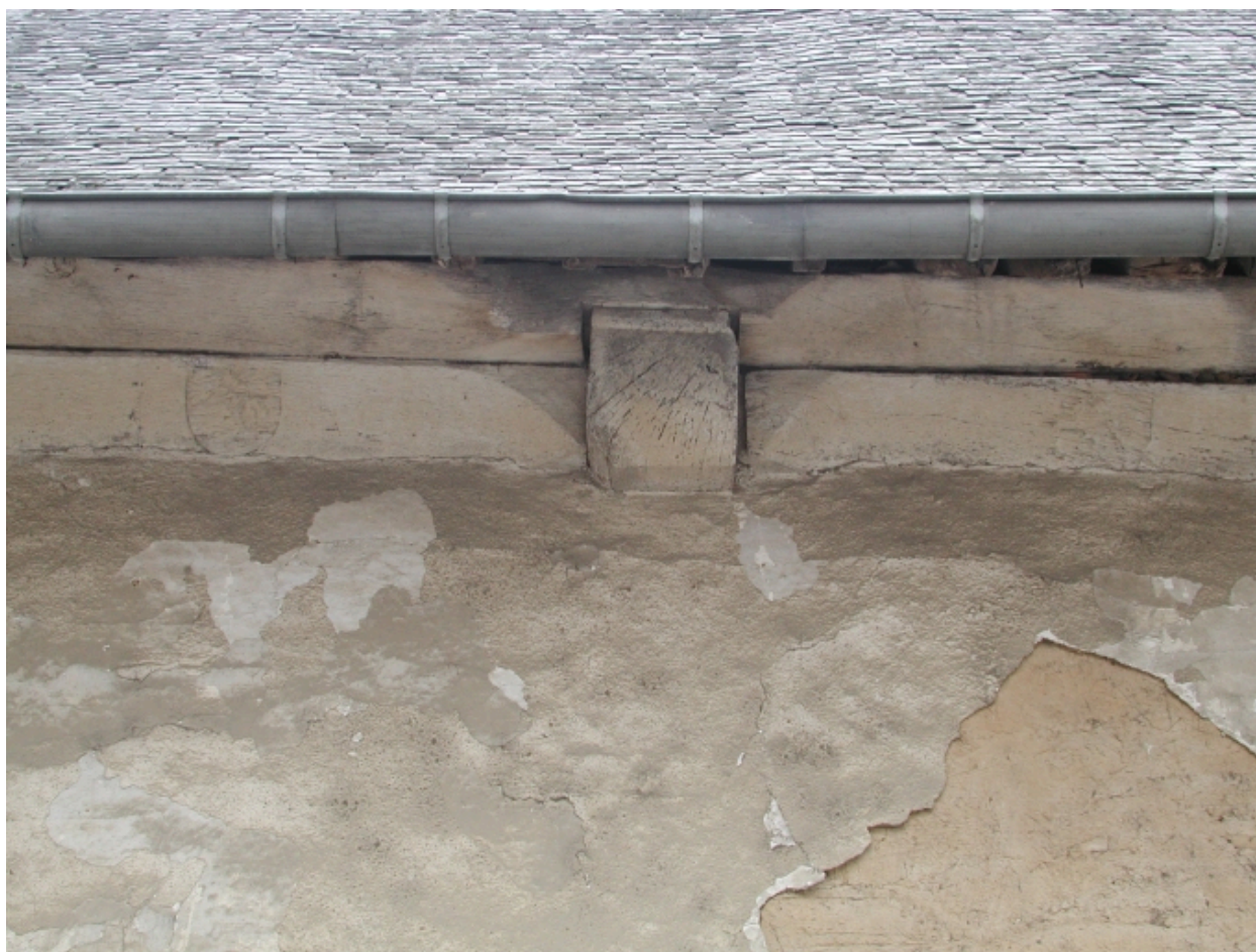
Elévation nord : détail des sablières
