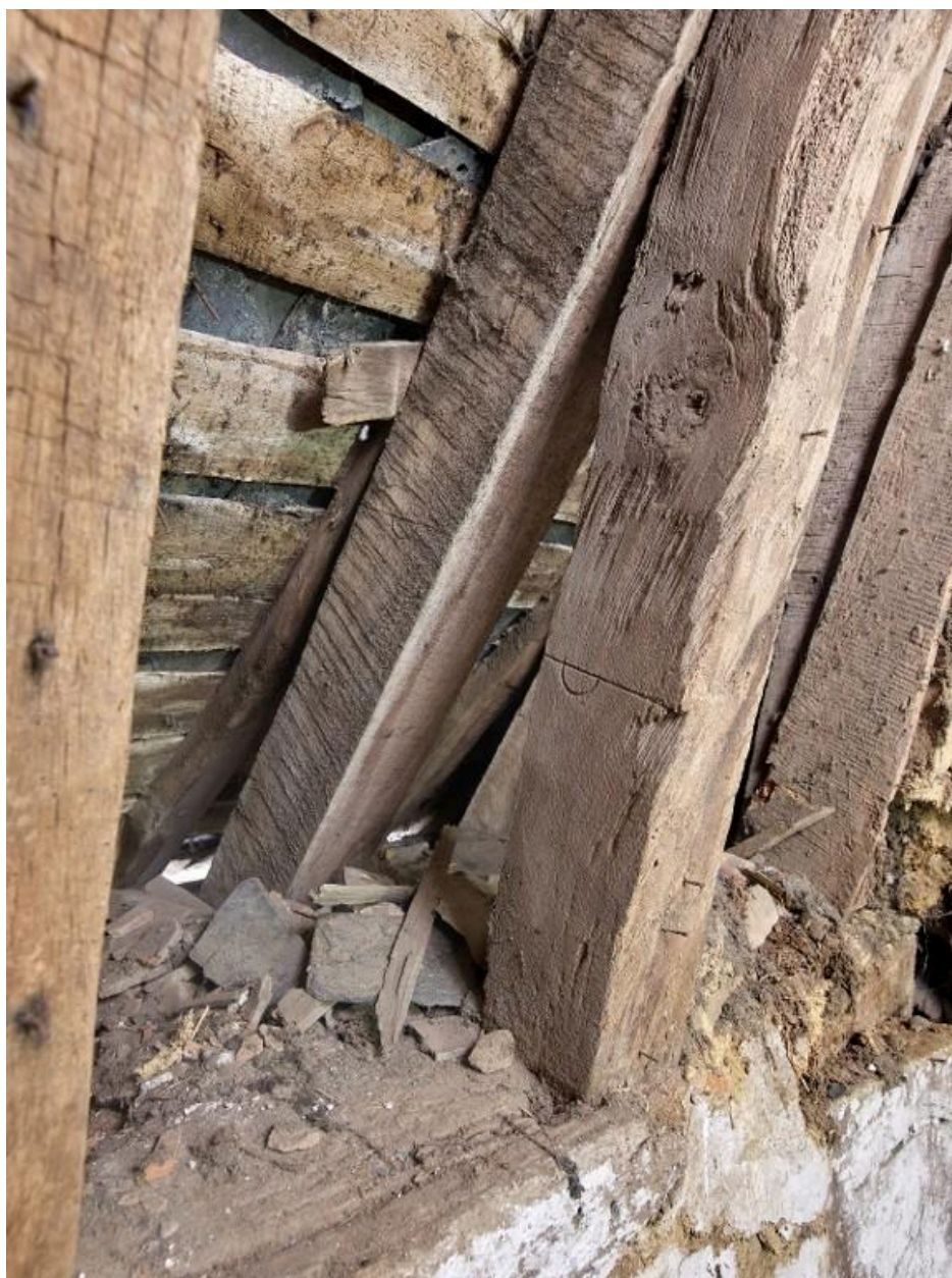
Premier étage, marque d'assemblage sur le bois.
