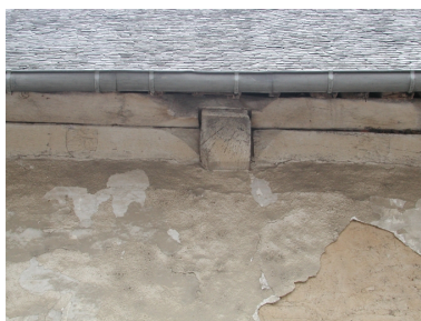
Elévation nord : détail des sablières Phot. Elise Lauranceau IVR53_20063511951NUCA
