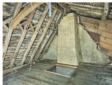
Modification partielle de la charpente bien visible au niveau du pignon. Phot. Bernard Bègne IVR53_20243501219NUCA
