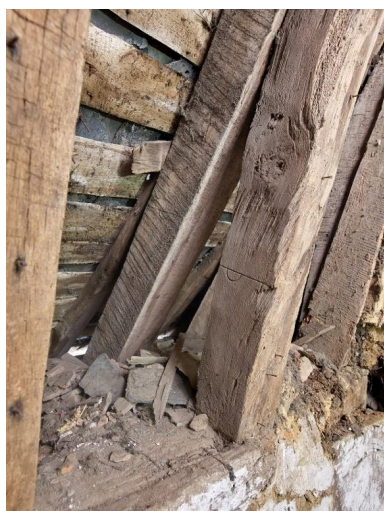
Premier étage, marque d'assemblage sur le bois. Phot. Bernard Bègne IVR53_20243501210NUCA
