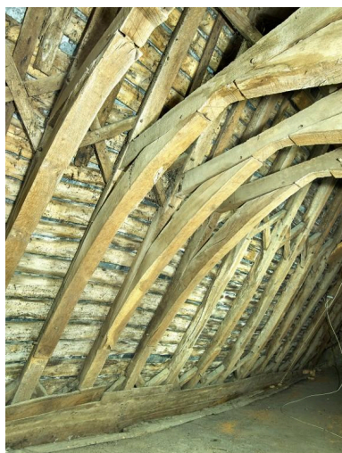
Alignement des fermes de la charpente. Phot. Bernard Bègne IVR53_20243501224NUCA
