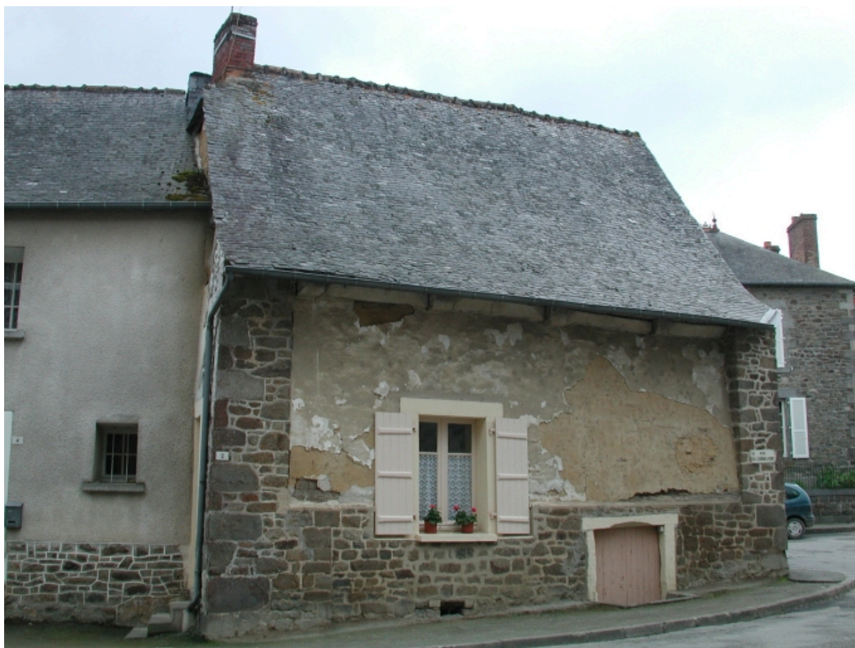
Elévation nord : vue générale
