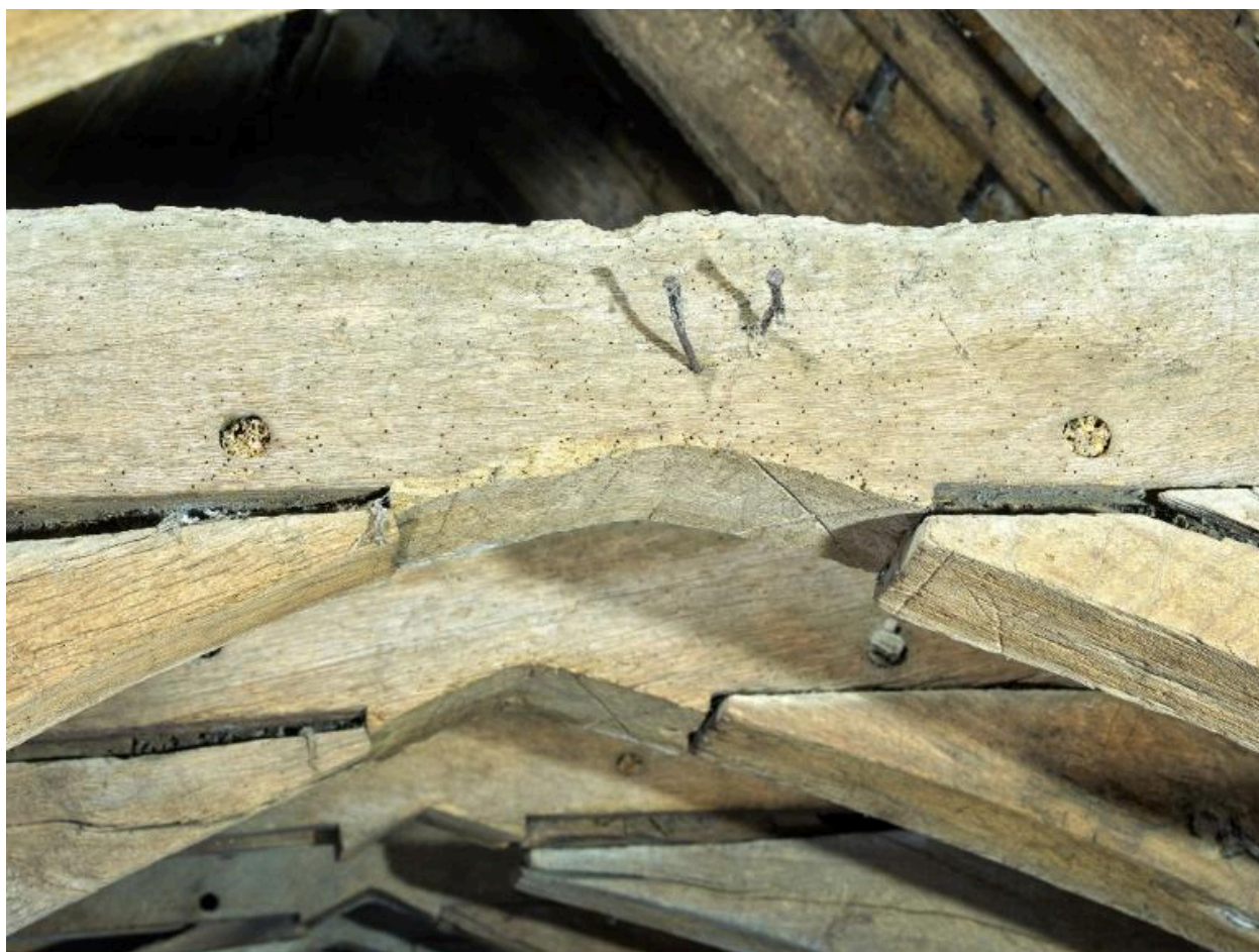
Assemblage en embrèvements des aisseliers.
