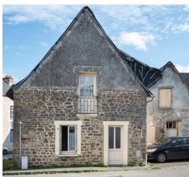
Pignon ouest en pierres et terre, initialement sans ouvertures. Phot. Léna Leroy IVR53_20243501371NUCA
