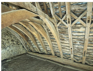
Rupture entre les fermes conservées et celles qui ont partiellement disparu. Phot. Bernard Bègne IVR53_20243501217NUCA
