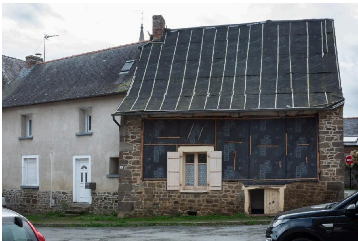
Façade nord de ce bâtiment daté du milieu du 16e siècle par dendrochronologie.
