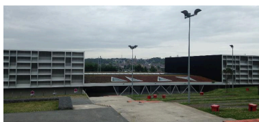
Vue générale prise du sud Phot. Simon Vely IVR53_20162206742NUCA
