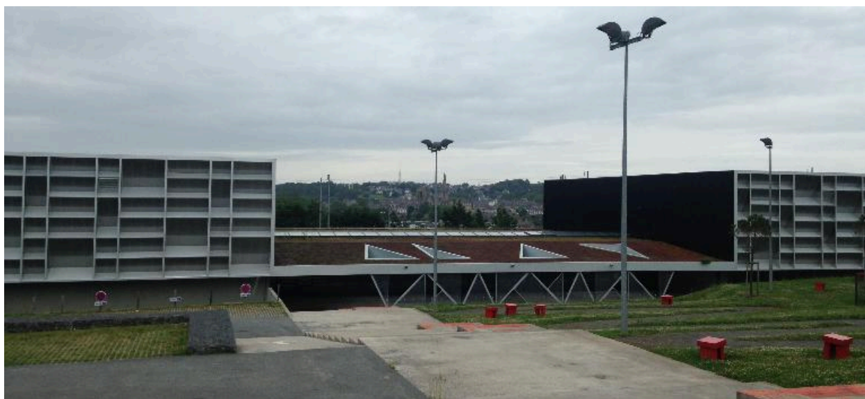
Vue générale prise du sud
