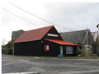
Vue d'ensemble de la Maison des Plaisanciers Phot. Françoise Péron IVR53_20062908386NUCA
