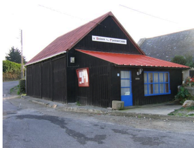
Elévation latérale de la Maisons des Plaisanciers avec appentis Phot. Guillaume Marie IVR53_20062908502NUCA
