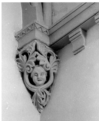
Intérieur, bras Nord du transept : détail du culot et de la corniche.
