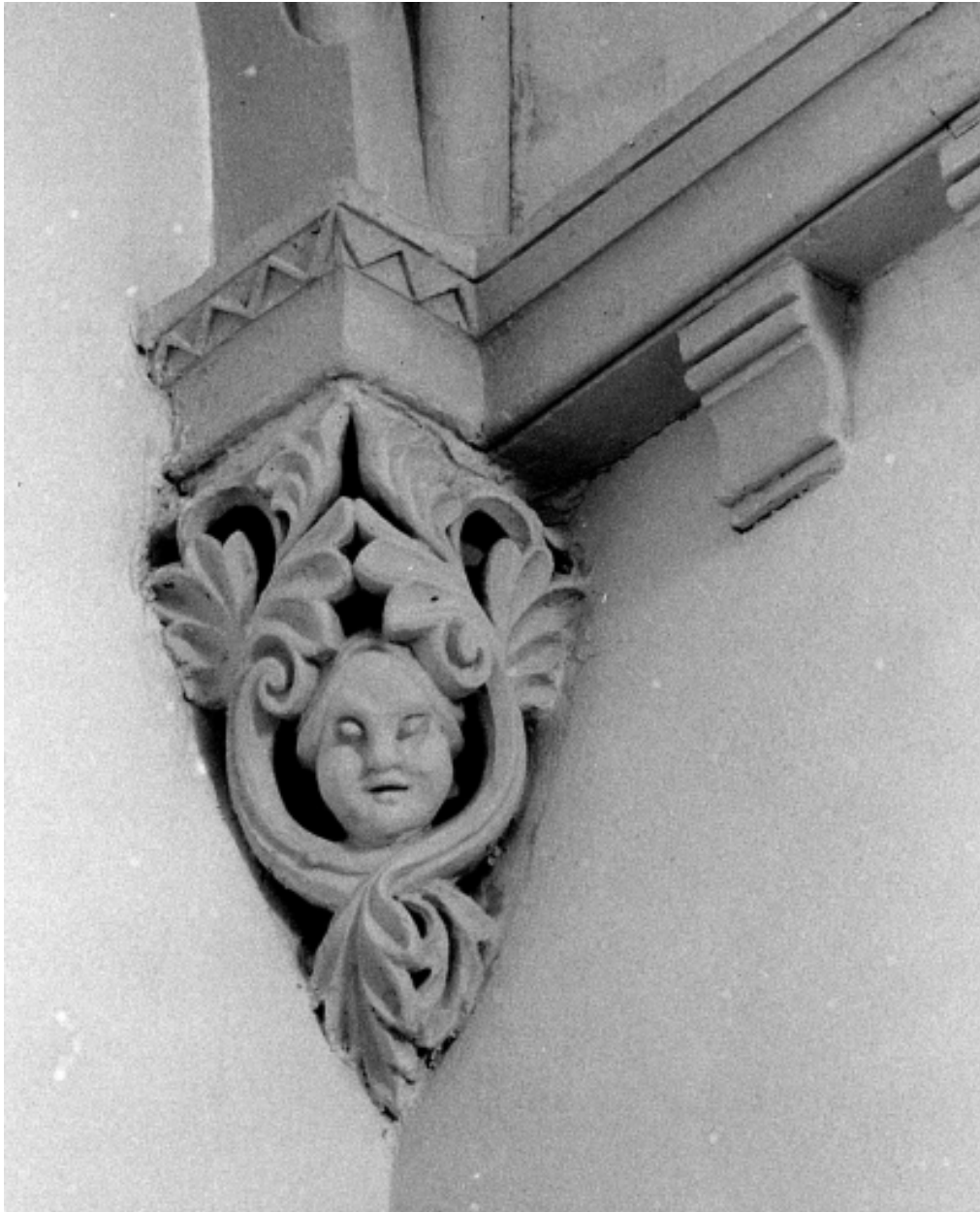
Intérieur, bras Nord du transept : détail du culot et de la corniche.
