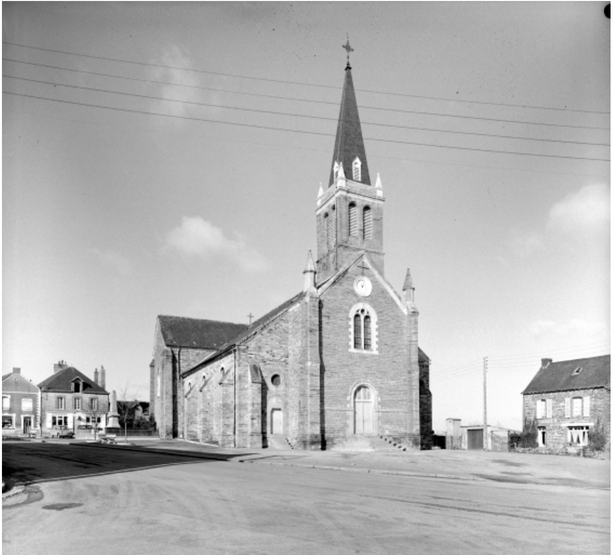
Elévation Nord-Ouest : vue générale
