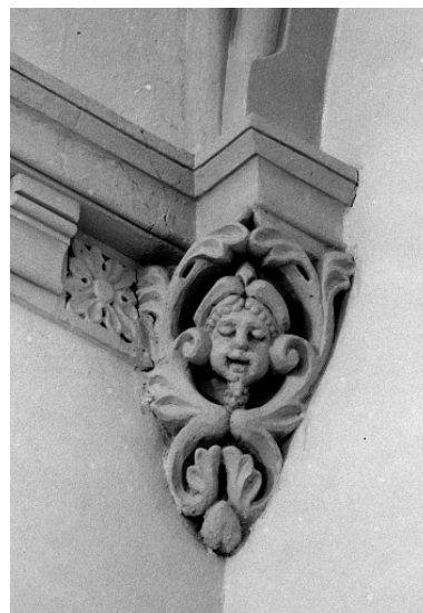
Intérieur, bras Sud du transept : détail du culot et de la corniche. Phot. Guy Artur, Phot. Norbert Lambart IVR53_19703500116V
