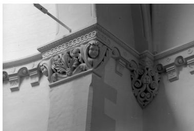
Intérieur, chapiteau et culot du choeur : vue générale. Phot. Guy Artur, Phot. Norbert Lambart IVR53_19703500103V
