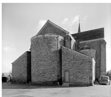
Elévation Est : vue générale Phot. Guy Artur, Phot. Norbert Lambart IVR53_19703500120V
