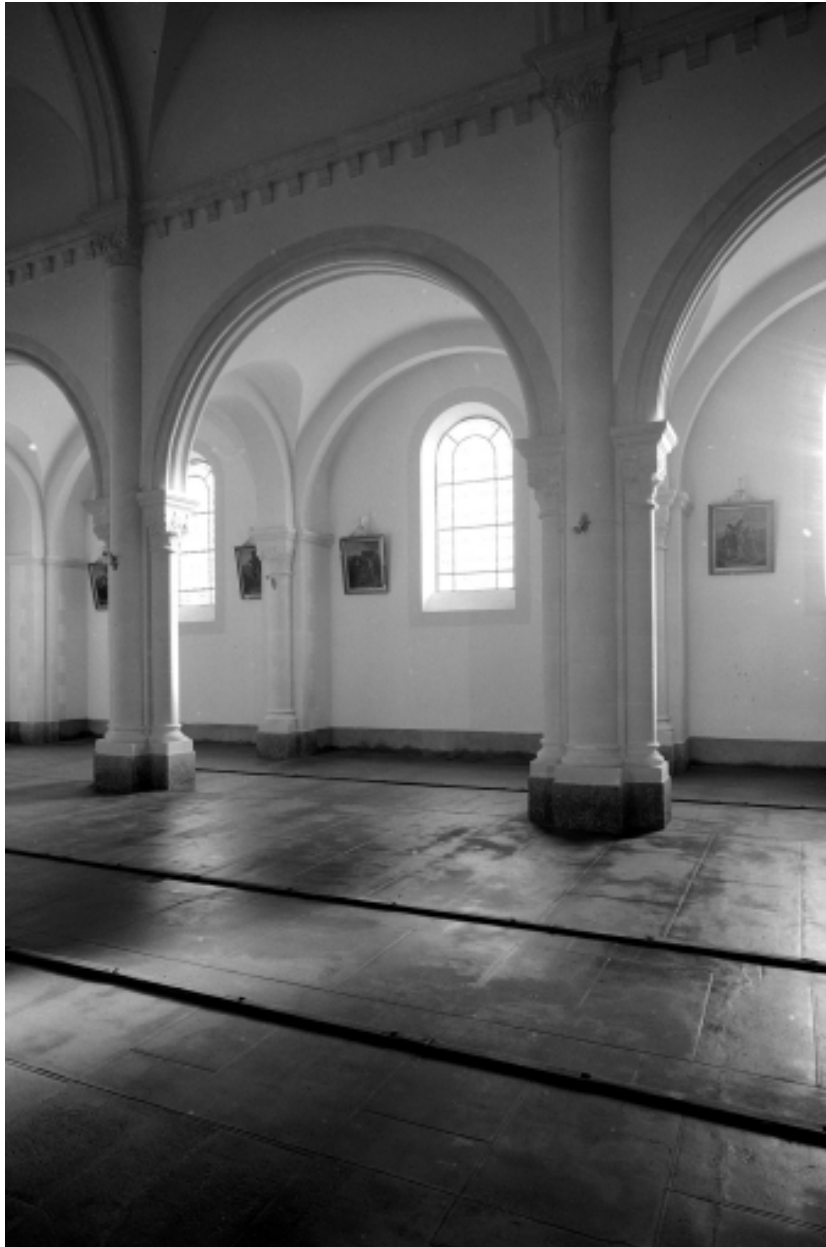
Intérieur, nef, bas-côté Nord : vue Nord-Ouest.
