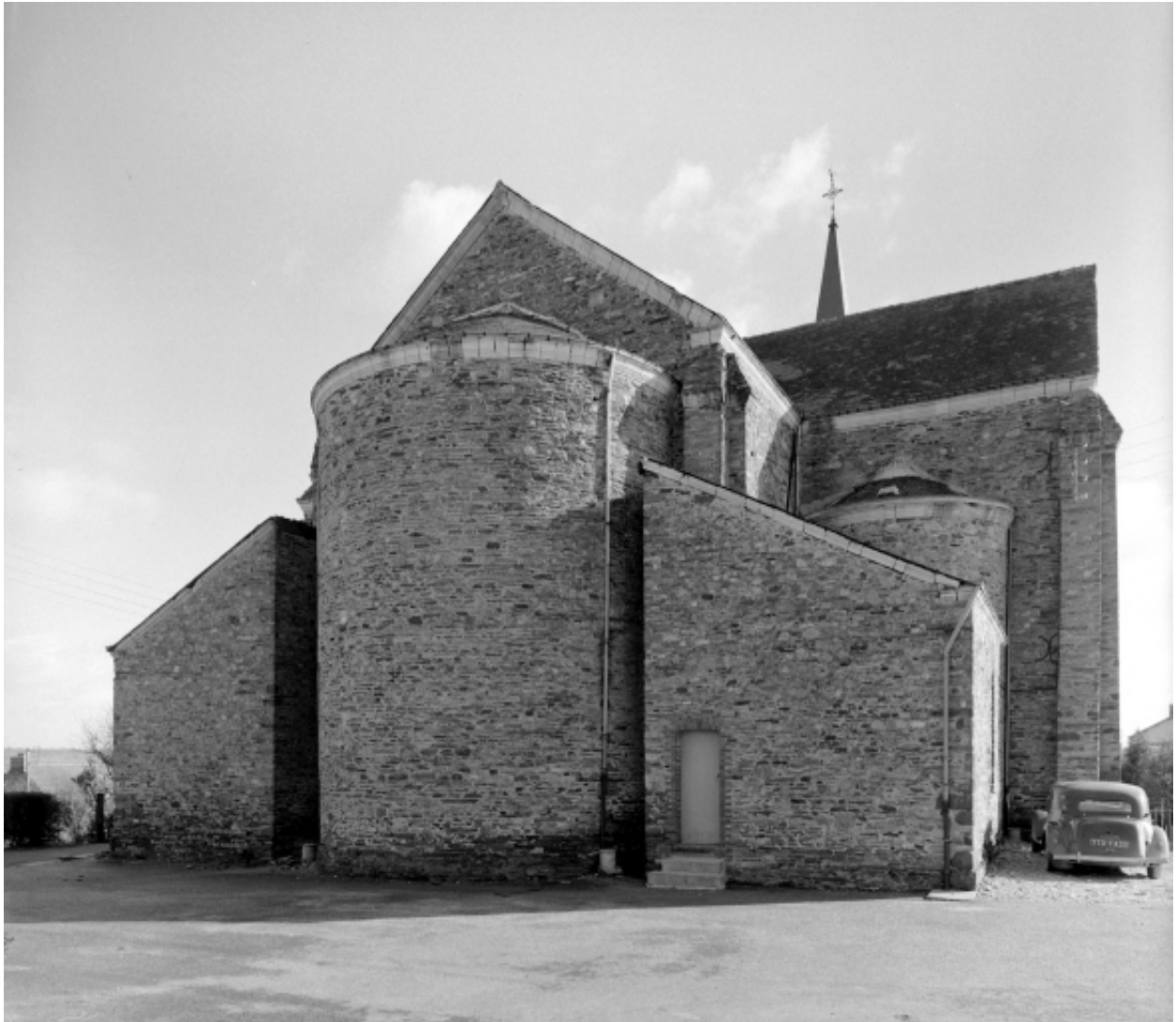
Elévation Est : vue générale
