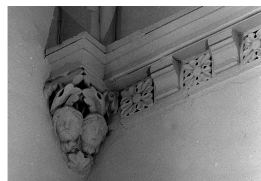
Intérieur détail du culot et de la corniche. Phot. Auteur inconnu IVR53_19703500114V
