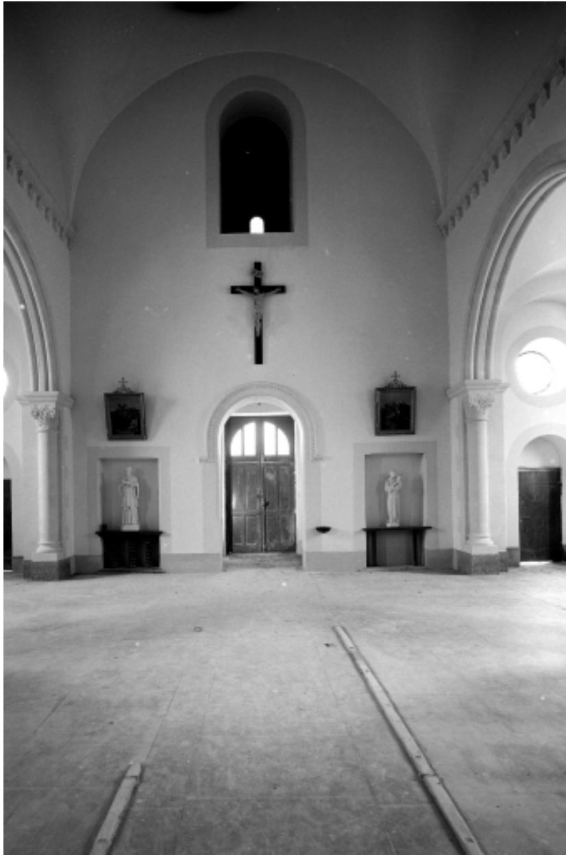
Intérieur, nef, mur ouest : vue générale.
