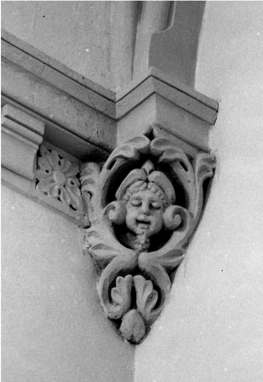
Intérieur, bras Sud du transept : détail du culot et de la corniche.
