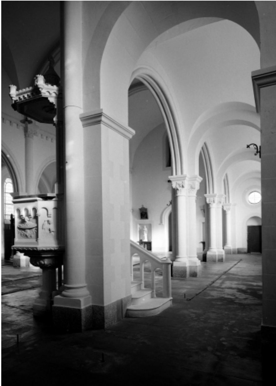
Intérieur, nef, bas-côté Nord : vue Nord-Est.
