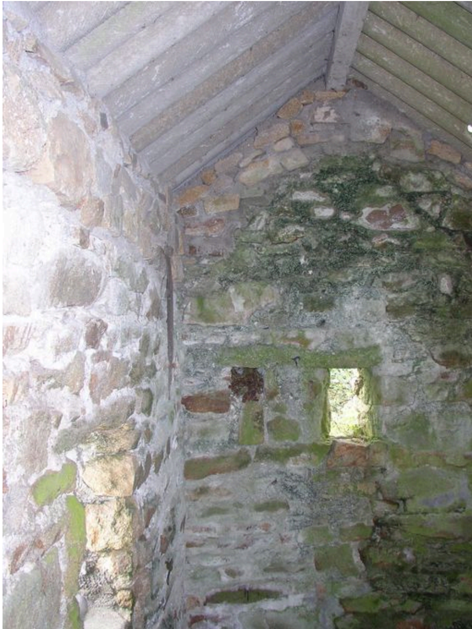
Intérieur de la guérite de douaniers de La Garenne
