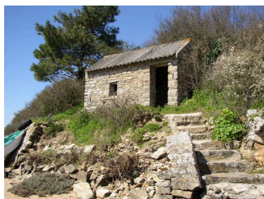
Vue générale de la guérite de douaniers de La Garenne Phot. Johan Vincent IVR53_20065606610NUCA
