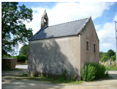
Plouigneau, chapelle Saint-Divy : vue générale sud-est Phot. Gwénaél Fauchille IVR53_20082906644NUCA
