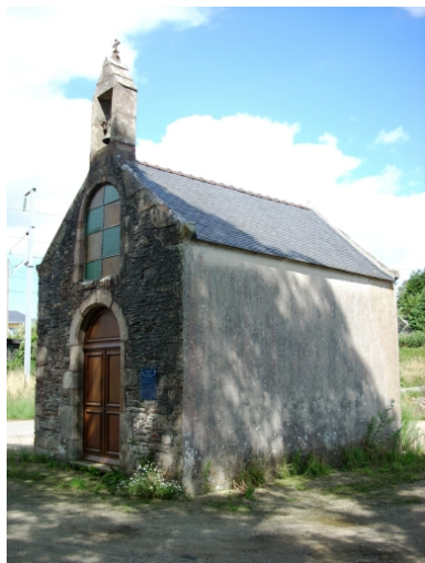
Plouigneau, chapelle Saint-Divy : vue générale sud-ouest Phot. Gwénaél Fauchille IVR53_20082906643NUCA
