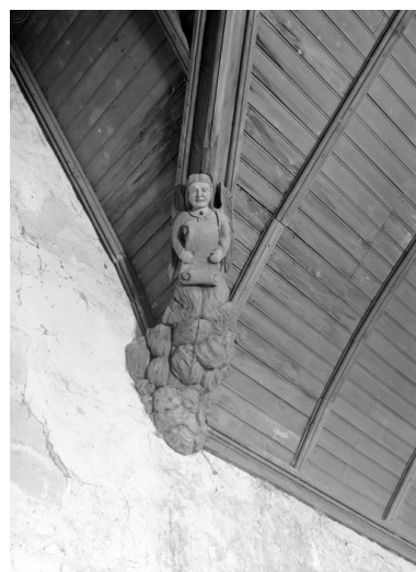
Bas-côté nord, corbelet à l'est de la baie centrale. Phot. François Dagorn IVR53_19675600083V
