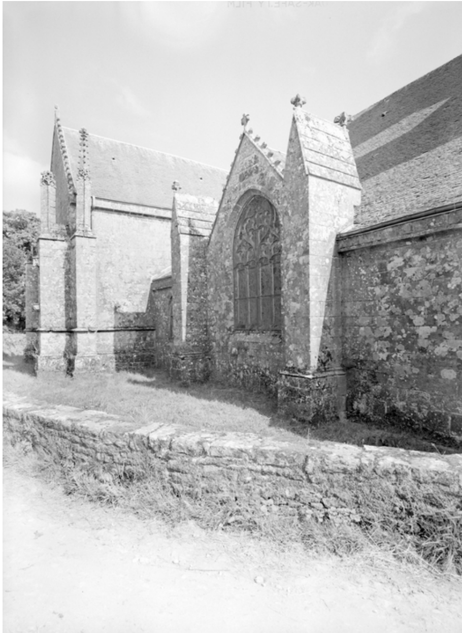
Façade nord, partie centrale.
