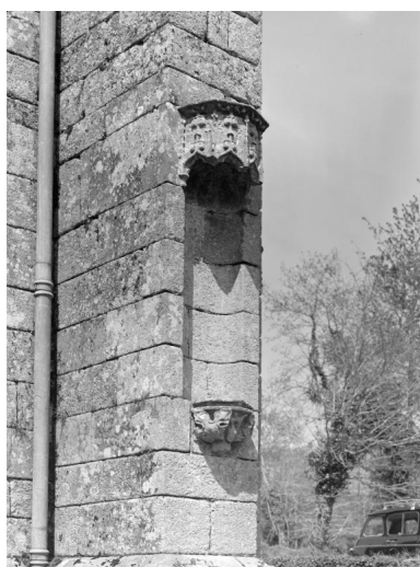
Niche du contrefort de l'angle sud-est du choeur (perpendiculaire au mur sud). Phot. François Dagorn IVR53_19675600397V
