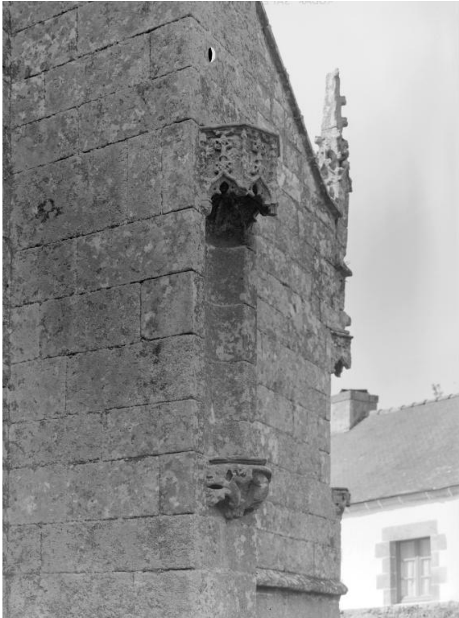
Niche du contrefort médian du mur est du choeur.
