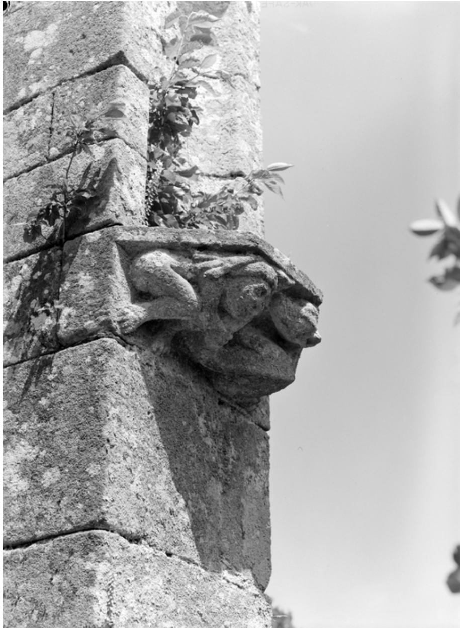
Façade sud, pignon du croisillon, détail du contrefort sud (angle sud-est), console de la niche.
