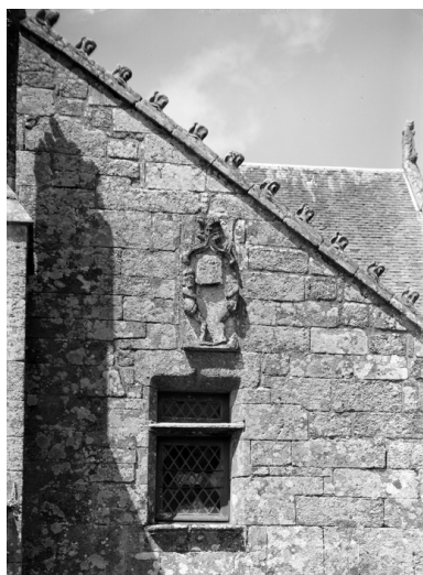
Sacristie, face est, fenêtre du premier étage. Phot. François Dagorn IVR53_19665600165V
