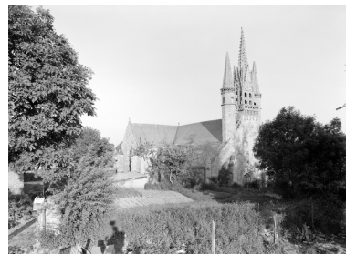
Vue générale prise du nord-ouest. Phot. François Dagorn IVR53_19705600023V
