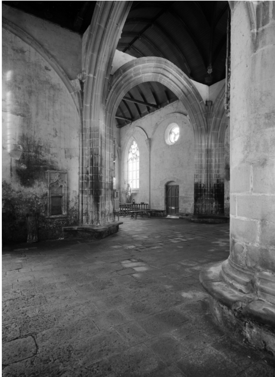
Vue générale de la croisée du transept.
