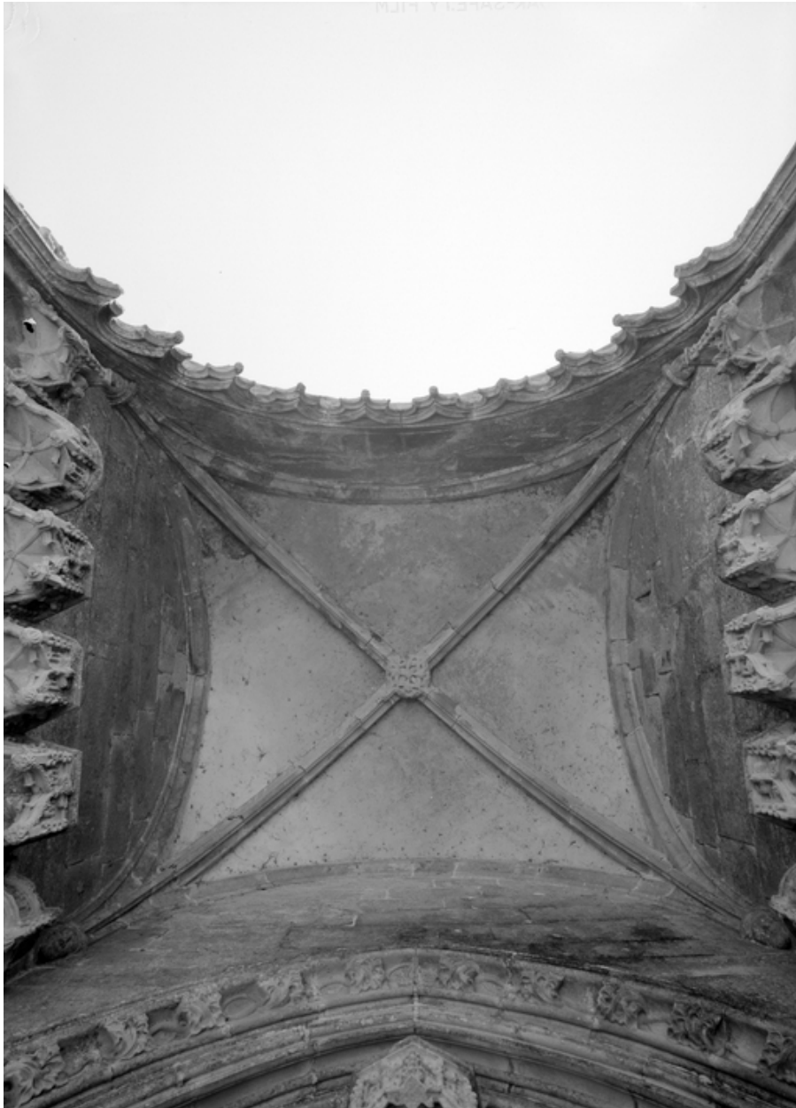
Porche, vue axiale de la voûte.
