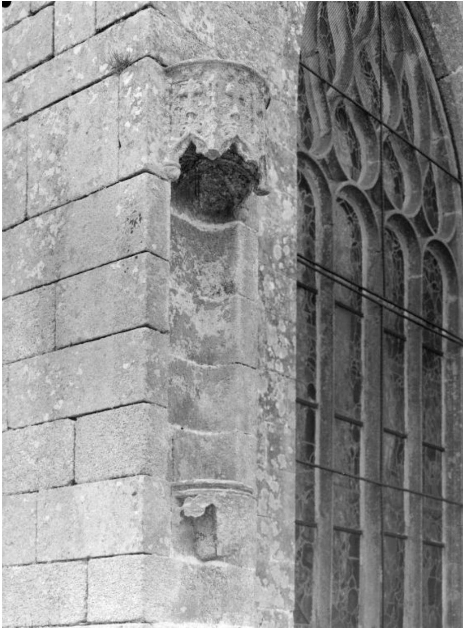
Niche du contrefort de l'angle sud-est du choeur (perpendiculaire au mur est).
