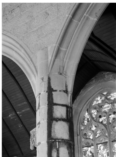
Retombée des arcades sur la pile de la nef. Phot. François Dagorn IVR53_19705600010V
