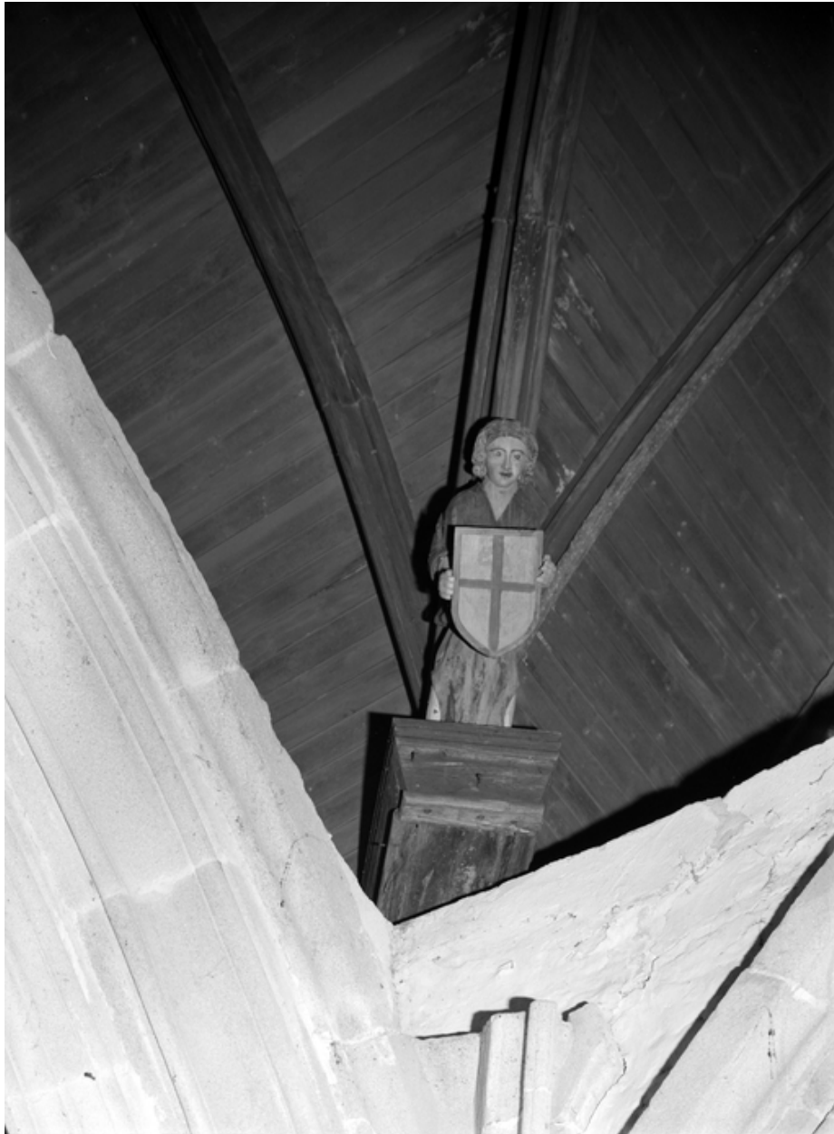
Croisée du transept, lambris, corbelet sud-est.
