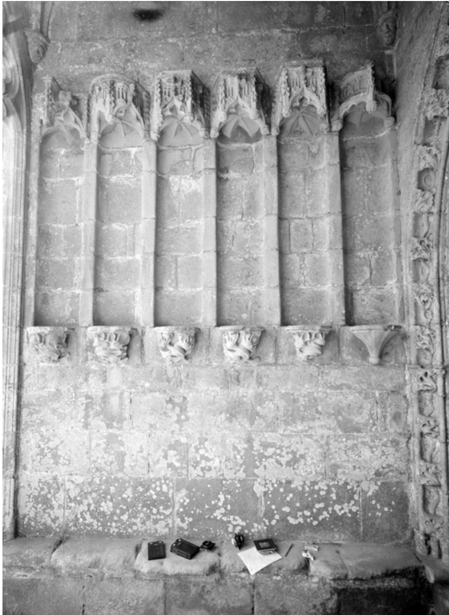
Porche sud, niches à dais du mur ouest.
