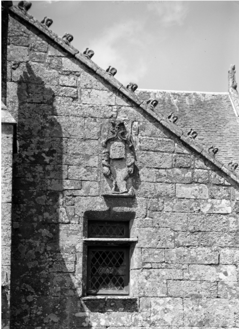
Sacristie, face est, fenêtre du premier étage.
