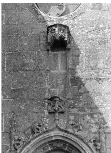
Niche du mur sud du choeur. Phot. François Dagorn IVR53_19675600396V
