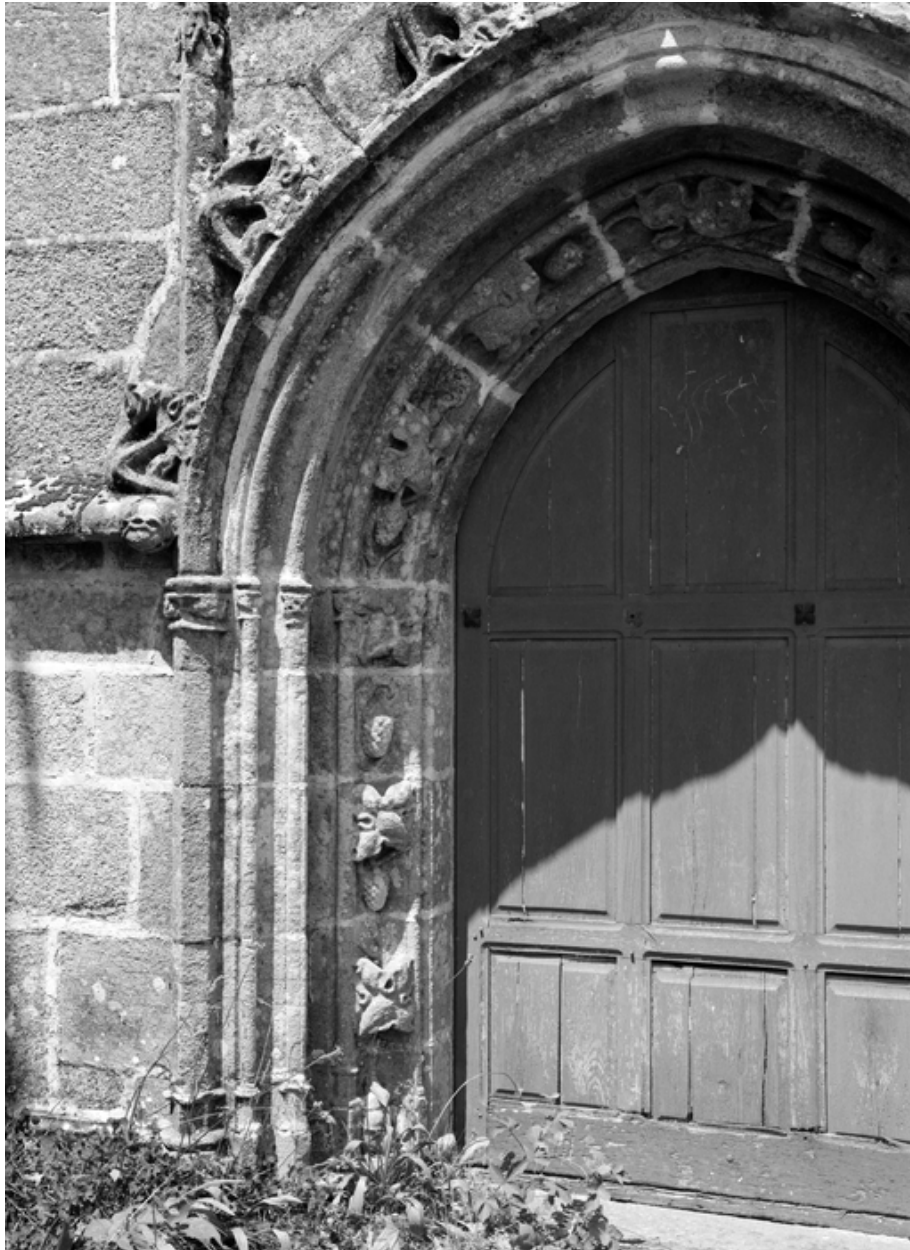
Porte du mur sud du choeur, détail de l'ébrasement ouest.
