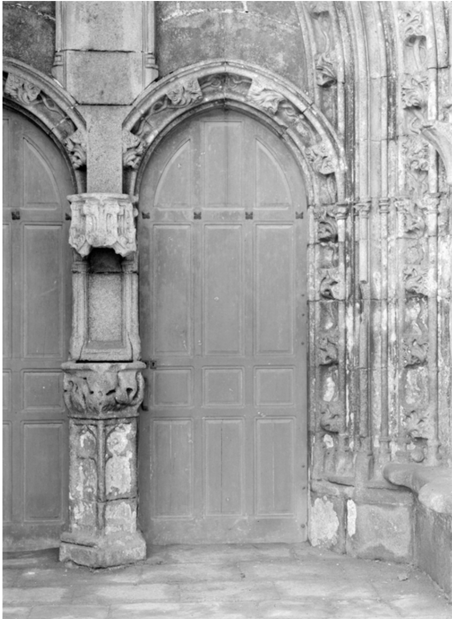
Portail du mur nord du porche sud, partie est.
