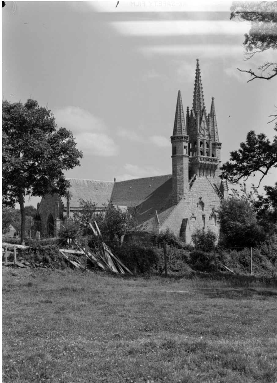
Vue générale prise du nord-ouest.
