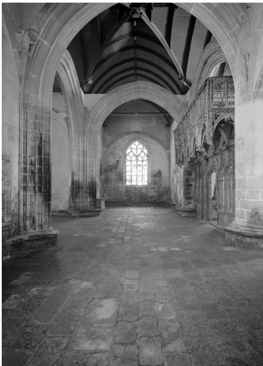
Vue générale du transept vers le sud.
