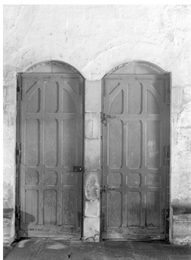
Mur sud de la nef, portes ouvrant sur le porche. Phot. François Dagorn IVR53_19705600012V
