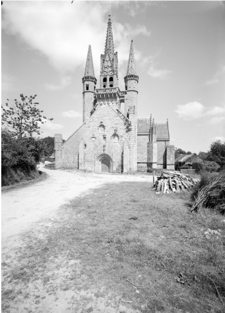
Façade ouest, vue générale.
