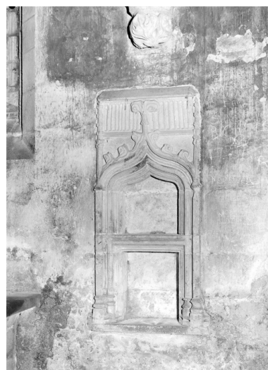
Croisillon sud, mur est, crédence. Phot. François Dagorn IVR53_19665600175V
