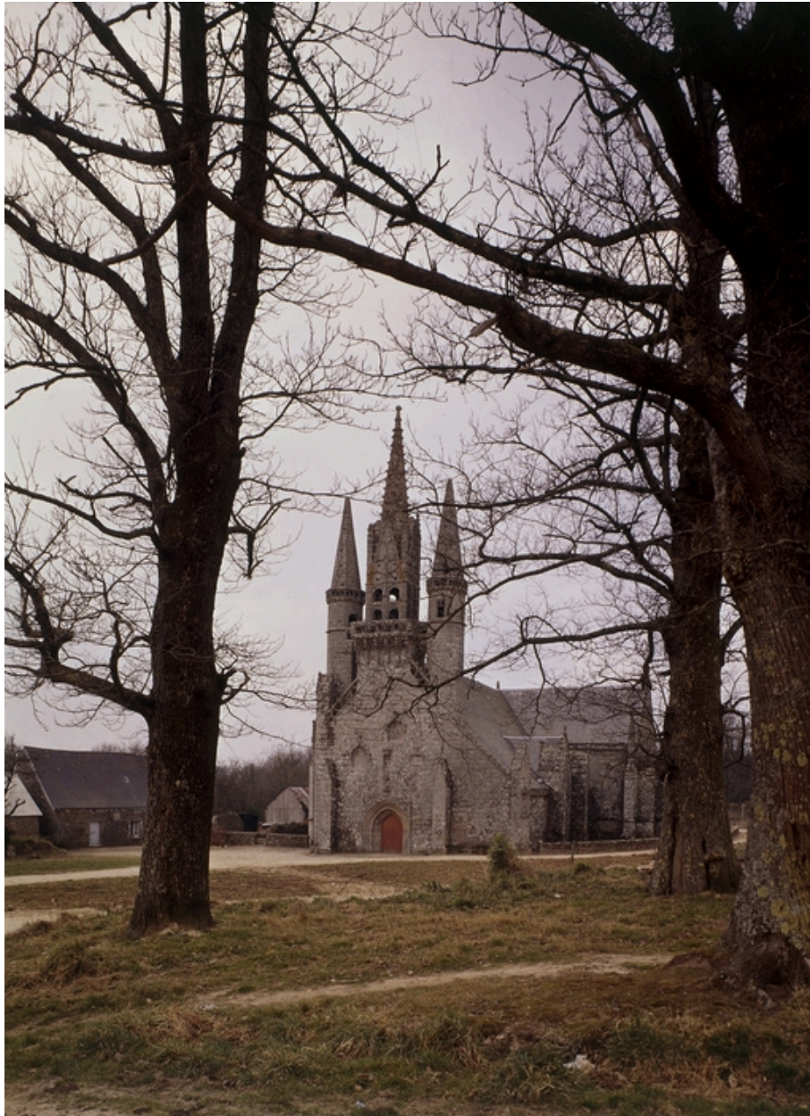
Vue générale prise de nord-ouest.
