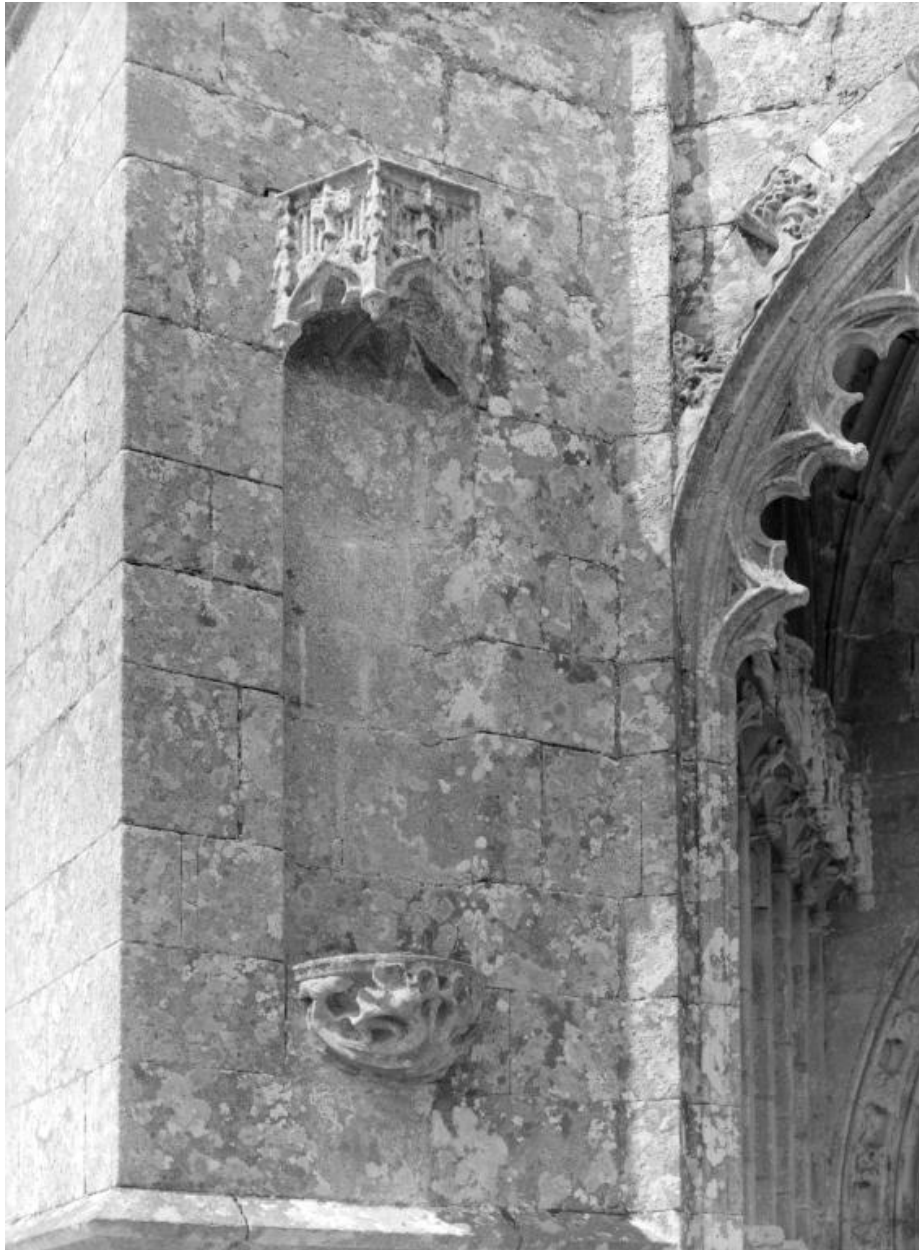
Niche du contrefort sud-ouest du porche sud.
