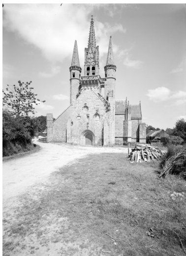
Façade ouest, vue générale. Phot. François Dagorn IVR53_19665600168V
