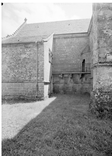
Façade nord, ancienne coursière entre l'oratoire supérieur et la tour d'escalier du bras nord. Phot. François Dagorn IVR53_19665600170V
