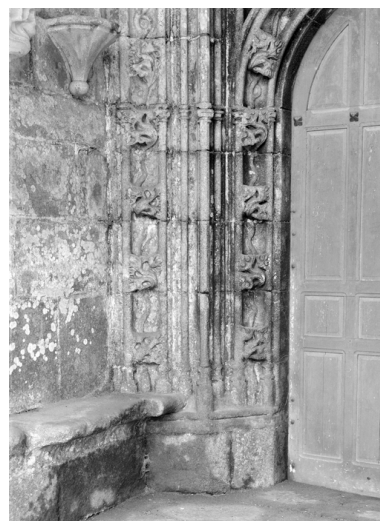
Portail du mur nord du porche sud, détail de l'ébrasement ouest. Phot. François Dagorn IVR53_19705600005V
