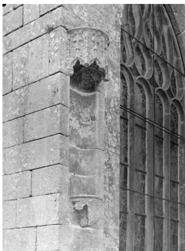
Niche du contrefort de l'angle sud-est du choeur (perpendiculaire au mur est). Phot. François Dagorn IVR53_19675600398V
