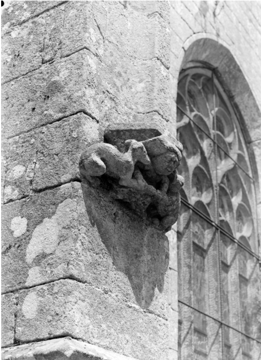
Façade sud, pignon du croisillon, détail du contrefort sud, angle sud-ouest, console de la niche.
