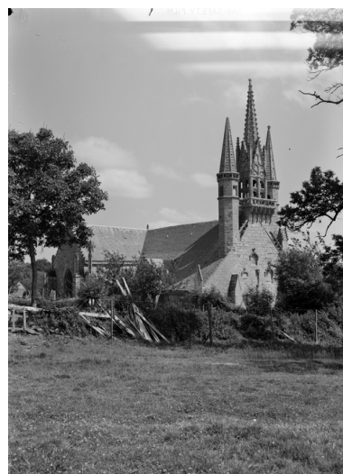
Vue générale prise du nord-ouest. Phot. François Dagorn IVR53_19665600167V
