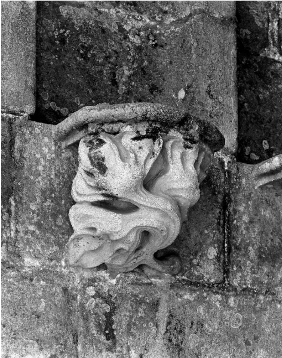
Porche sud, mur ouest, détail d'un culot sculpté.
