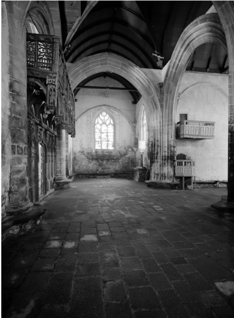
Vue générale du croisillon nord.
