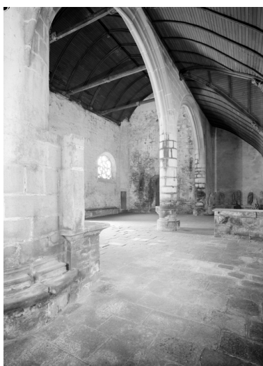
Vue générale vers l'ouest prise du bas-côté sud. Phot. François Dagorn IVR53_19665600185V
