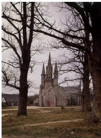
Vue générale prise de nord-ouest. Phot. François Dagorn IVR53_19735600020VA
