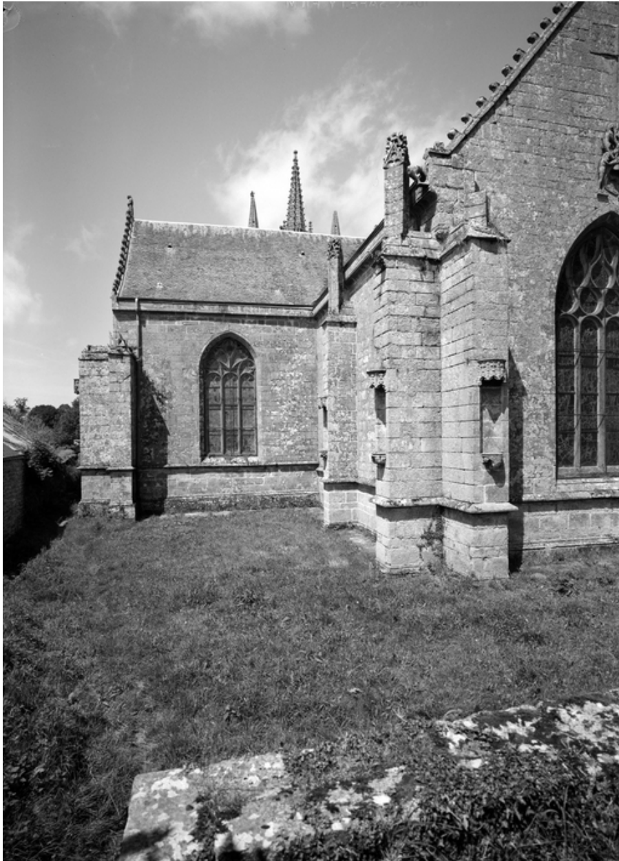
Façade sud, prise du sud-est.
