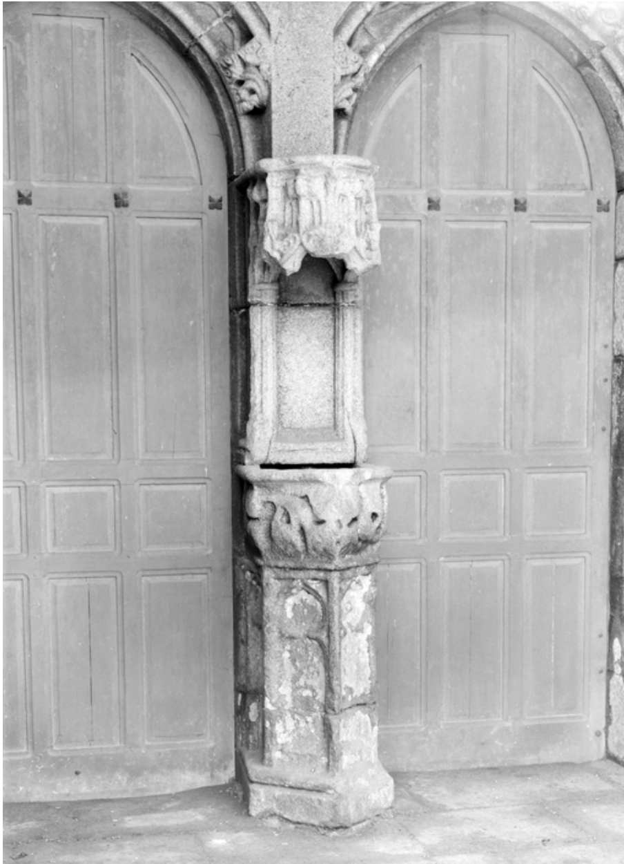
Portail du mur nord du porche sud, bénitier sur le trumeau.
