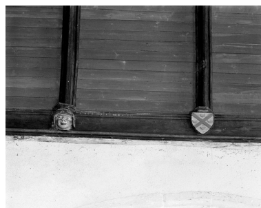
Fragment de sablière du mur nord du choeur (partie gauche). Phot. François Dagorn IVR53_19705600098X
