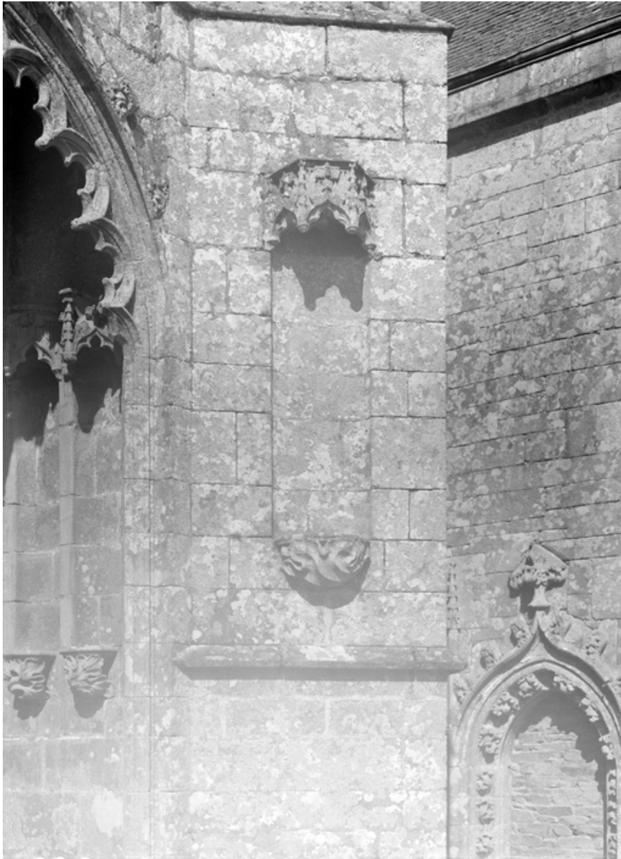
Niche du contrefort sud-est du porche sud.
