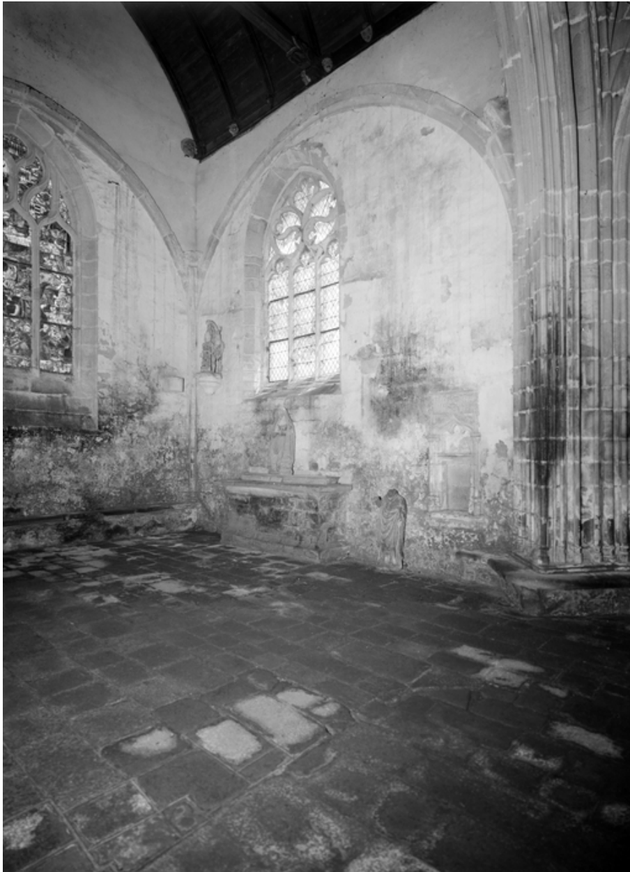
Mur est du bras du transept nord.
