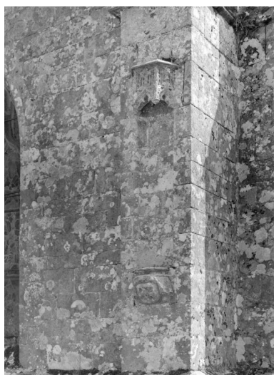
Niche du contrefort nord-ouest du bras du transept nord (perpendiculaire au mur nord). Phot. François Dagorn IVR53_19675600400V
