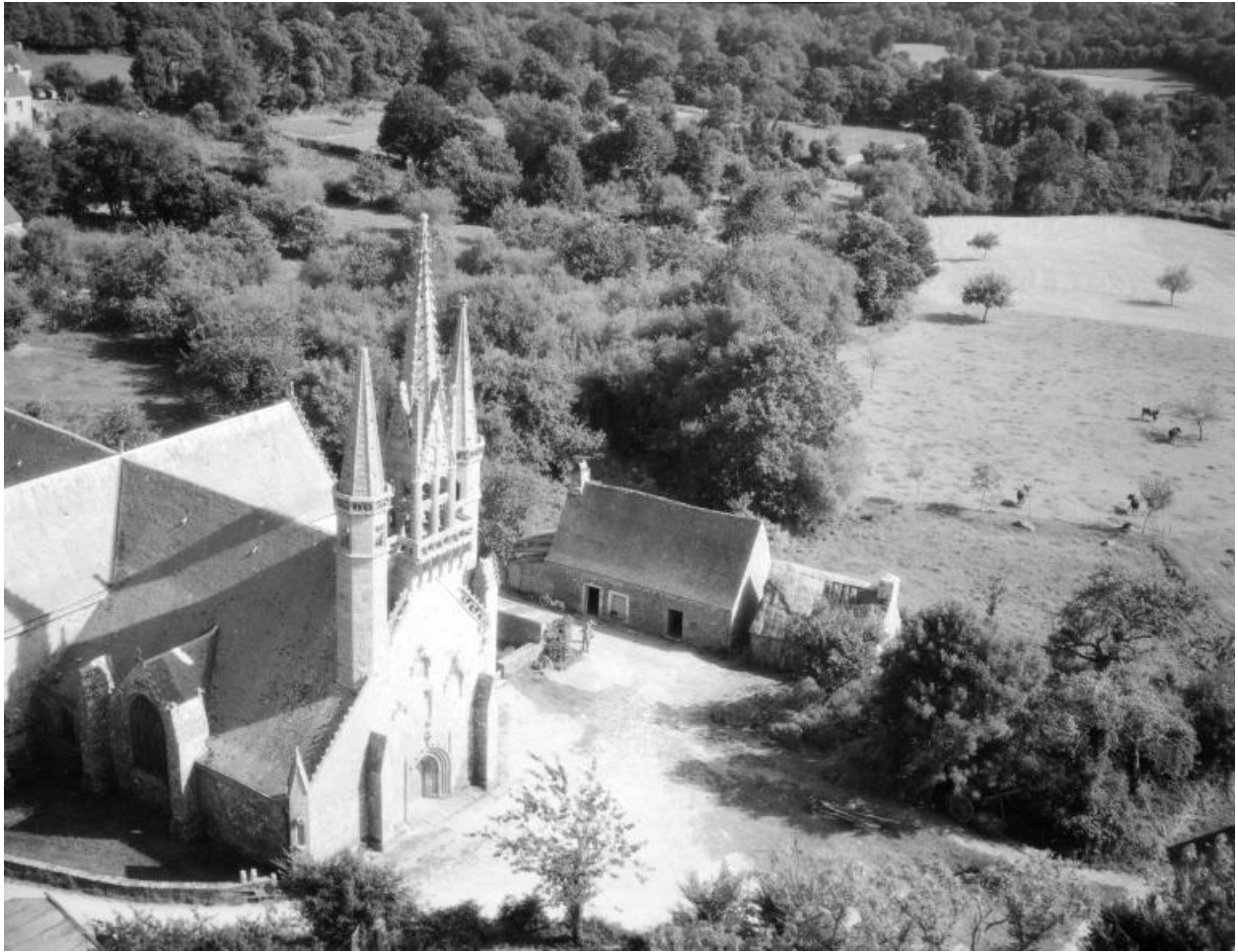
Vue aérienne, le massif occidental.
