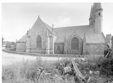
Façade nord, vue générale. Phot. François Dagorn IVR53_19665600153V
