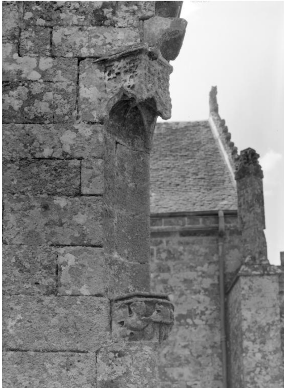
Niche à l'angle nord-est de la sacristie.
