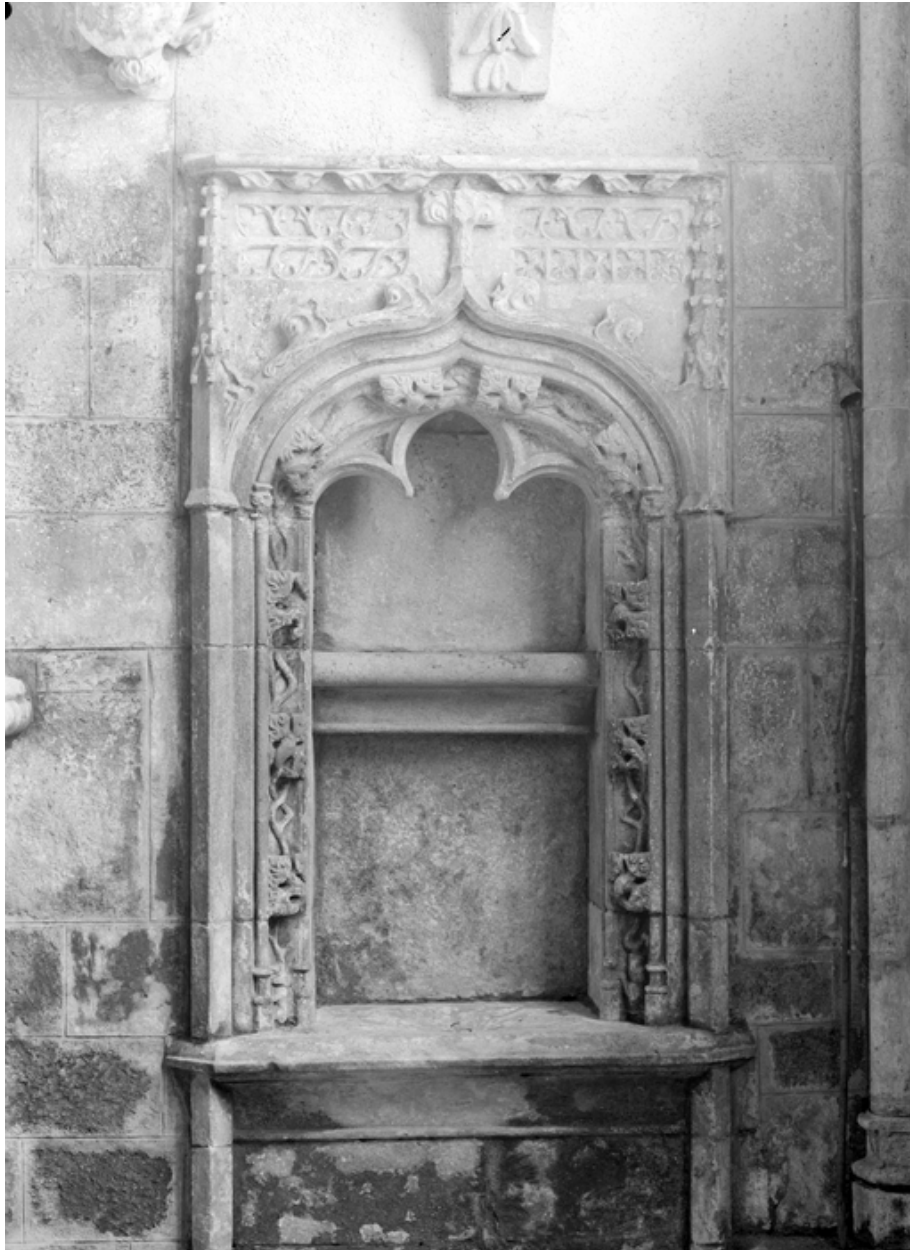
Choeur, mur est, crédence sud.
