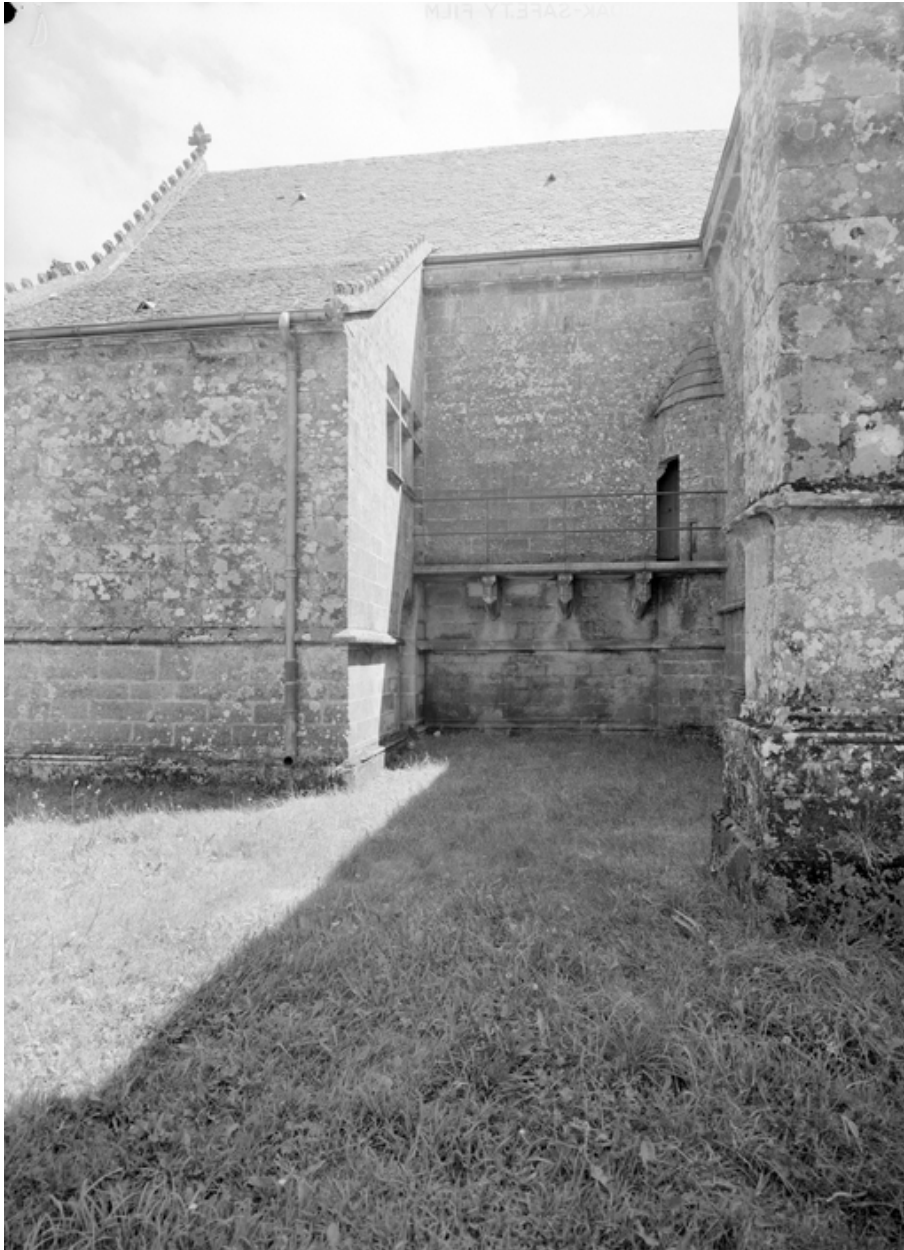
Façade nord, ancienne coursière entre l'oratoire supérieur et la tour d'escalier du bras nord.
