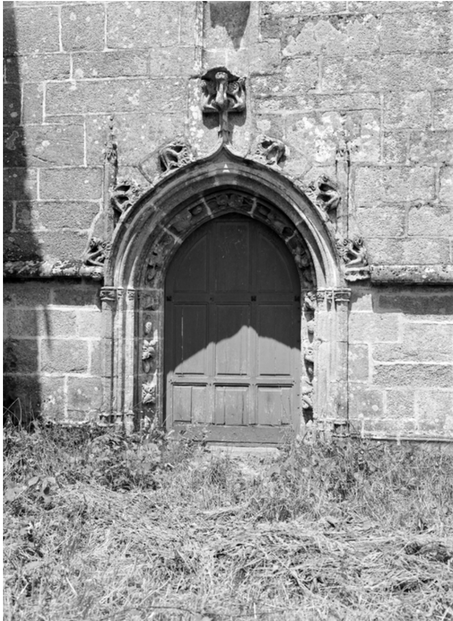
Mur sud du choeur, porte.
