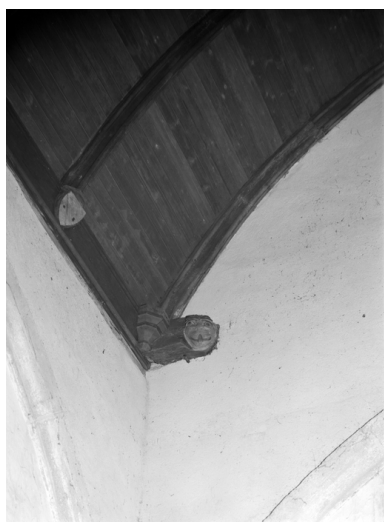
Croisillon nord, lambris, blochet nord-ouest. Phot. François Dagorn IVR53_19665600223V
