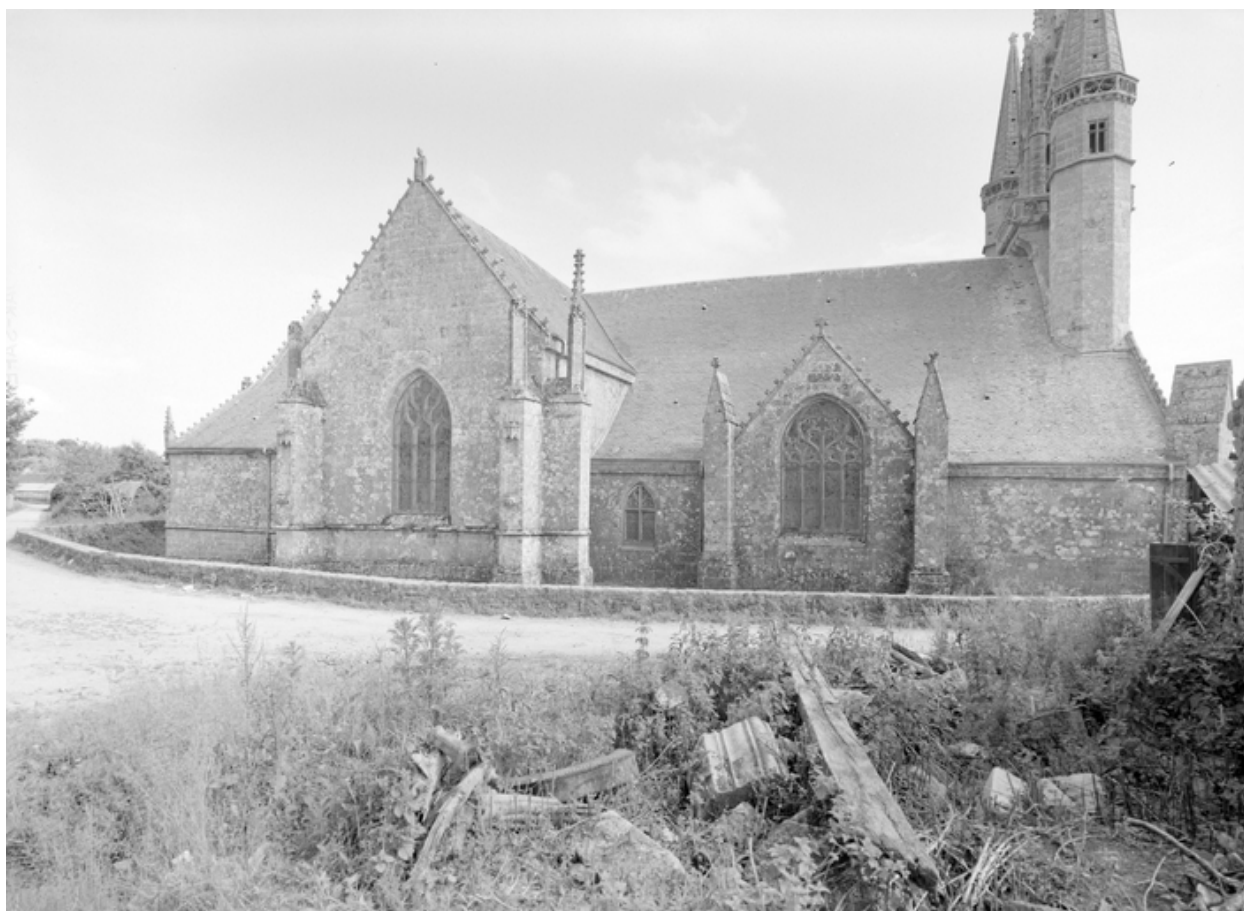
Façade nord, vue générale.
