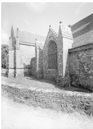
Façade nord, partie centrale. Phot. François Dagorn IVR53_19665600152V
