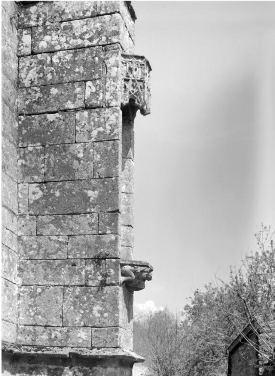
Niche du contrefort sud du bras du transept sud.
