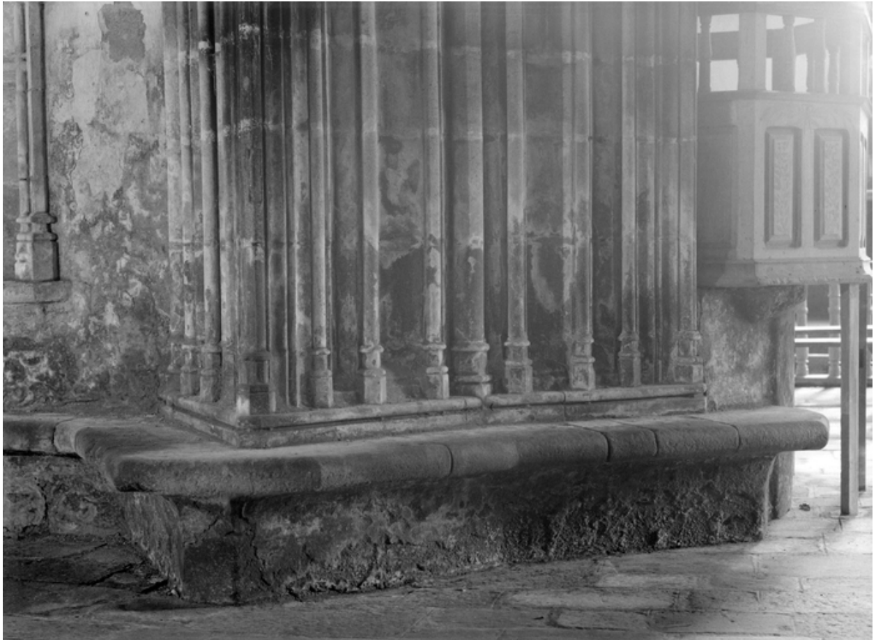
Pile nord-est de la croisée, détail de la base.
