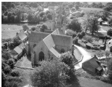
Vue aérienne est. Phot. G.A.L.A.T. IVR53_19675601483V
