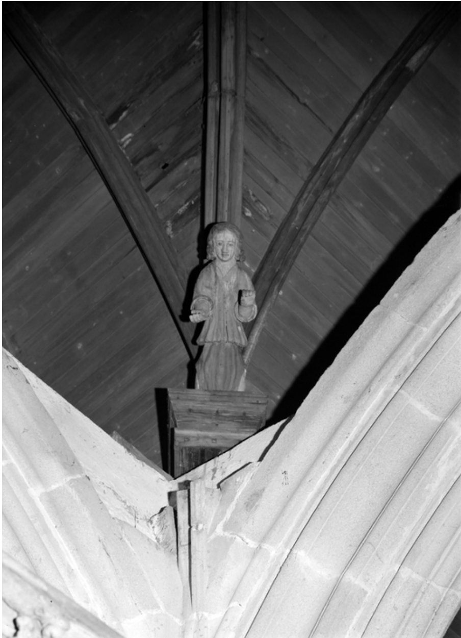
Croisée du transept, lambris corbelet nord-ouest.
