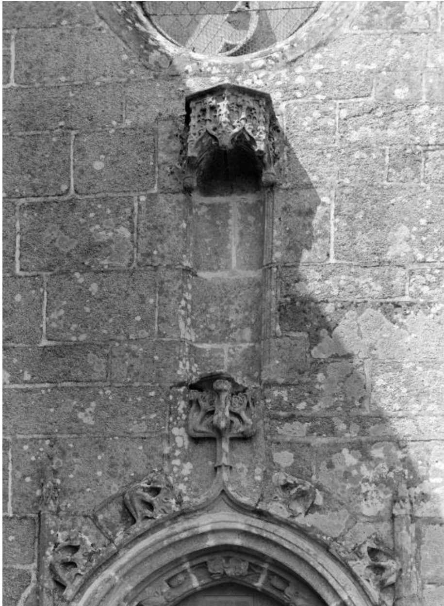
Niche du mur sud du choeur.
