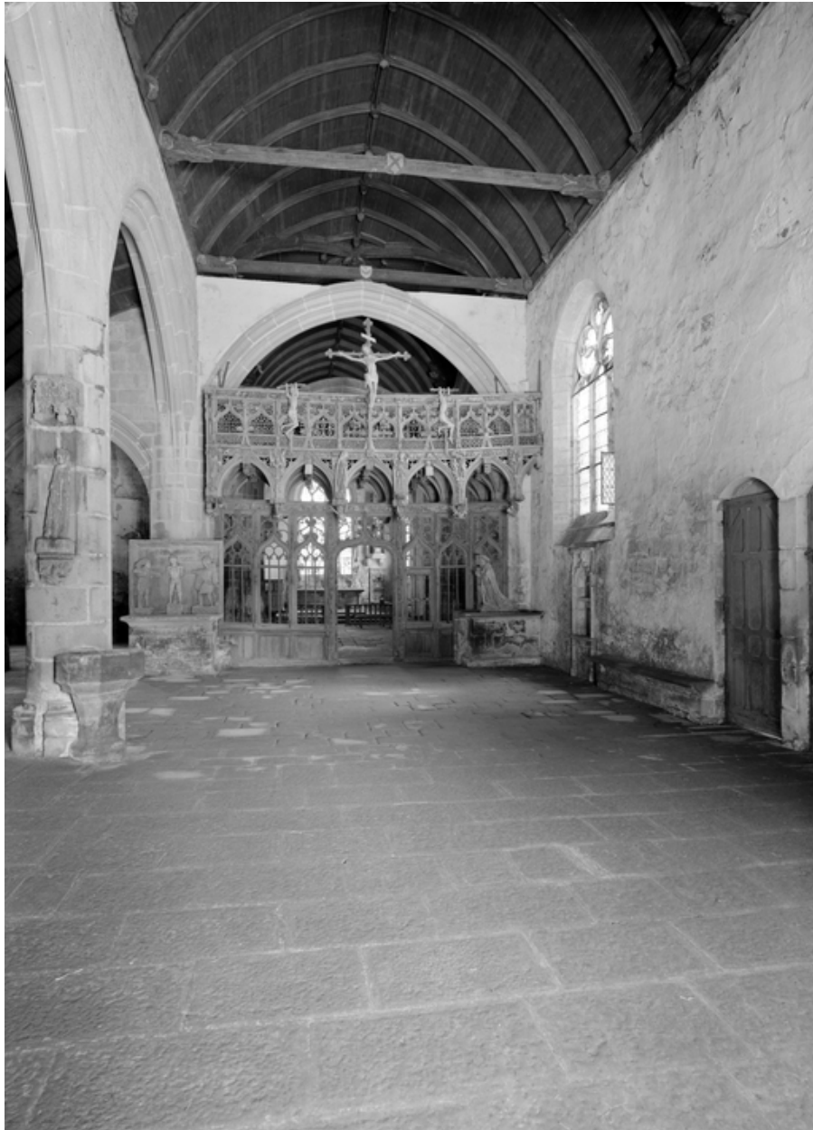
Vue générale de la nef vers l'est à l'ouest du jubé.
