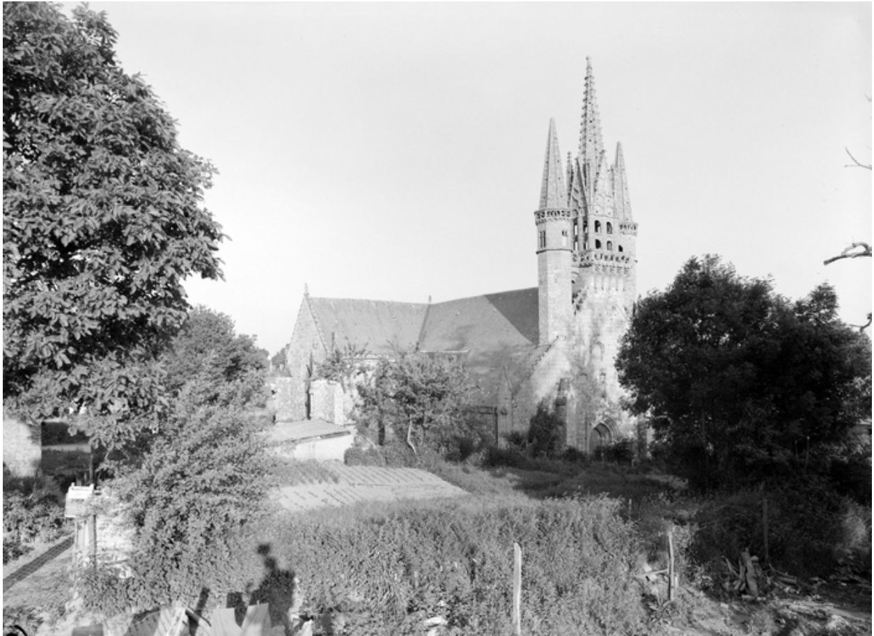
Vue générale prise du nord-ouest.
