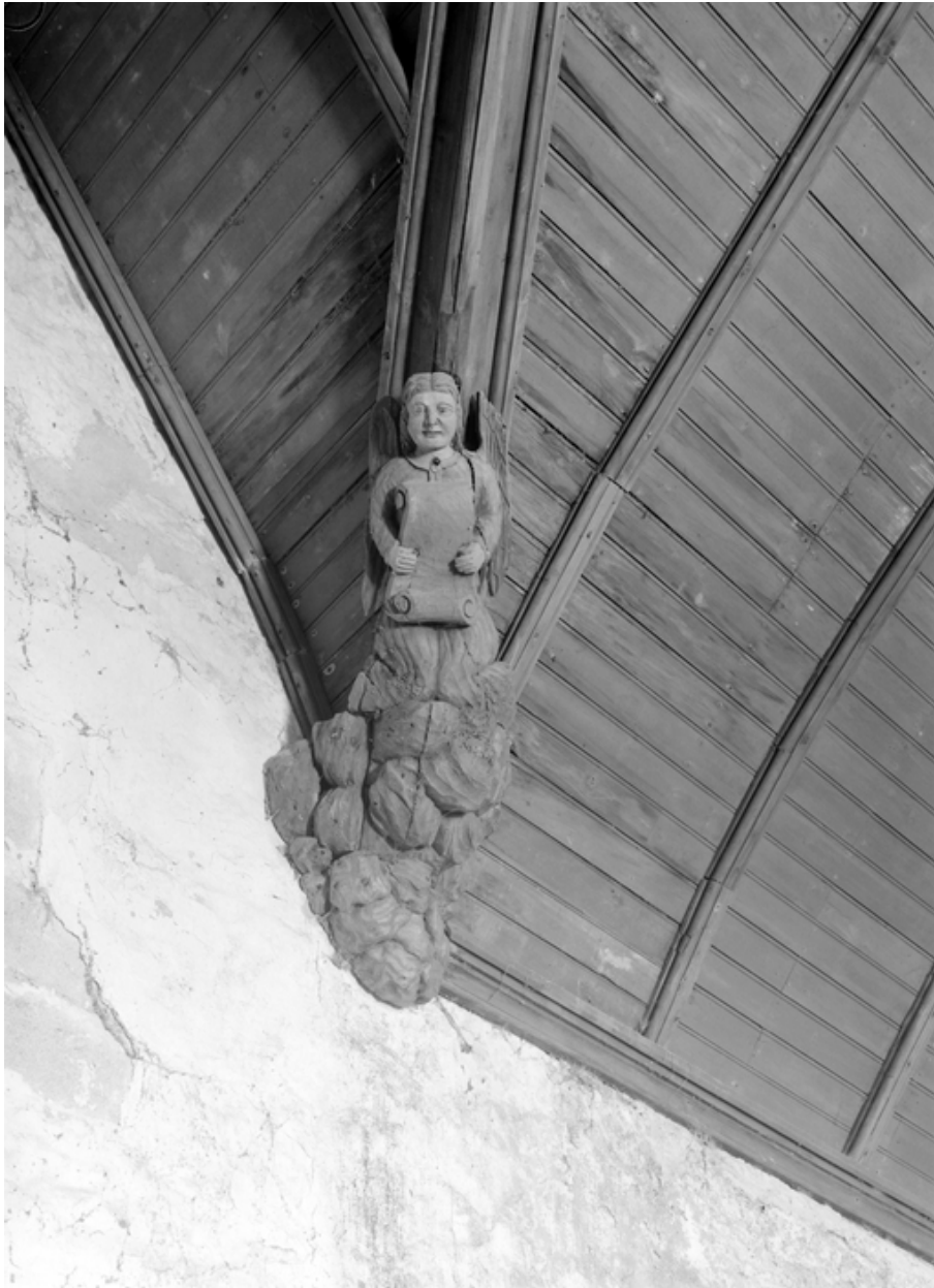
Bas-côté nord, corbelet à l'est de la baie centrale.
