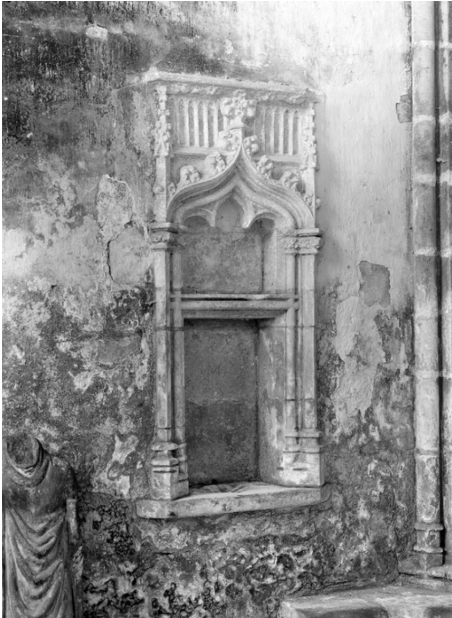
Croisillon nord, mur est, crédence.
