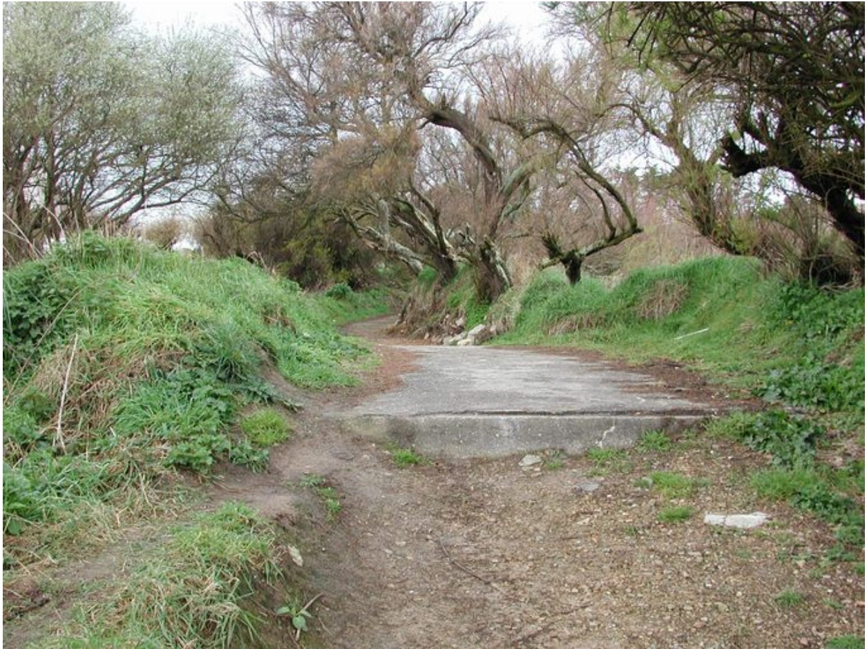
Vue de situation depuis le sentier côtier Grande Randonnée n° 34 : seule la dalle de couverture est visible (état en 2002)
