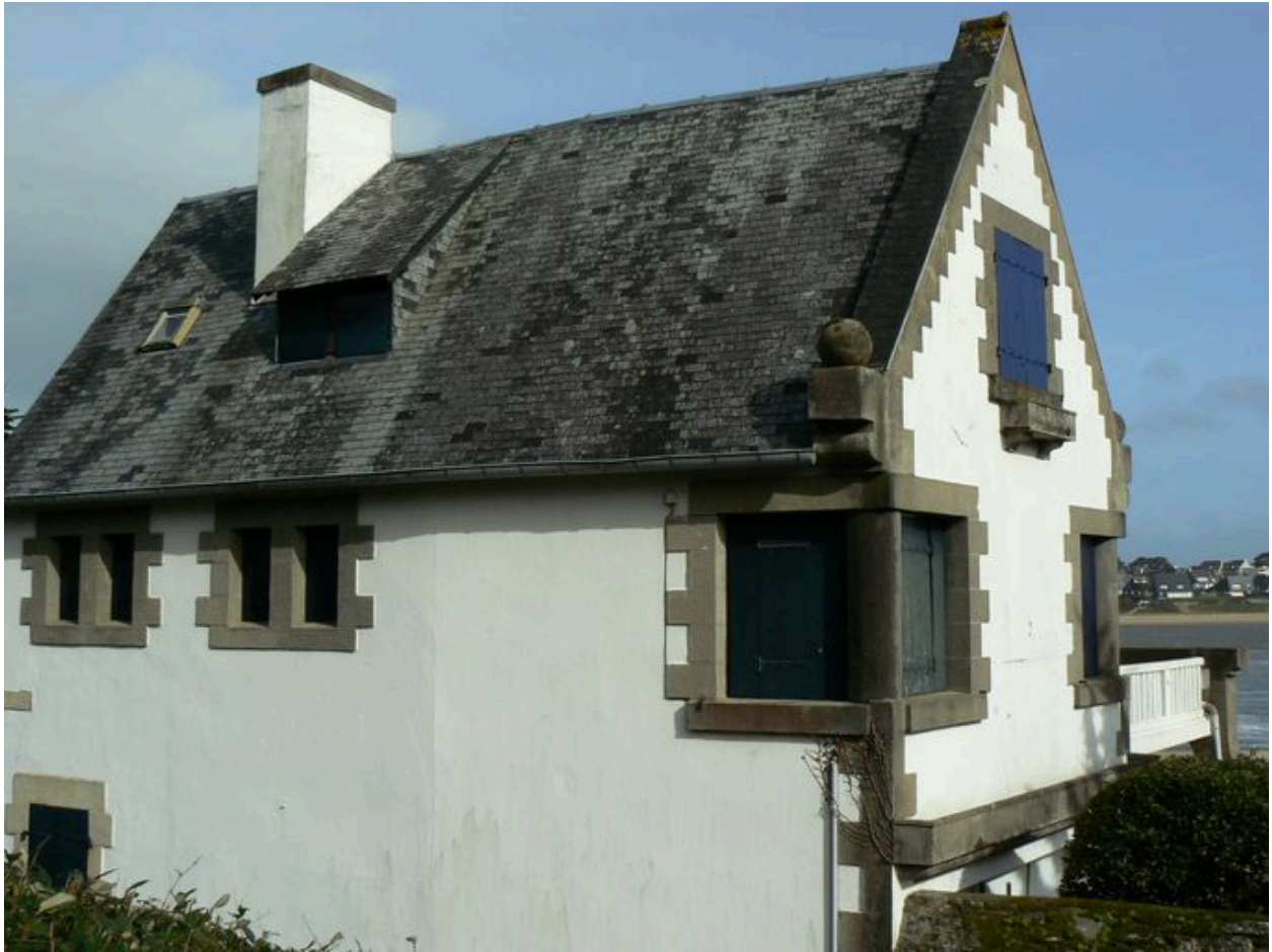
Corps de bâtiment ouest, longeant la route
