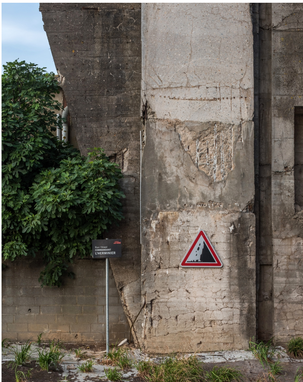
Vue des vestiges du bunker K4 le long de la rue Commandant-L'Herminier. La partie haute a été sciée et consolidée afin de faire passer les bateaux
