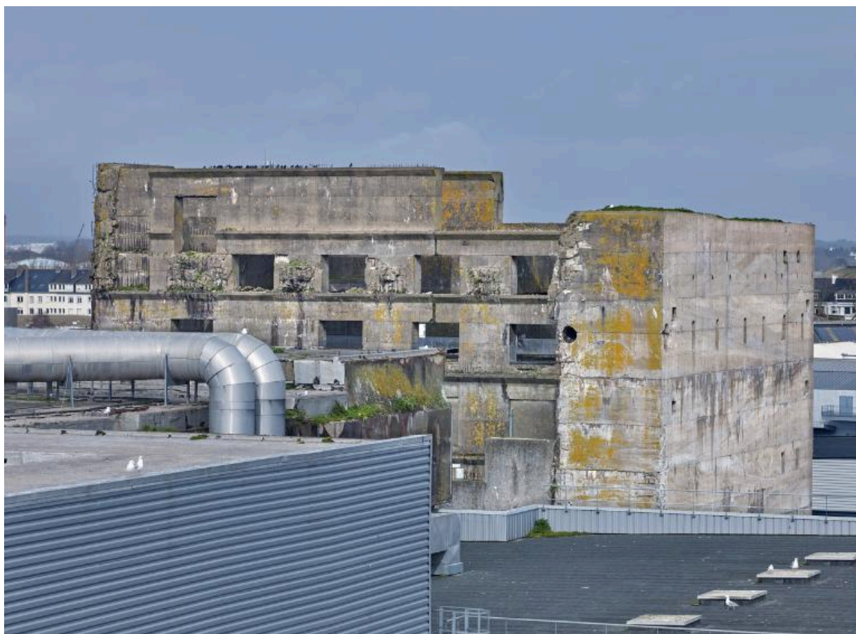
Vue du bunker Keroman IV depuis la dalle de couverture du bunker Keroman I. Le KIV domine les autres bunkers d'une dizaine de mètres
