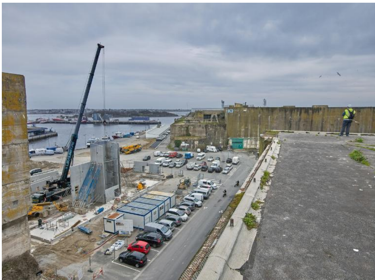
Vue du chantier de construction situé au pied du bunker keroman IV depuis la dalle de couverture du bunker Keroman I. A l'arrière-plan à droite, le bunker Keroman III
