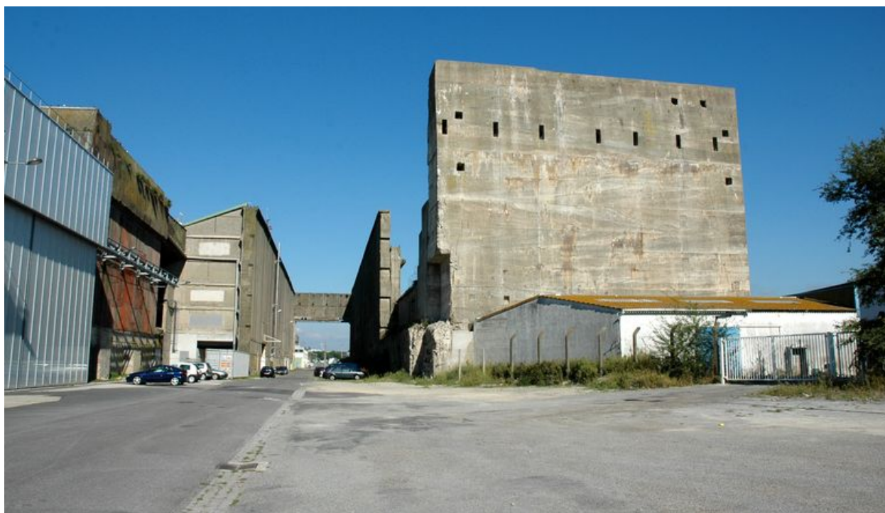
Vue des bunkers "KI" (à gauche) et "KIV" (à droite) : au centre, la rue du Commandant-L'Herminier (2005)
