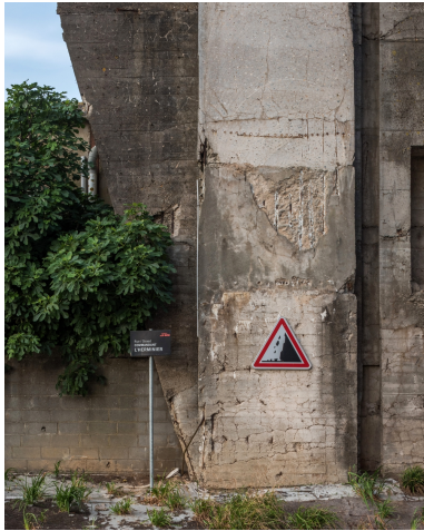
Vue des vestiges du bunker K4 le long de la rue Commandant- L'Herminier. La partie haute a été sciée et consolidée afin de faire passer les bateaux Phot. Charlotte Barraud IVR53_20235600317NUCA
