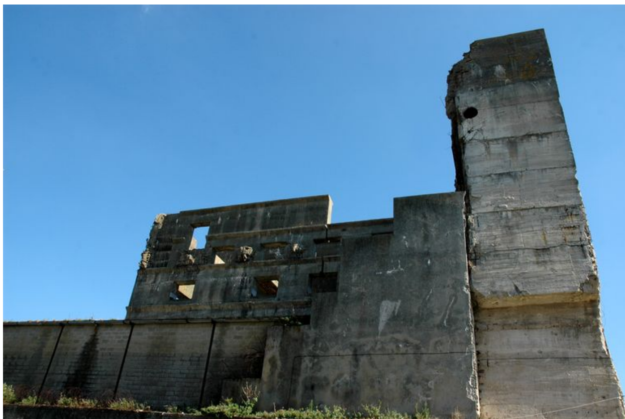
Vue de détail depuis la rue du Commandant-L'Herminier (2005)
