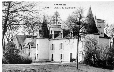
Vue générale Phot. Elise Lauranceau IVR53_20035604261NUCB
