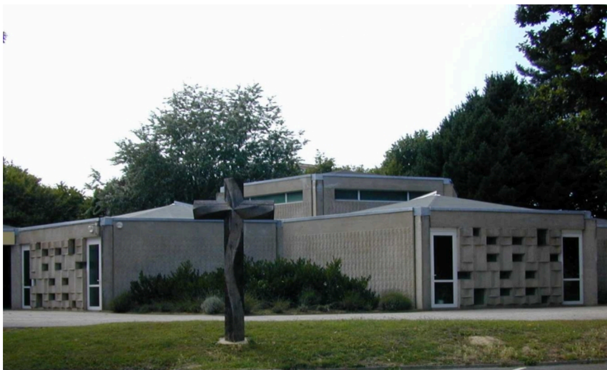
Détail de la façade est
