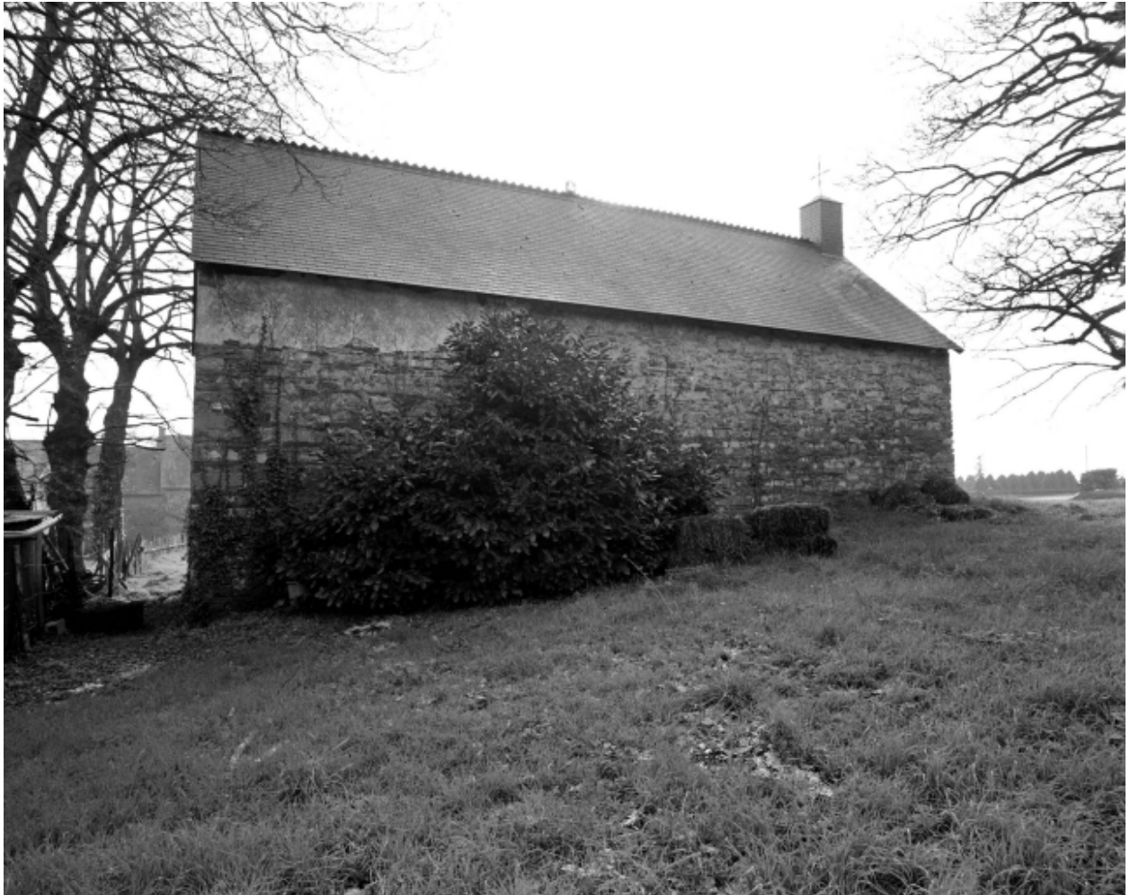
La chapelle en 1993 : vue générale nord-est
