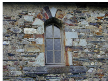
Baie sud : vue générale Phot. Xavier Gilbert IVR53_20013512392NUCA
