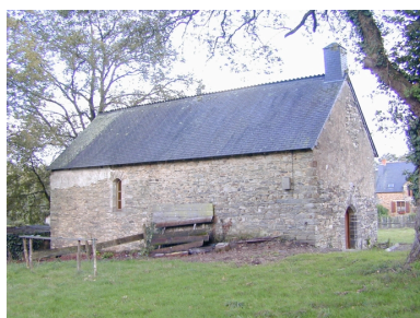
Vue générale nord-ouest Phot. Xavier Gilbert IVR53_20013512388NUCA
