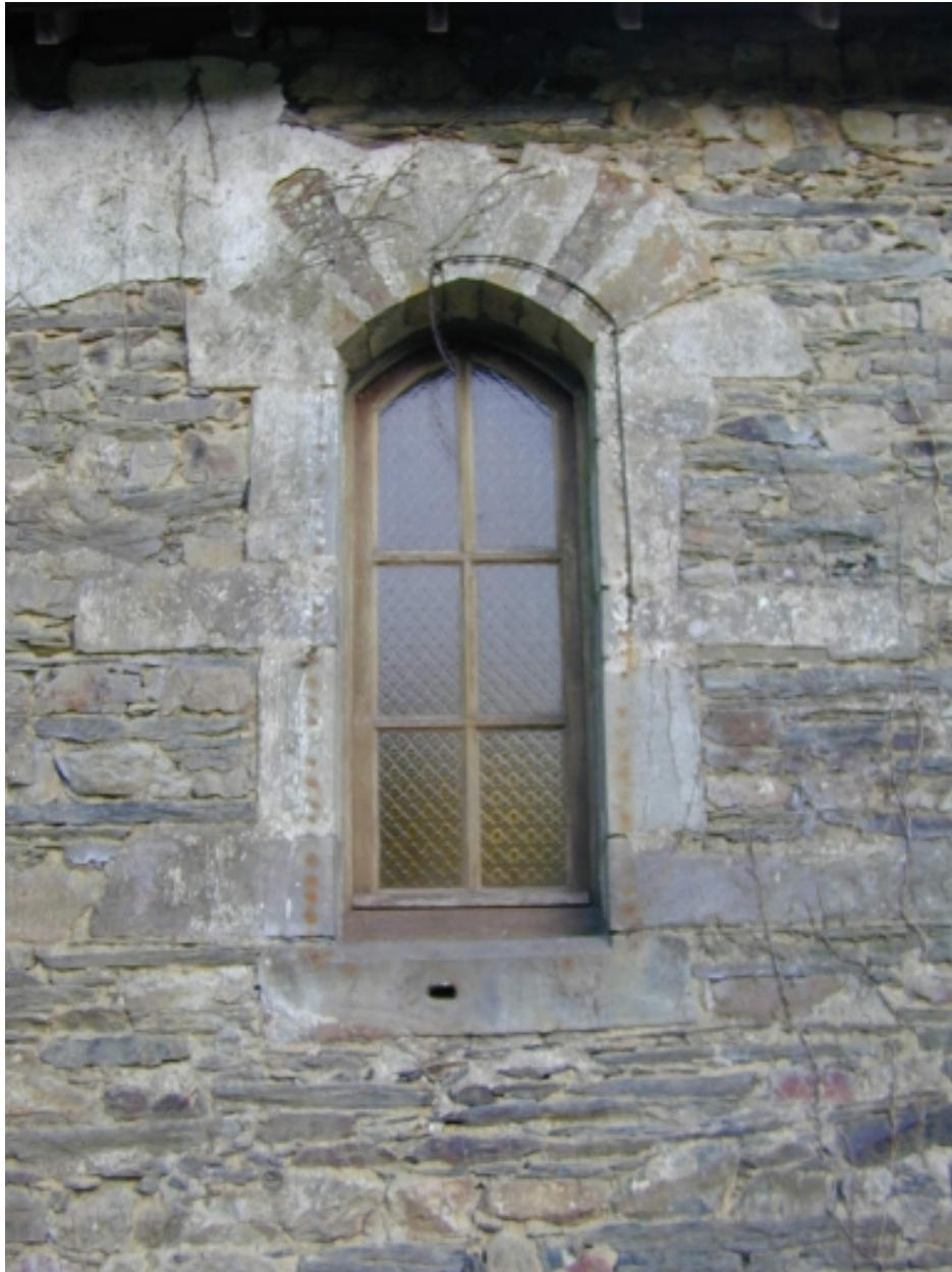
Baie nord : vue générale
