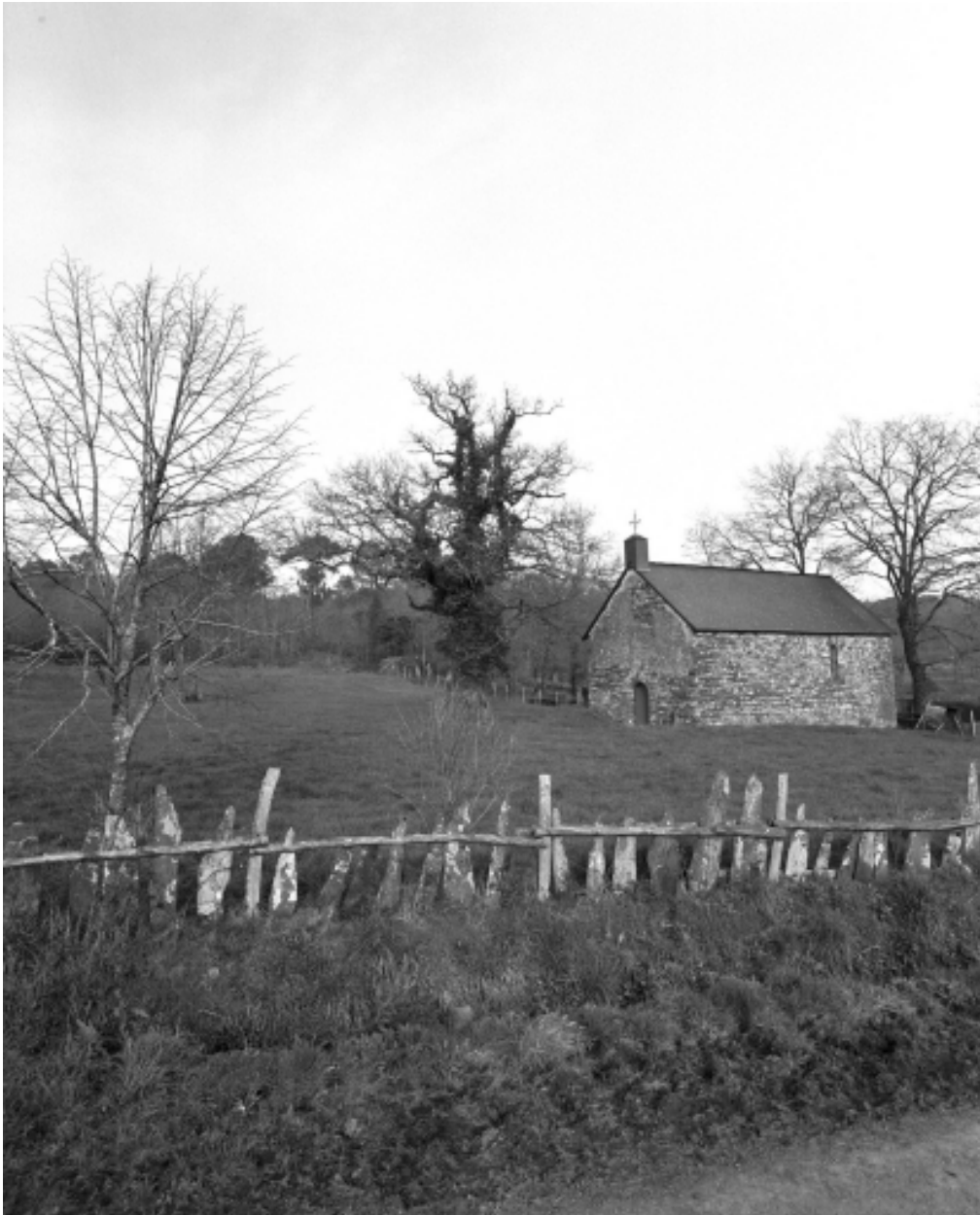
La chapelle en 1993 : vue de situation sud-ouest
