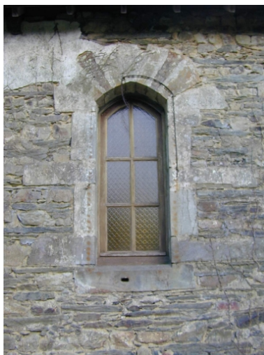
Baie nord : vue générale Phot. Xavier Gilbert IVR53_20013512391NUCA
