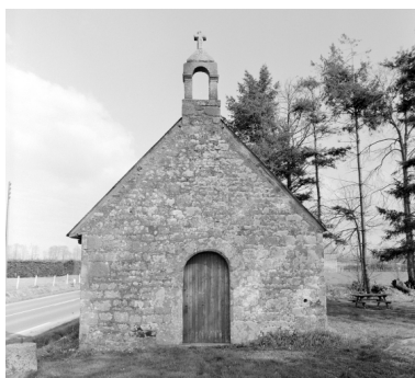
Elévation Sud-Est : vue générale Phot. Bernard Bègne, Phot. M. Loyon IVR53_19933500329X
