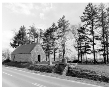
Elévation Nord- Ouest : vue de situation Phot. Bernard Bègne, Phot. M. Loyon IVR53_19933500331X
