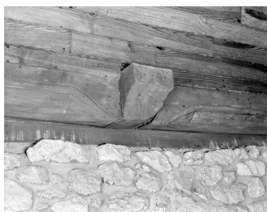
Intérieur : détail de la charpente. Phot. Bernard Bègne, Phot. M. Loyon IVR53_19933500334X
