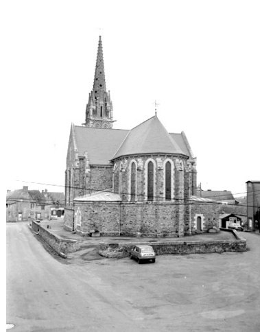
Élévation est : vue générale Phot. Guy Artur, Phot. Norbert Lambart IVR53_19943501481X
