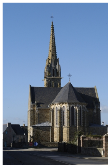
Abside de l'église
