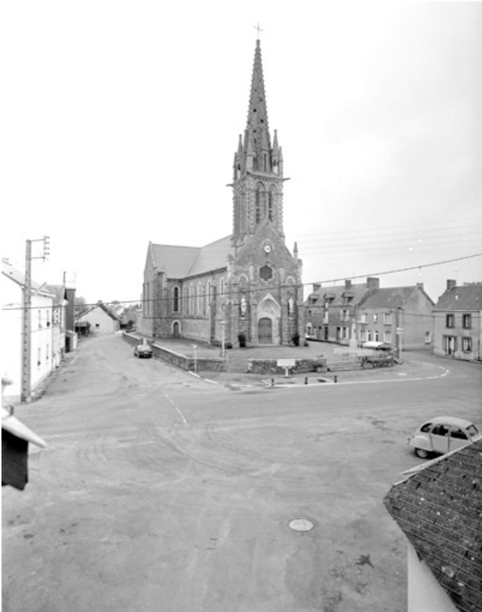
Élévation nord-ouest : vue générale
