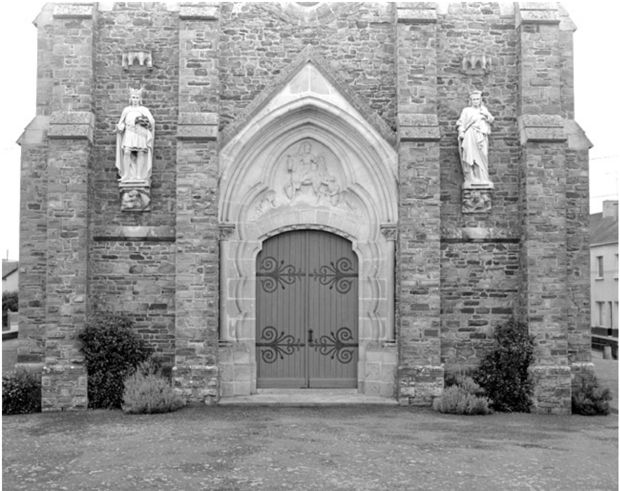
Élévation ouest, porte : vue générale
