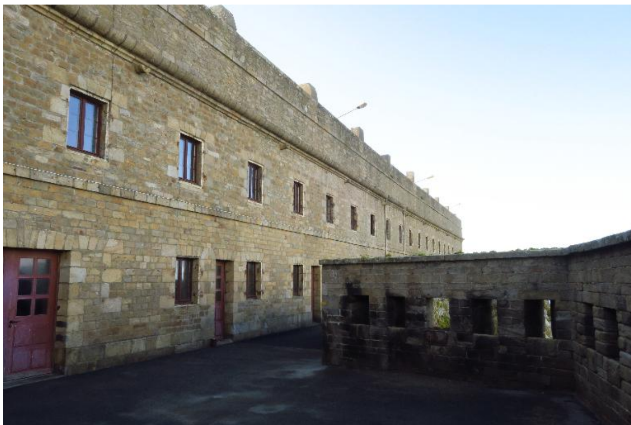
Saint-Pierre-Quiberon, fort de Penthievre, caserne défensive, façade nord-ouest.
