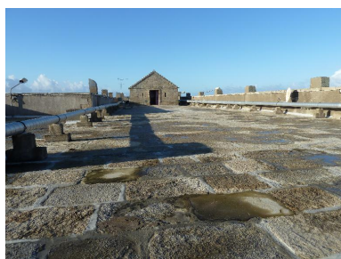
Saint-Pierre-Quiberon, fort de Penthievre, caserne défensive, terrasse. Phot. Patrick Jadé IVR53_20175606642NUCA
