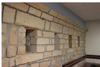
Saint-Pierre-Quiberon, fort de Penthievre, caserne défensive, piédroit et départ de voûte d'une casemate du rez-de-chaussée. Phot. Philippe Ruelen IVR53_20175606648NUCA
