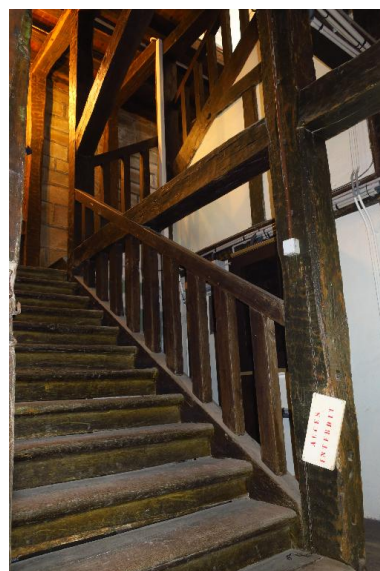
Saint-Pierre-Quiberon, fort de Penthievre, caserne défensive, cage d'escalier à pans de bois. Phot. Lionel Duigou IVR53_20175606644NUCA
