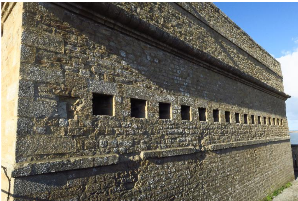
Saint-Pierre-Quiberon, fort de Penthievre, caserne défensive, façade nord-est.
