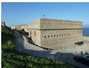
Saint-Pierre-Quiberon, fort de Penthievre, caserne défensive, vue depuis le nord-est. Phot. Patrick Jadé IVR53_20175606628NUCA
