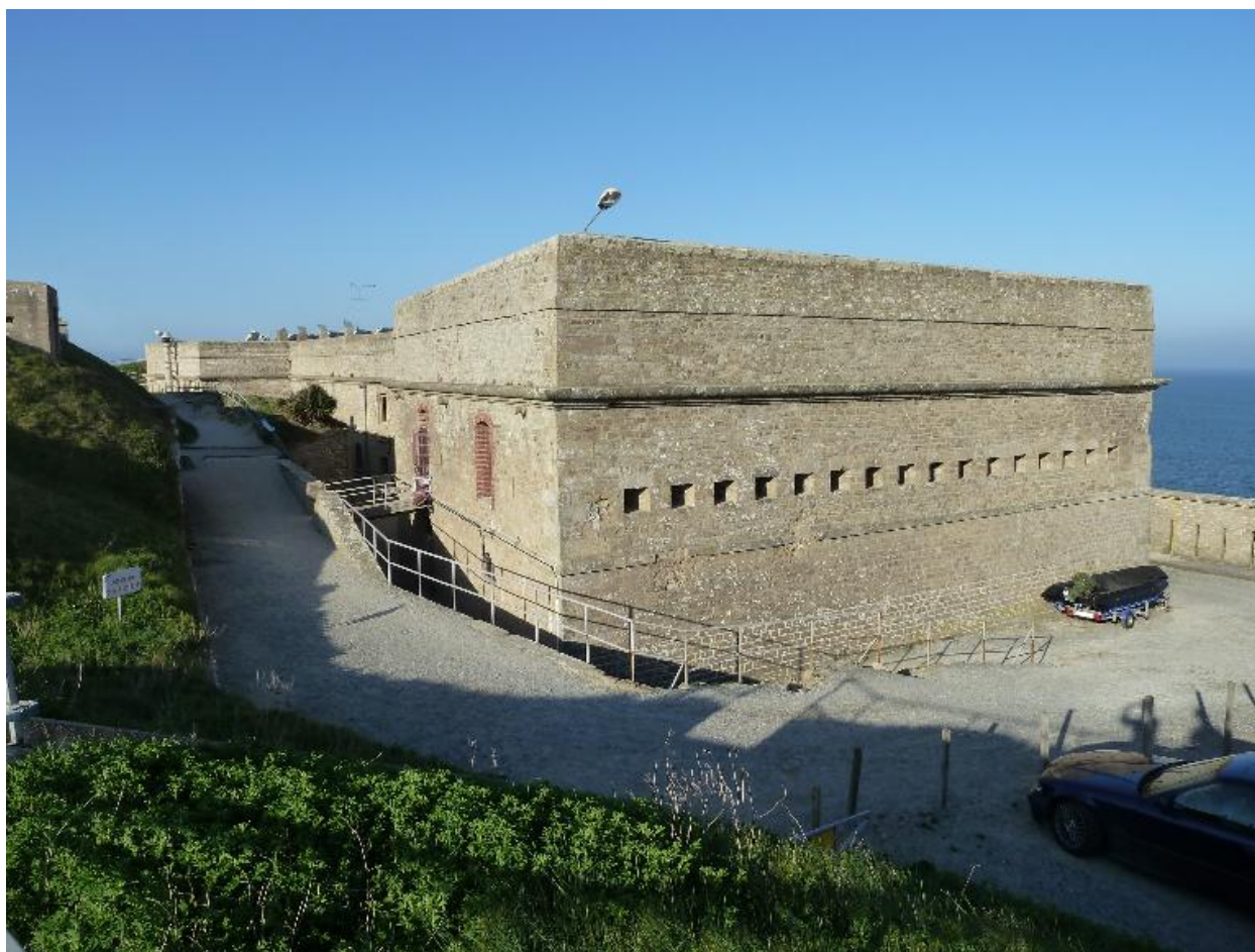
Saint-Pierre-Quiberon, fort de Penthievre, caserne défensive, vue depuis le nord-est.
