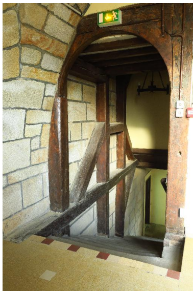
Saint-Pierre-Quiberon, fort de Penthievre, caserne défensive, cage d'escalier à pans de bois. Phot. Lionel Duigou IVR53_20175606646NUCA
