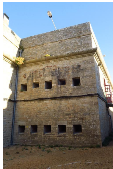
Saint-Pierre-Quiberon, fort de Penthievre, caserne défensive, flanc du demi-bastion nord-est. Phot. Lionel Duigou IVR53_20175606635NUCA
