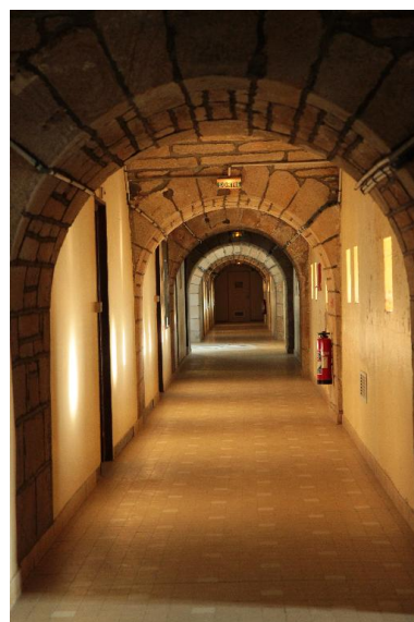
Saint-Pierre-Quiberon, fort de Penthievre, caserne défensive, coursive du première étage. Phot. Philippe Ruelen IVR53_20175606650NUCA
