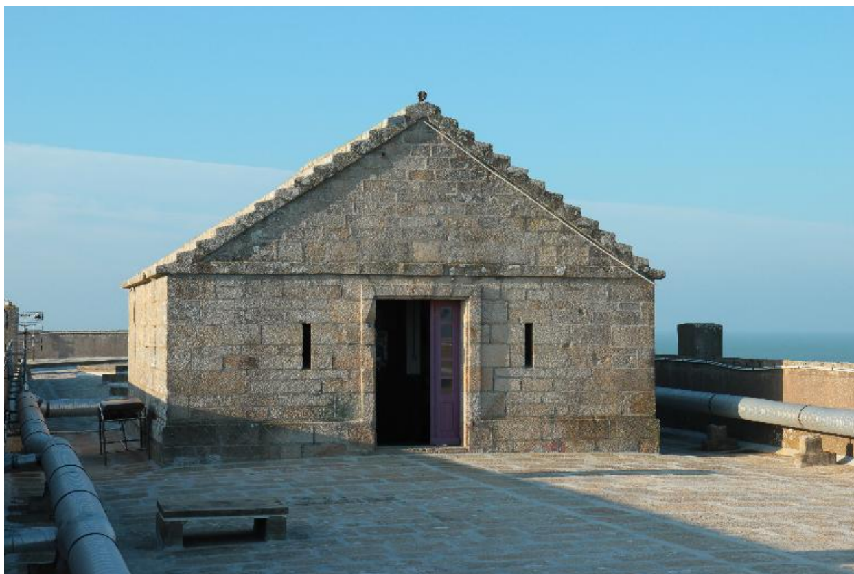
Saint-Pierre-Quiberon, fort de Penthievre, caserne défensive, débouché de l'escalier sur la terrasse.
