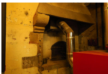
Saint-Pierre-Quiberon, fort de Penthievre, caserne défensive, four à pain. Phot. Lionel Duigou IVR53_20175606649NUCA
