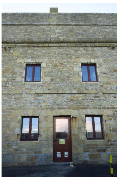
Saint-Pierre-Quiberon, fort de Penthievre, caserne défensive, détail de la façade nord-ouest. Phot. Lionel Duigou IVR53_20175606640NUCA
