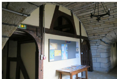
Saint-Pierre-Quiberon, fort de Penthievre, caserne défensive, cage d'escalier à pans de bois. Phot. Lionel Duigou IVR53_20175606645NUCA
