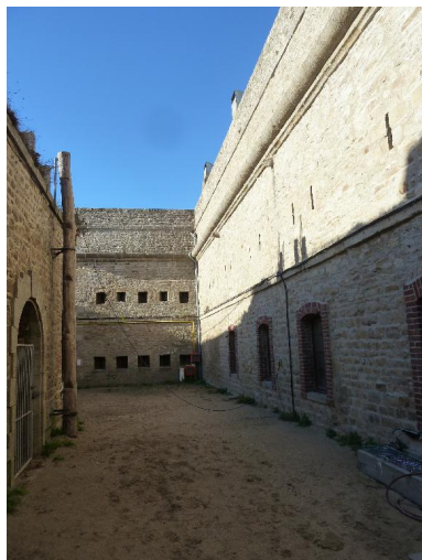
Saint-Pierre-Quiberon, fort de Penthievre, caserne défensive, façade sud-est et fossé. Phot. Patrick Jadé IVR53_20175606633NUCA
