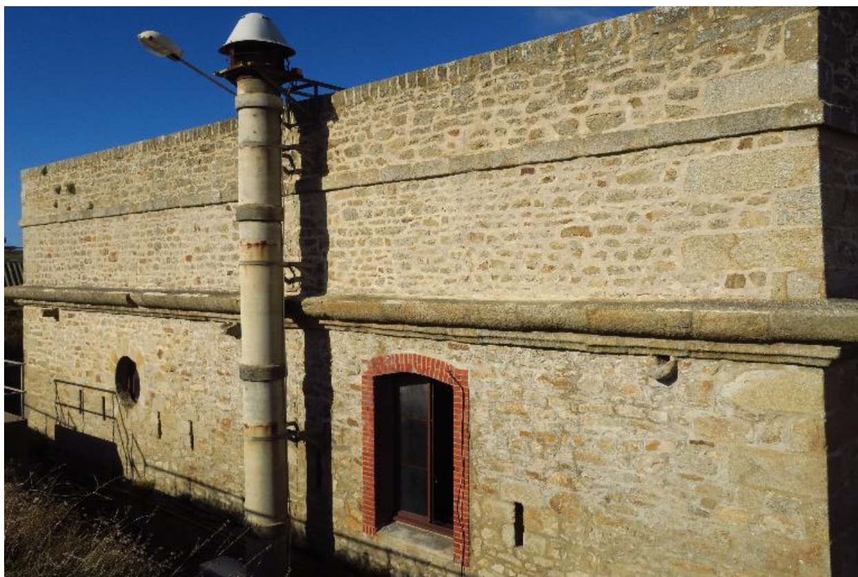
Saint-Pierre-Quiberon, fort de Penthhièvre, caserne défensive, face du demi-bastion sud-ouest.
