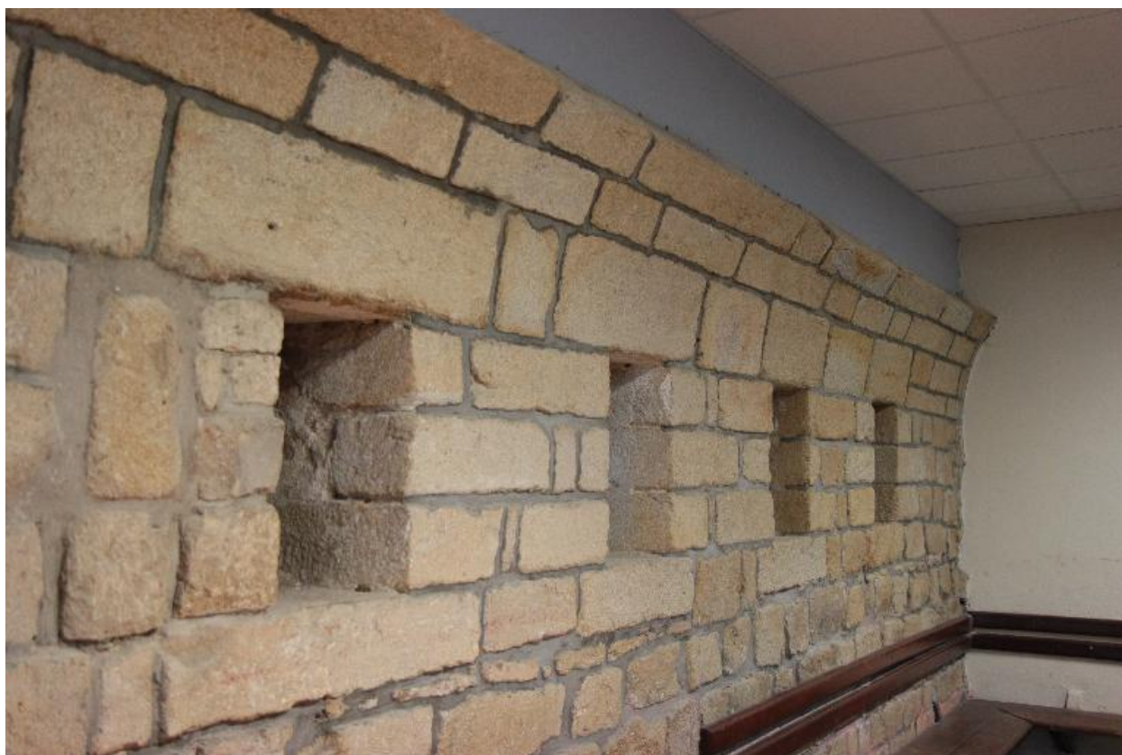
Saint-Pierre-Quiberon, fort de Penthievre, caserne défensive, piédroit et départ de voûte d'une casemate du rez-de-chaussée.
