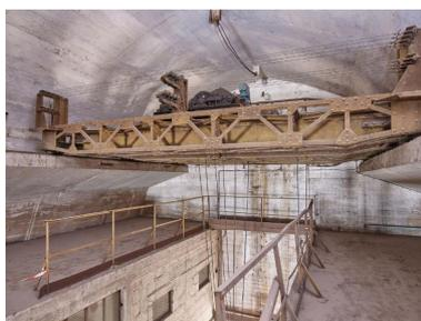
Vue du pont roulant arrière doté de ses deux treuils (pont roulant de la période allemande)
