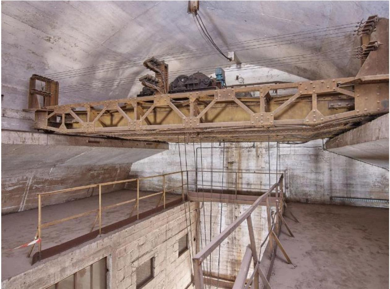
Vue du pont roulant arrière doté de ses deux treuils (pont roulant de la période allemande)
