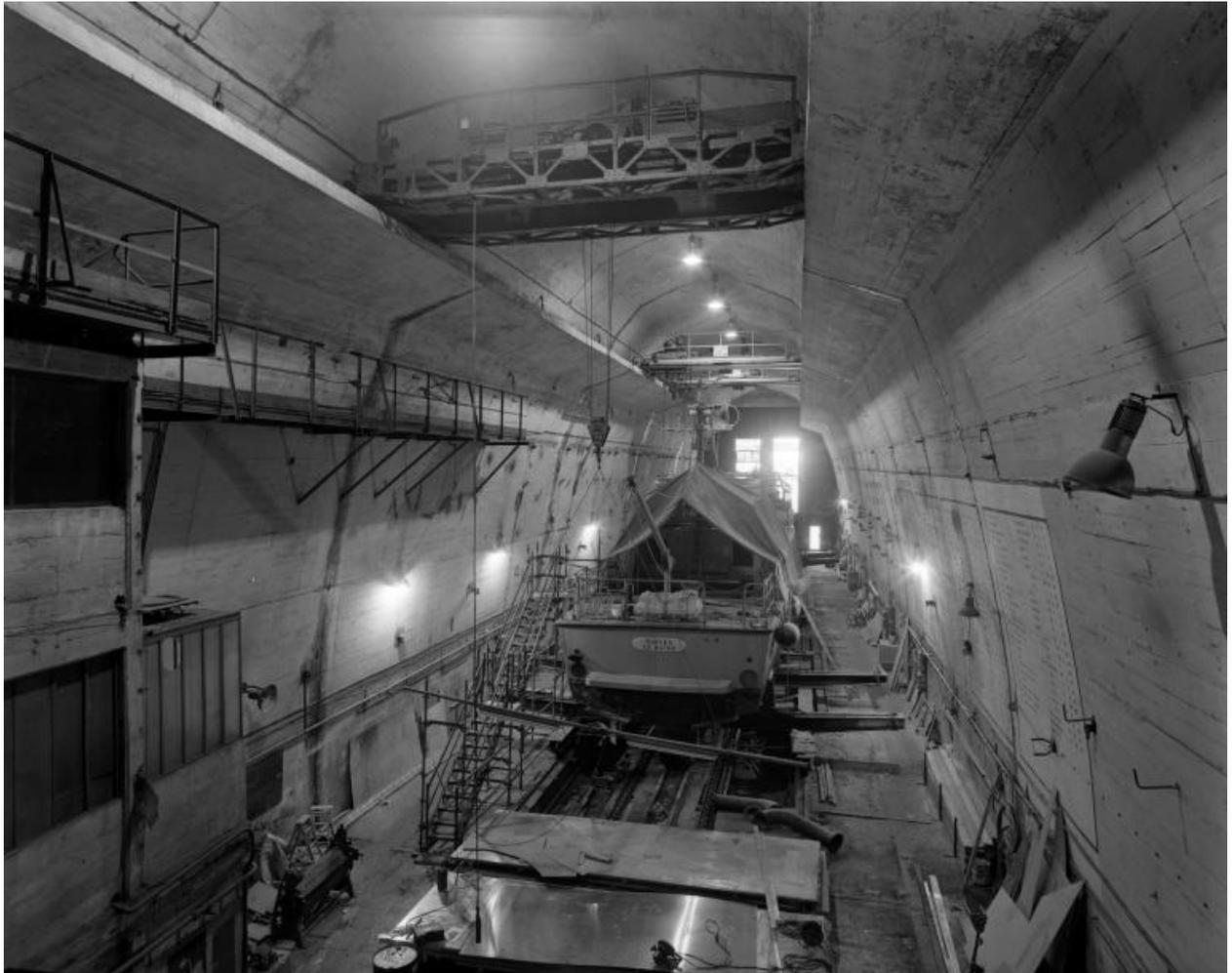
Vue générale de la nef vers le nord (état en 2000, chantier naval en activité) : navire en réparation. Au plafond, le pont roulant et son treuil en fonctionnement
