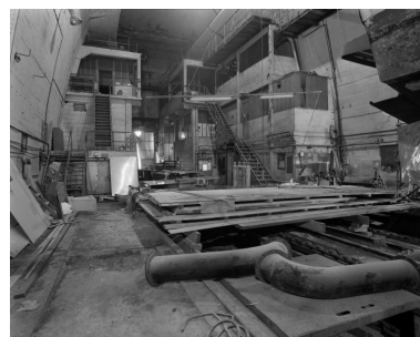
Vue de la nef vers le sud (état en 2000, chantier naval en activité) : de part et d'autre de la grande porte au centre, les ateliers et bureaux. Au niveau supérieur, les deux ponts roulants et leur treuil Phot. Bernard Bègne IVR53_20005600580X
