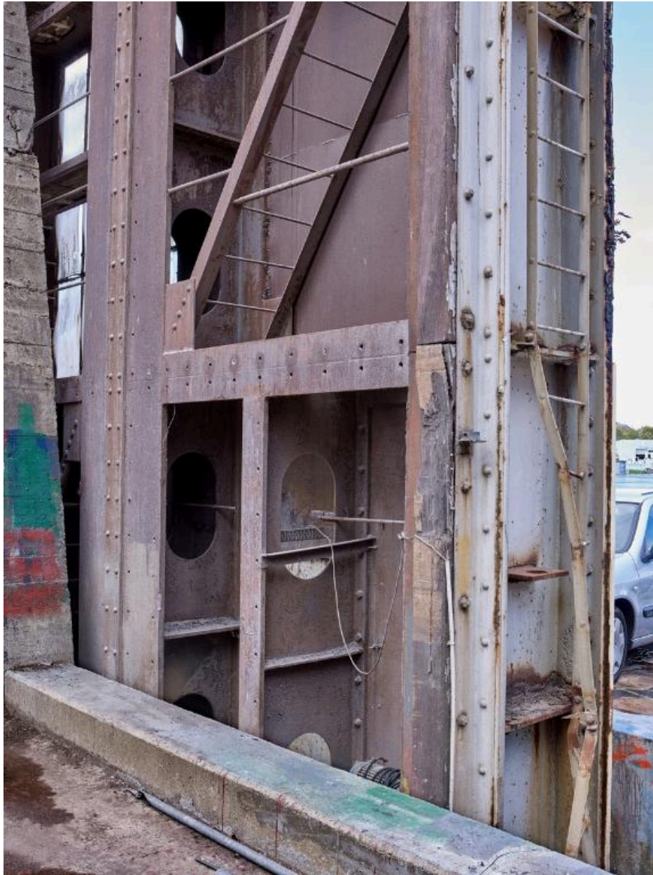
Vue de l'un des deux volets de la porte blindée nord. La porte est assemblée comme une double coque de bateau
