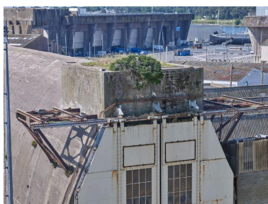
Vue de l'encuvement pour canon antiaérien situé sur la dalle de couverture et portes coulissantes blindées Phot. Bernard Bègne IVR53_20215600427NUCA
