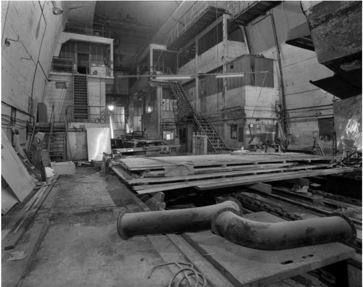
Vue de la nef vers le sud (état en 2000, chantier naval en activité) : de part et d'autre de la grande porte au centre, les ateliers et bureaux. Au niveau supérieur, les deux ponts roulants et leur treuil
