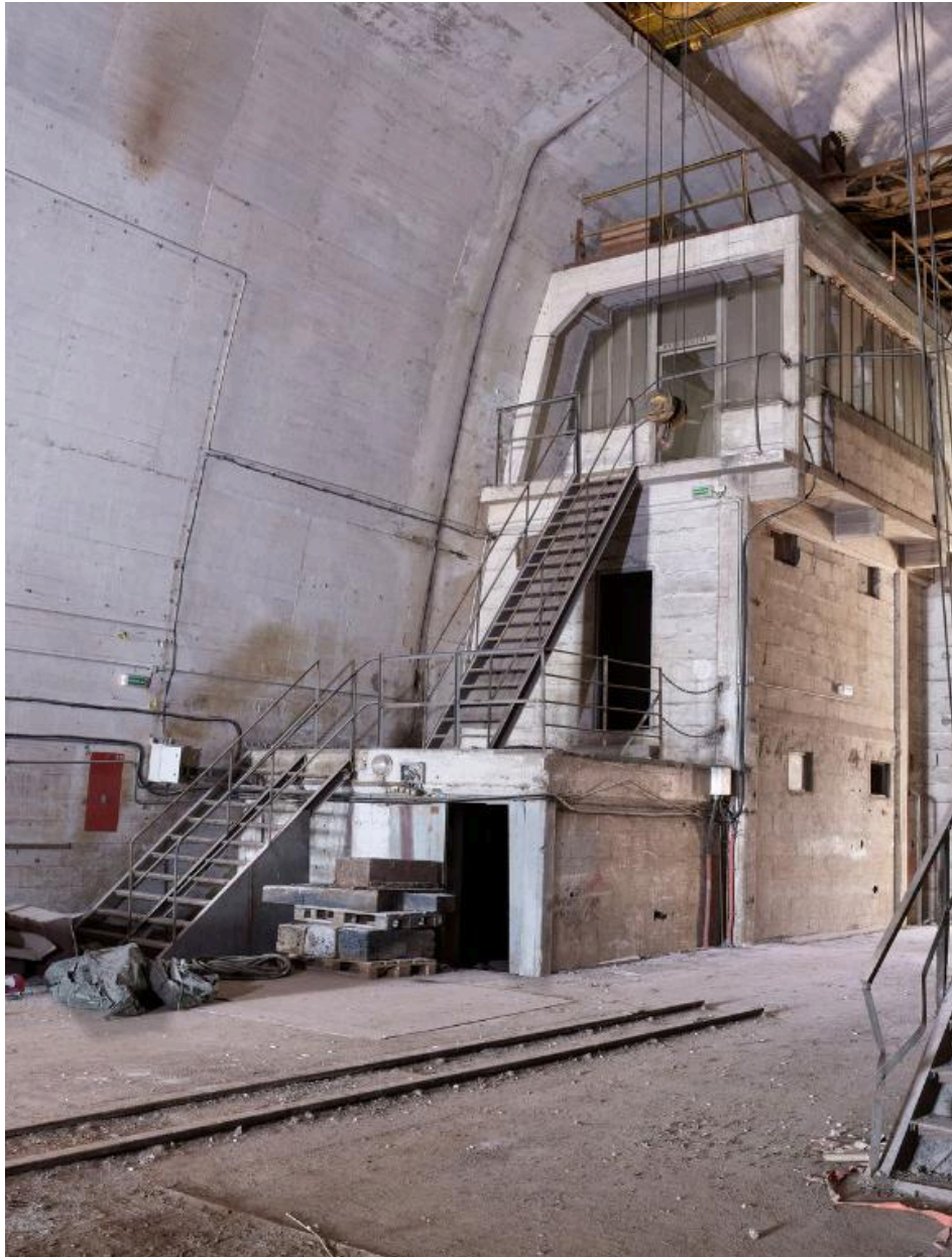
Vue de la nef vers le sud : ateliers et bureaux est. Les niveaux supérieurs sont accessibles par des escaliers extérieurs droits. Au premier plan, les rails du chariot de manutention
