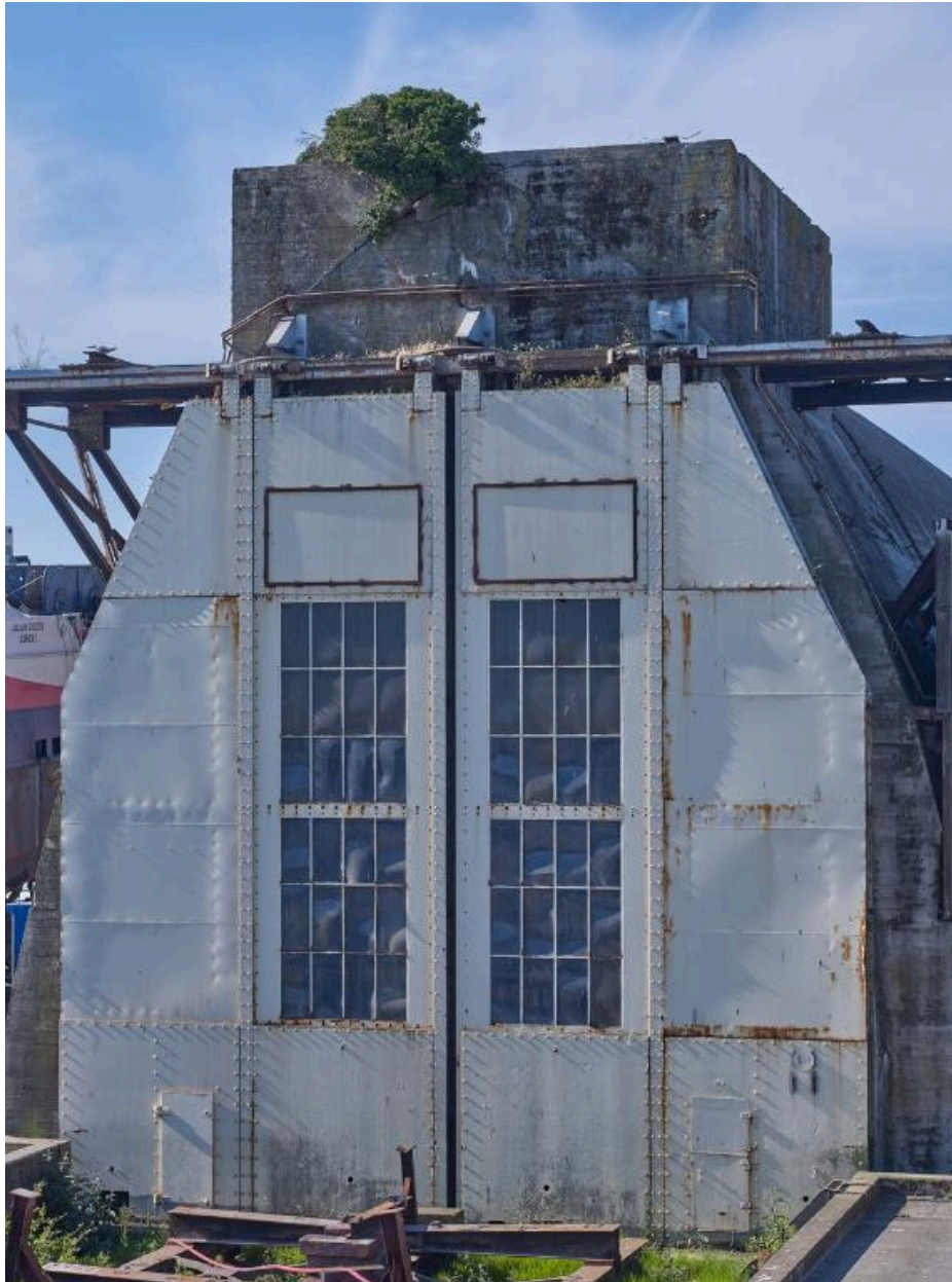
Vue depuis le nord : portes coulissantes blindées
