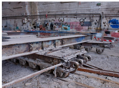
Vue d'une partie du ber du slipway sur ses quatre rails. Ici, un point de raccordement du ber Phot. Bernard Bègne IVR53_20225600532NUCA
