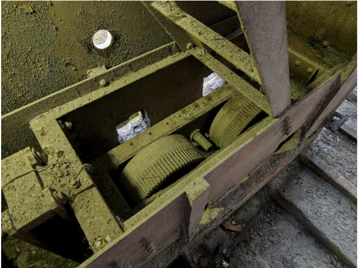
Vue intérieure de l'un des deux volets de la porte blindée nord : mécanisme cranté permettant l'ouverture
