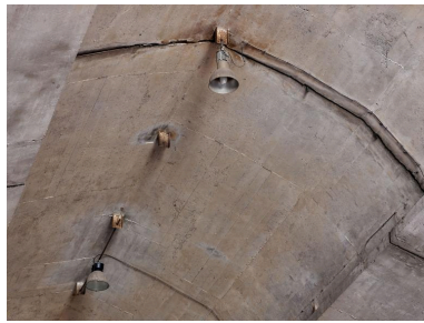
Vue de la voûte à la jonction de deux des six tronçons du dom-bunker et du dispositif d'éclairage Phot. Bernard Bègne IVR53_20225600533NUCA
