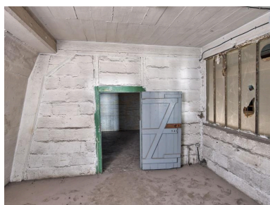
Vue des ateliers et bureaux est de la nef : pièce à usage de réfectoire Phot. Bernard Bègne IVR53_20215600445NUCA
