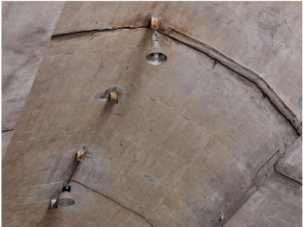
Vue de la voûte à la jonction de deux des six tronçons du dom-bunker et du dispositif d'éclairage
