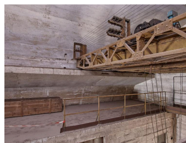
Vue de détail du pont roulant arrière doté de ses deux treuils (pont roulant de la période allemande) Phot. Bernard Bègne IVR53_20215600447NUCA
