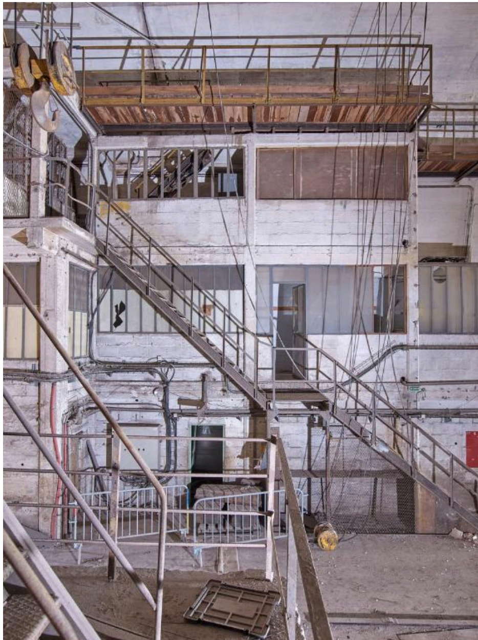
Vue des ateliers et bureaux ouest de la nef. Les niveaux supérieurs sont accessibles par des escaliers extérieurs droits.
