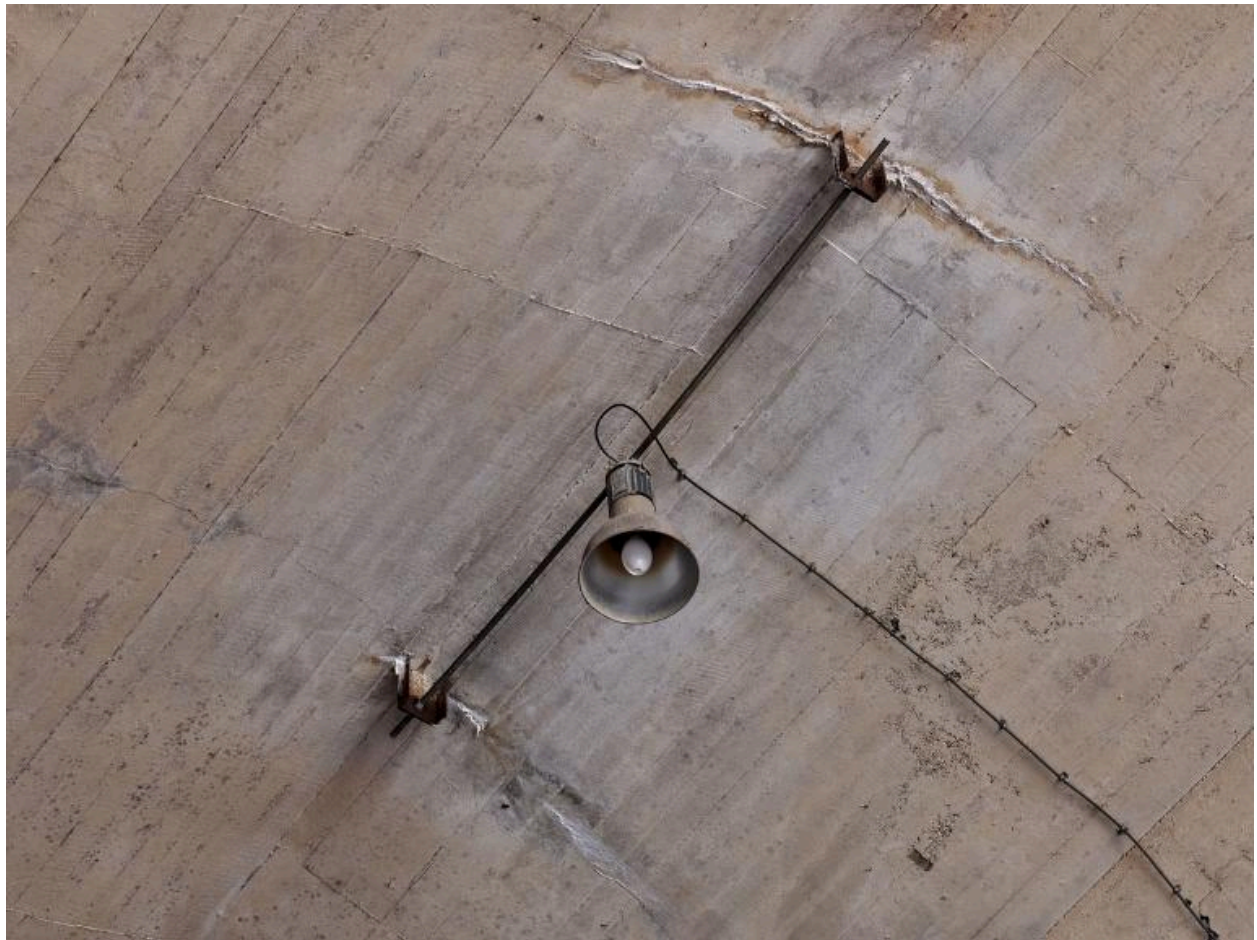
Vue de la voûte et du dispositif d'éclairage
