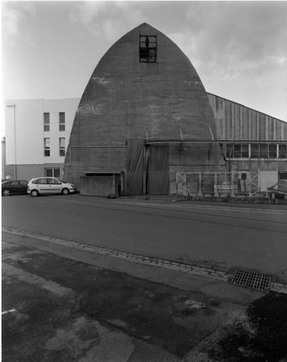
Vue générale depuis le sud (état en 2000) : une grande porte donne accès la nef et aux ateliers
