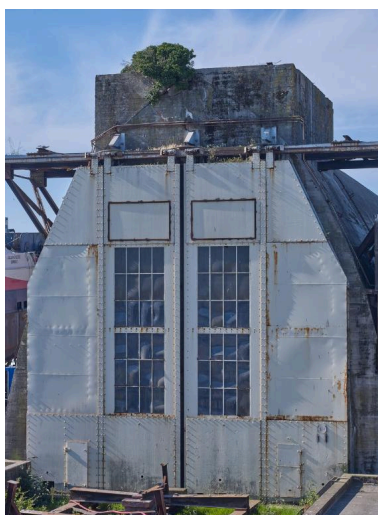
Vue depuis le nord : portes coulissantes blindées Phot. Bernard Bègne IVR53_20215600426NUCA
