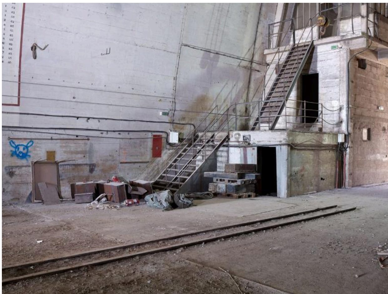
Vue de la nef vers le sud : ateliers et bureaux est. Les niveaux supérieurs sont accessibles par des escaliers extérieurs droits. Au premier plan, les rails du chariot de manutention
