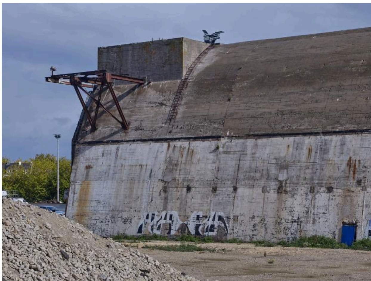
Vue générale ouest. Le bunker est surmonté par un encuvement pour canon antiaérien
