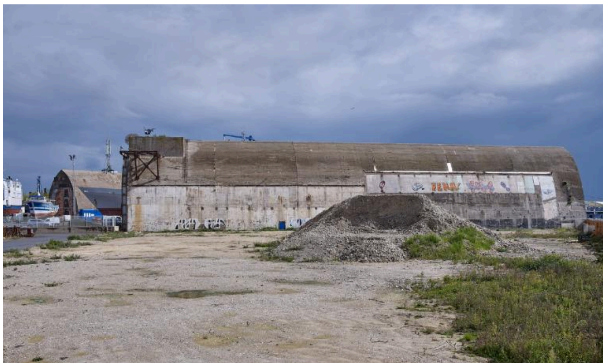
Vue générale ouest en 2022. Au premier plan, le terrain après la déconstruction des bâtiments des Chantiers et Ateliers de la Perrière
