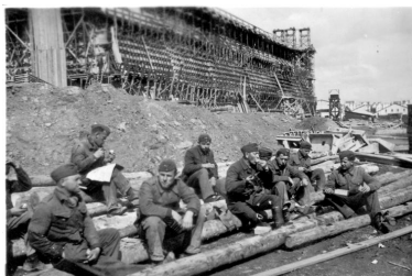
Vue de la construction de l'un des deux Dom-bunkers : étape du coffrage en béton armé, avril 1941 (photographie non attribuée provenant du Fonds Crolard et achetée par les Archives municipales de Lorient, disponible sous les cotes 5Fi6112 et 9Fi2804 [image inversée]). Au premier plan, travailleurs (?) lors de la pause ; à l'arrière plan, on aperçoit un mirador Phot. Anonyme
