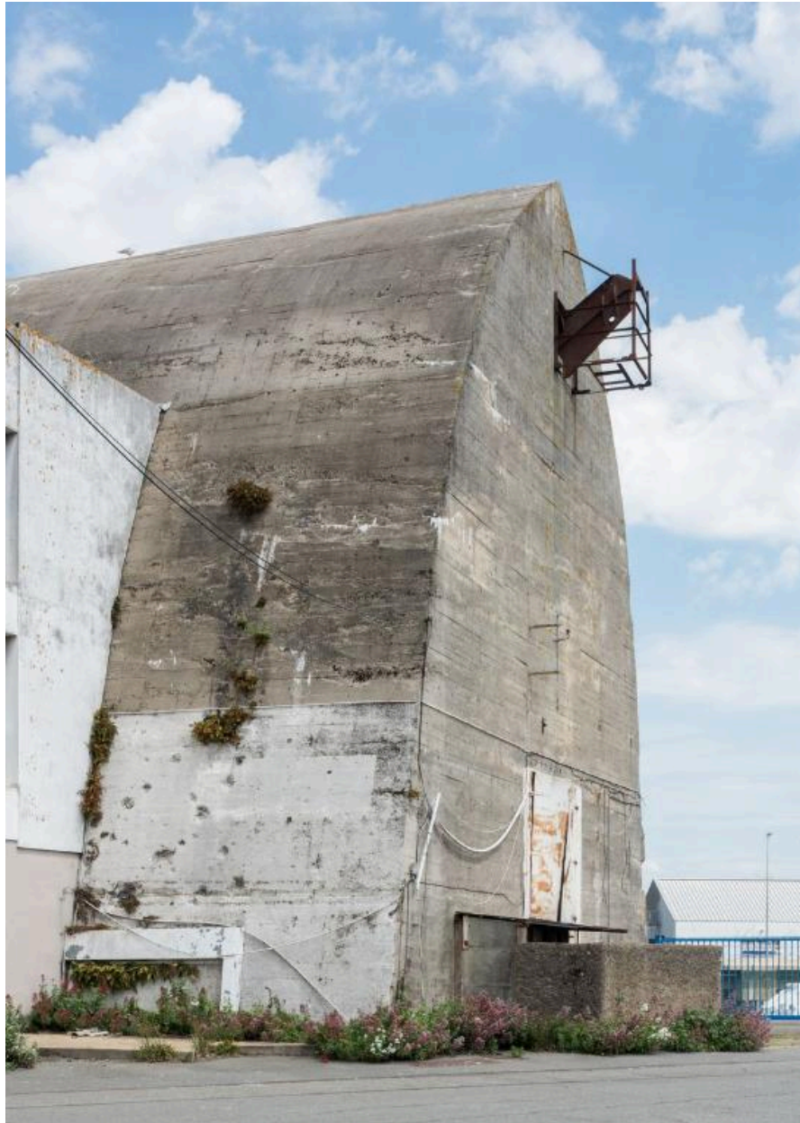
Vue du pignon sud depuis le sud-ouest
