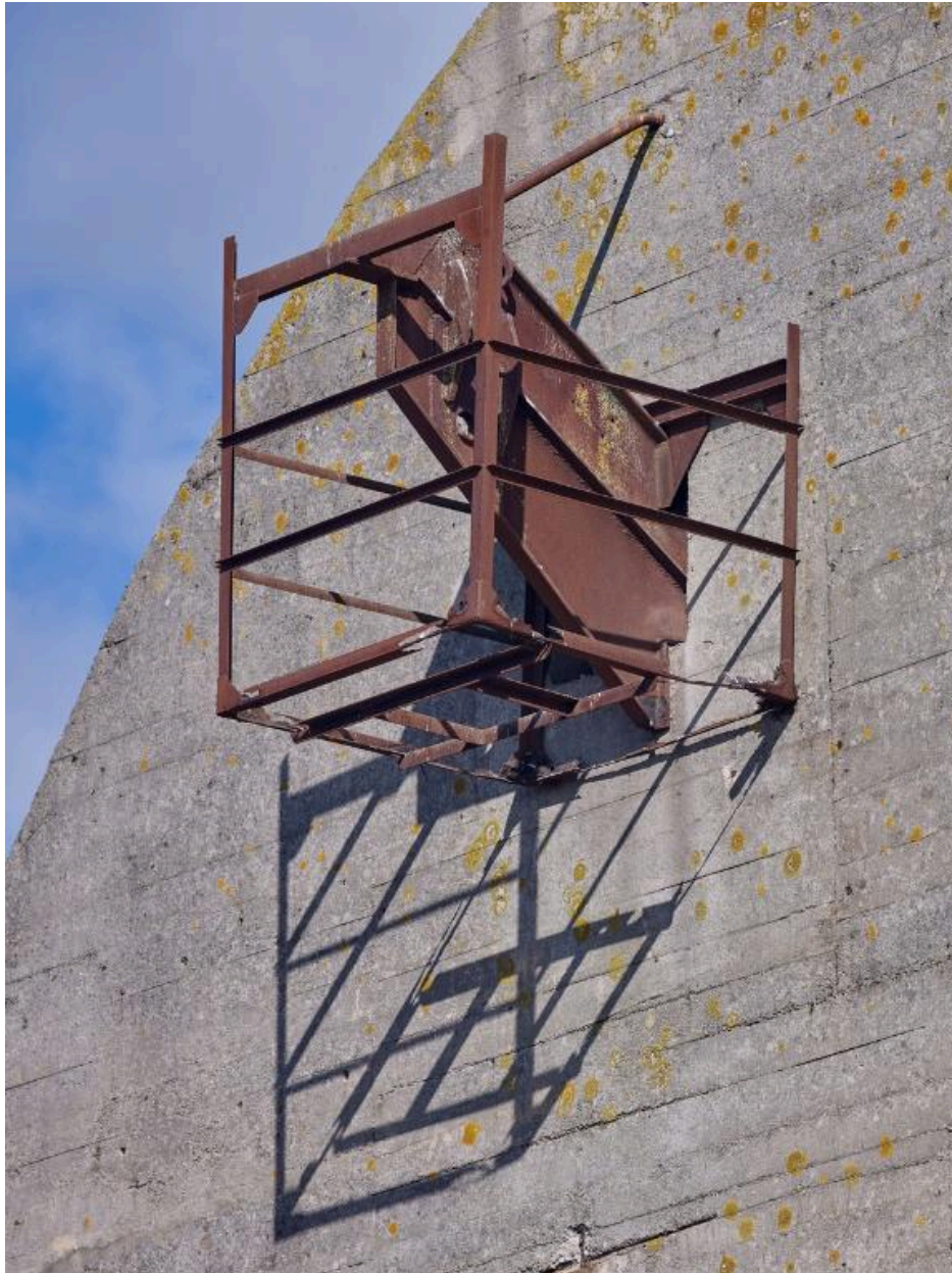
Vue de détail du pignon sud : système non identifié
