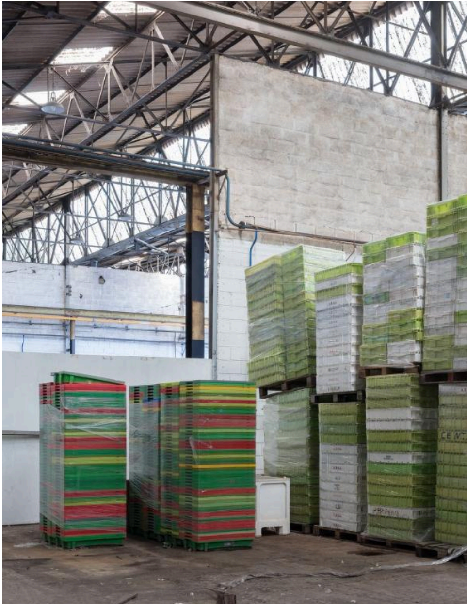
Vue intérieure du bâtiment accolé au Dom-bunker : stockage de bacs à marée (ce bâtiment a été déconstruit)
