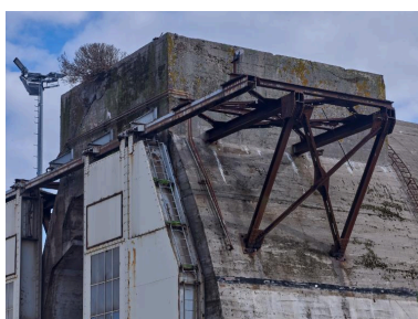
Vue nord : l'un des deux volets de la porte blindée est ouvert. Le bunker est surmonté par un encuvement pour canon antiaérien Phot. Bernard Bègne IVR53_20225600526NUCA
