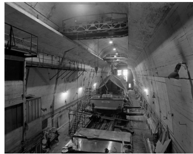
Vue générale de la nef vers le nord (état en 2000, chantier naval en activité) : navire en réparation. Au plafond, le pont roulant et son treuil en fonctionnement Phot. Bernard Bègne IVR53_20005600579X
