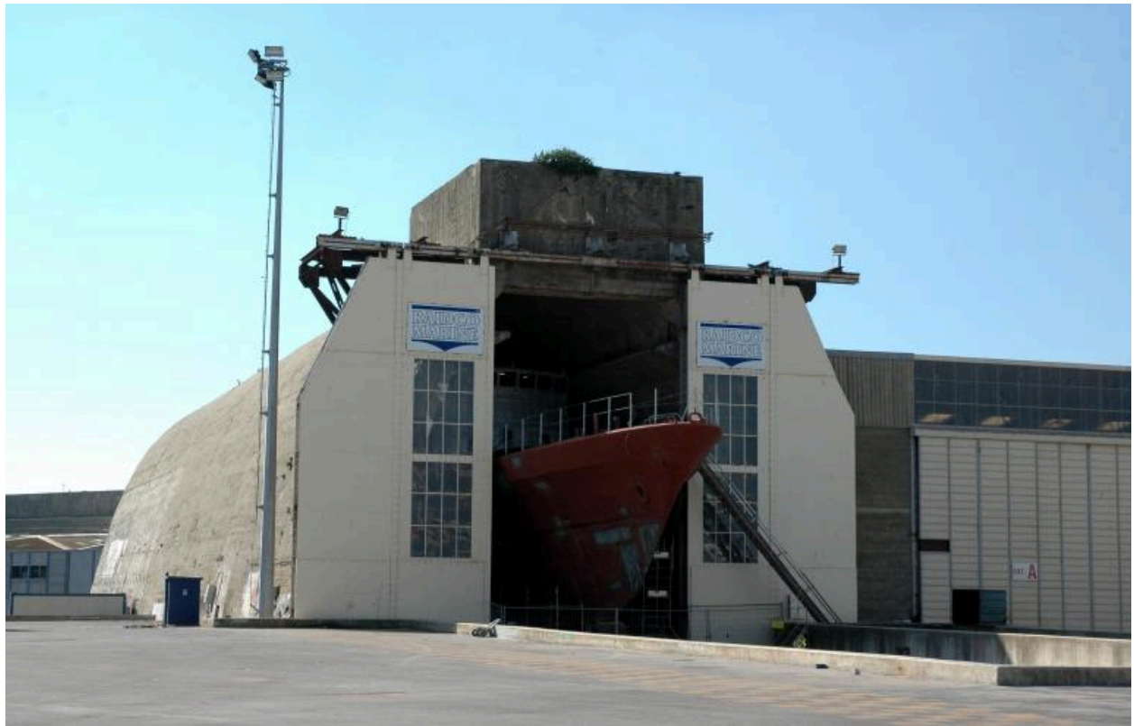
Vue générale depuis le nord (2005) : un navire est en travaux à l'intérieur de la nef
