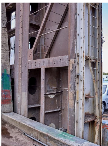
Vue de l'un des deux volets de la porte blindée nord. La porte est assemblée comme une double coque de bateau Phot. Bernard Bègne IVR53_20225600517NUCA
