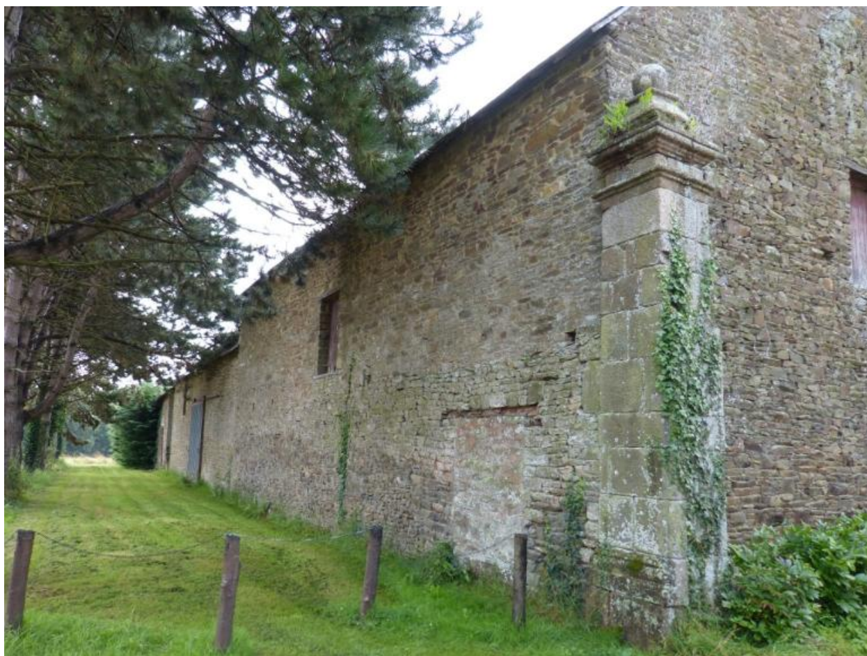
Détail - Pilier - Ancien château du Plessis
