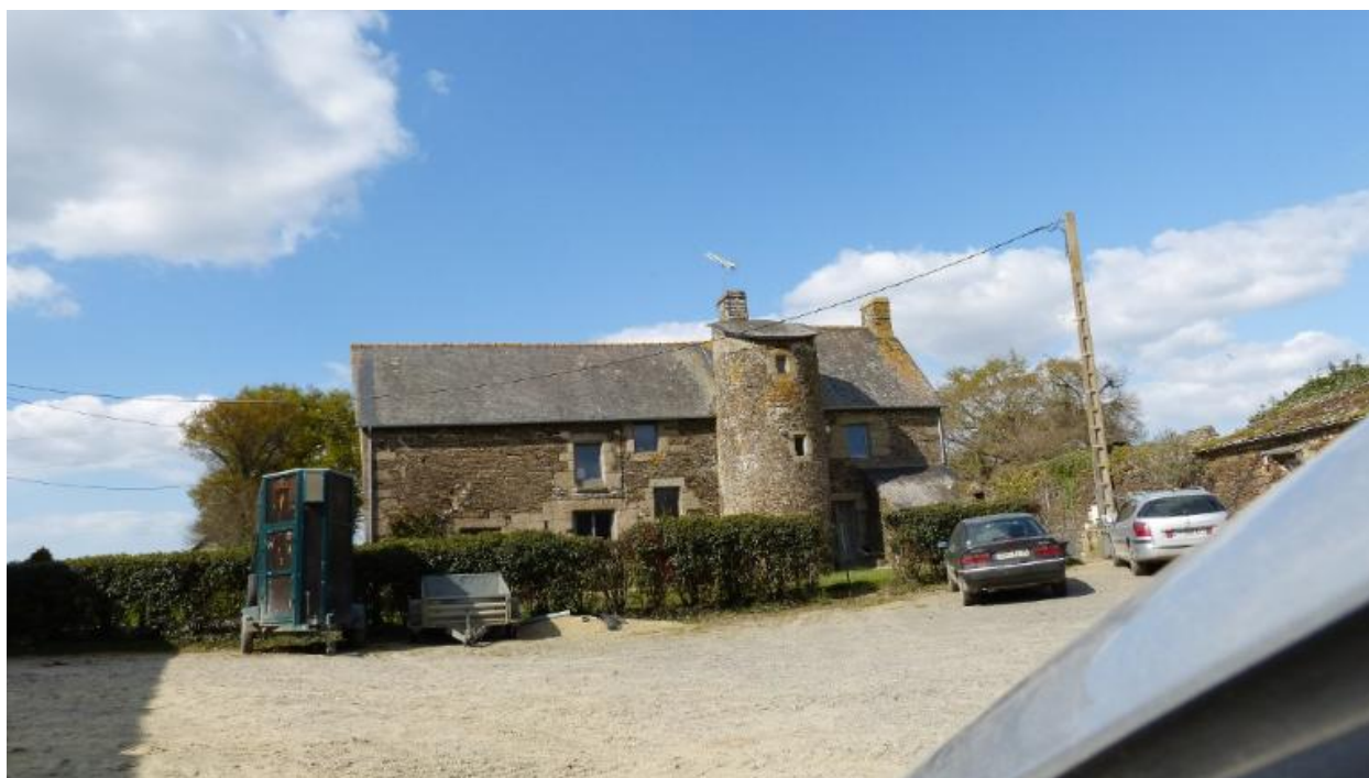
Façade avec tour orientée sud
