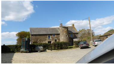
Façade avec tour orientée sud Phot. Marquet Laurence IVR53_20243530252NUCA
