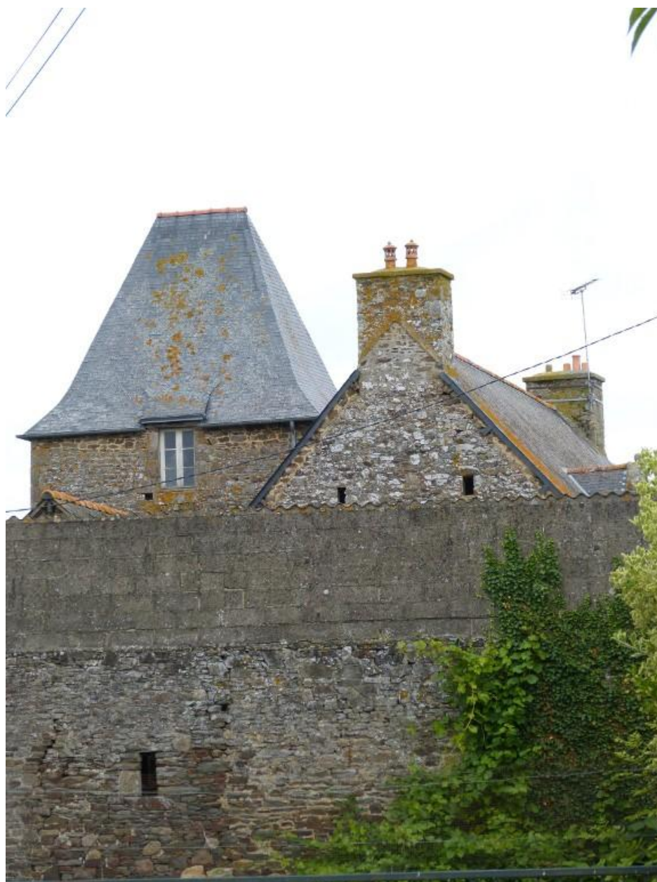
Ancien manoir - Le Val aux Breton - vue de la façade ouest - Pleine-Fougères
