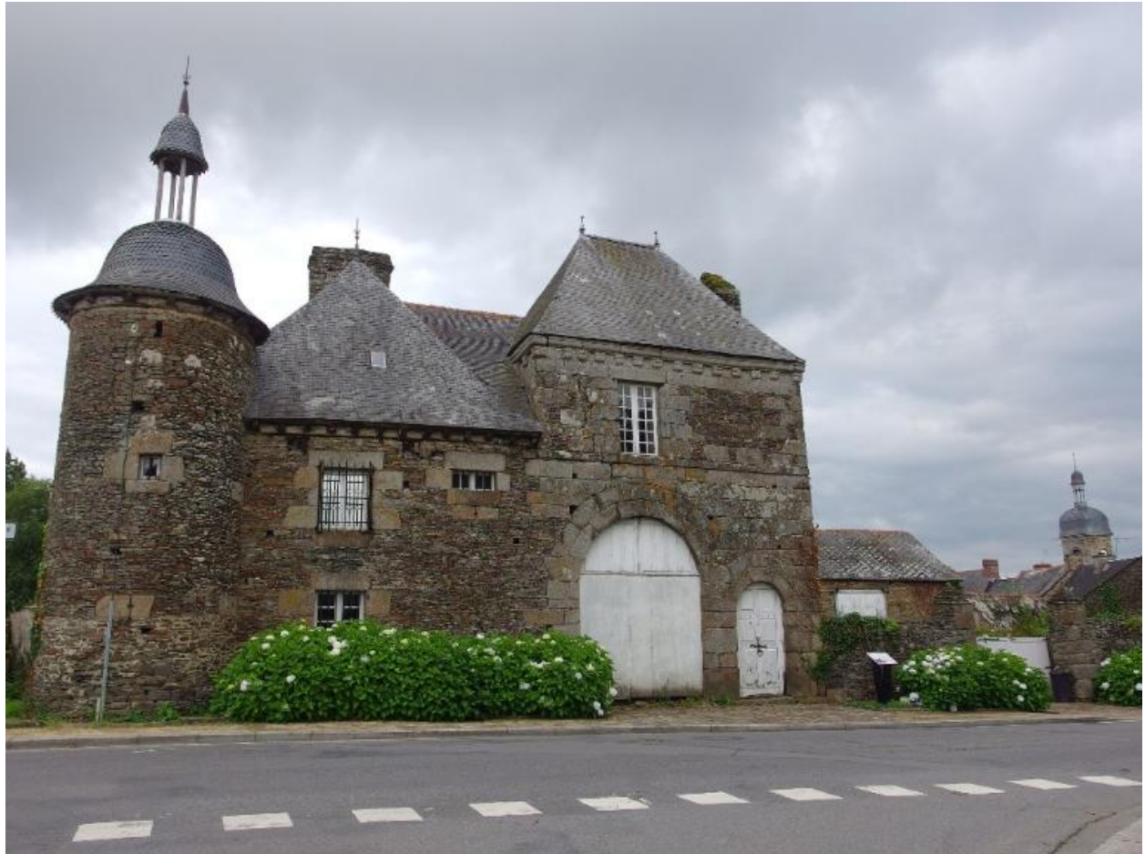
Manoir de Chauffaux - Pleine-Fougères - Vue de la porte charretière - Façade ouest
