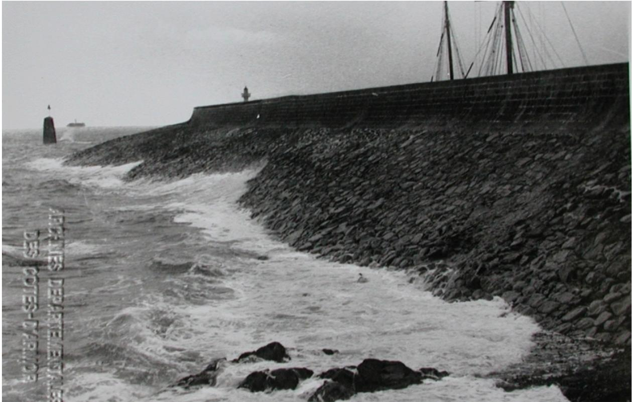
Les enrochements sous la jetée extérieure ouest, faisant brise-lames, 1er quart 20ème siècle (AD 22, Fonds Lacombe)
