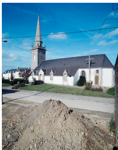
Elévation sud. Phot. Auteur inconnu IVR53_19975601025XA
