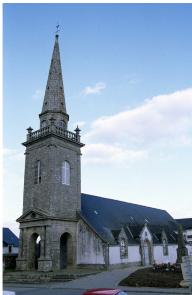
Elévation ouest, pignon et porche. Phot. Bernard Bègne IVR53_19995600245ZA
