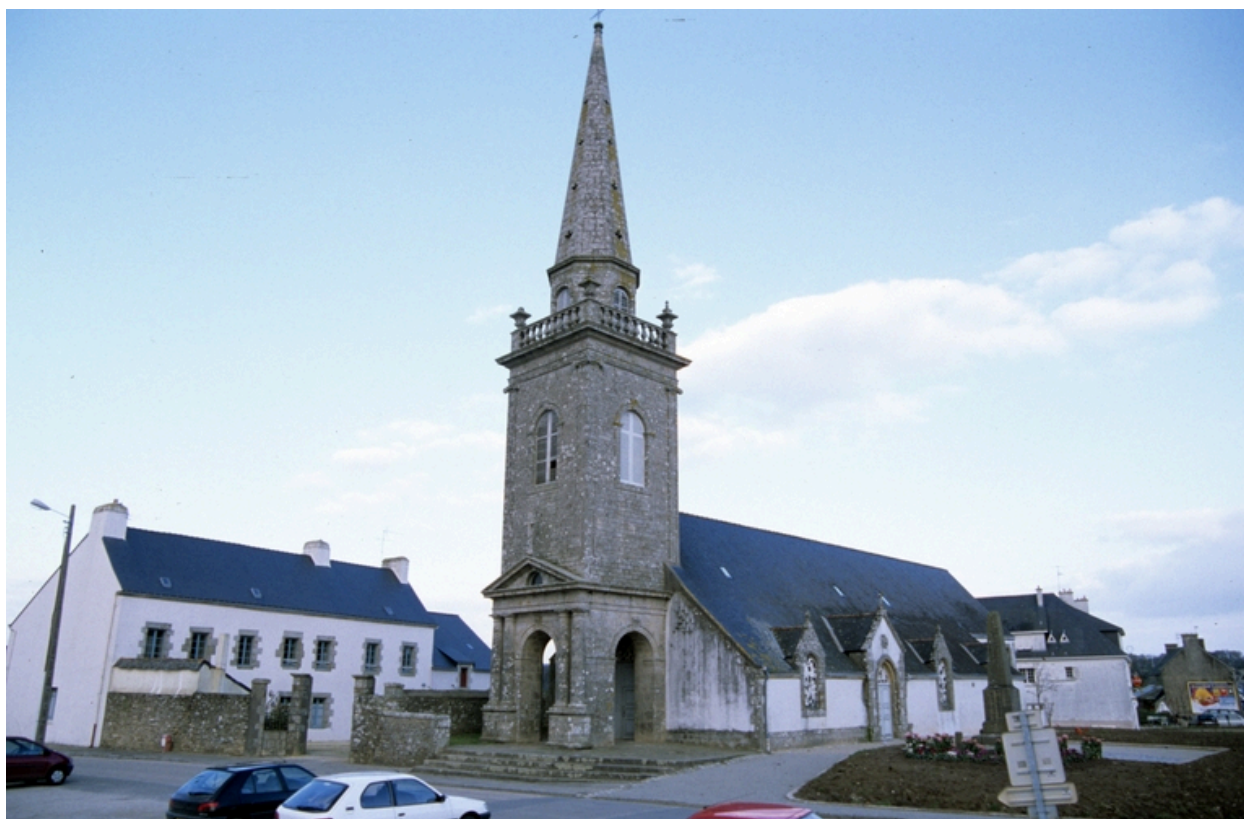
Elévation ouest, pignon et porche.
