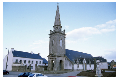
Elévation ouest, pignon et porche. Phot. Bernard Bègne IVR53_19995600246ZA
