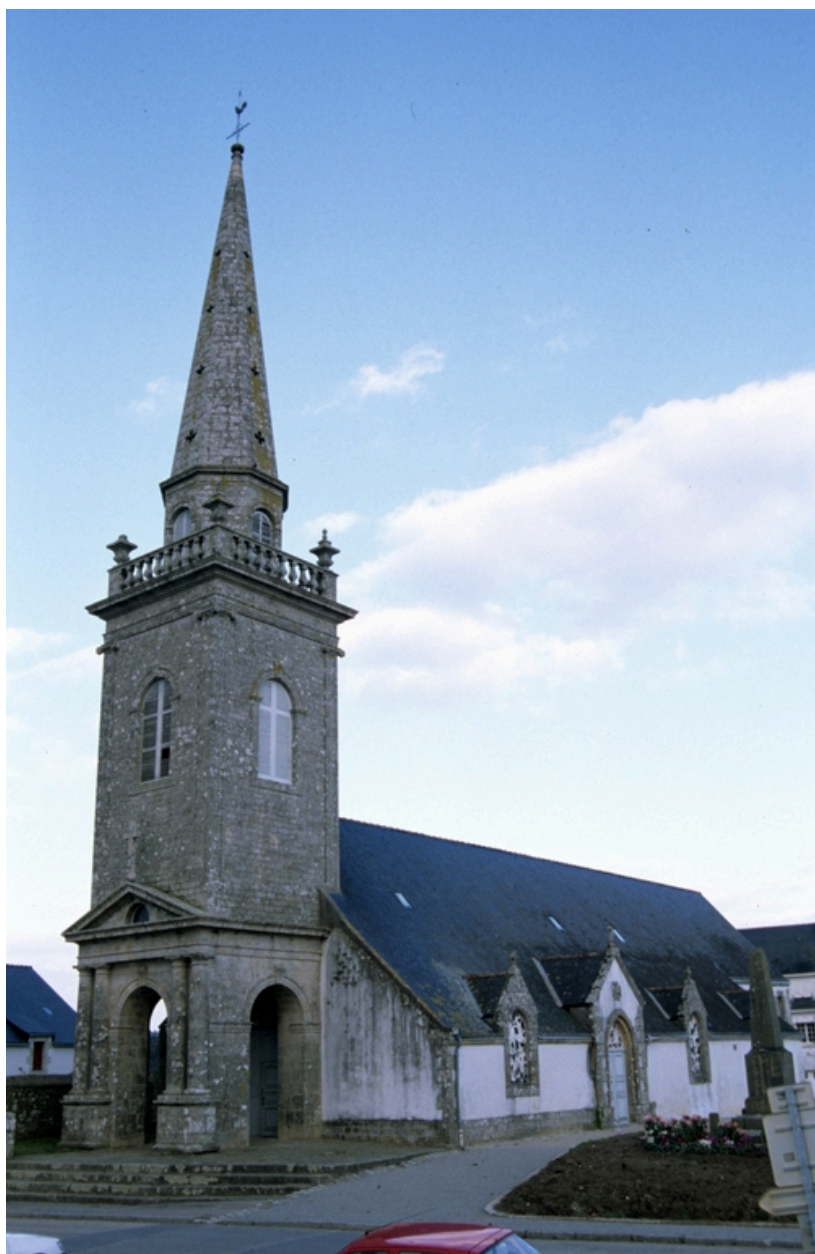
Elévation ouest, pignon et porche.
