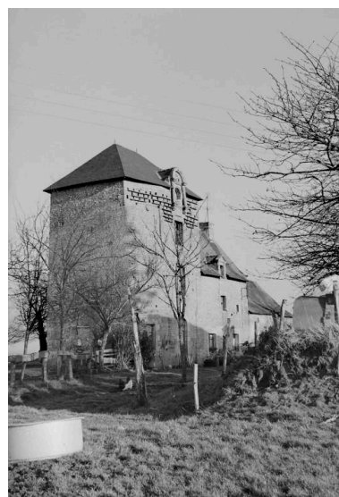
Vue générale prise du sud-ouest Phot. Auteur inconnu IVR53_20125600360Z
