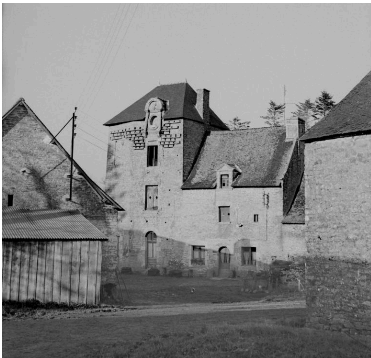
Vue générale prise du sud
