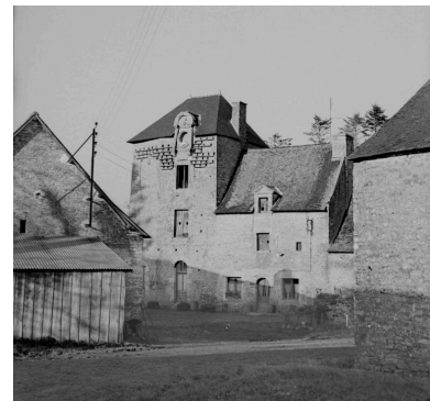
Vue générale prise du sud Phot. Auteur inconnu IVR53_20125600363Z
