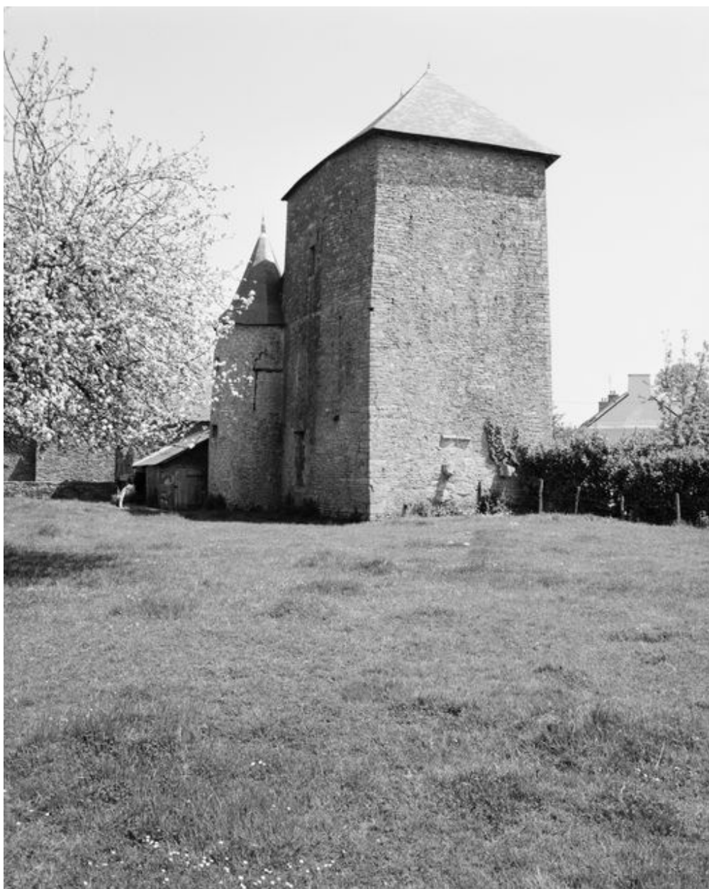
Manoir, vue générale nord-ouest.
