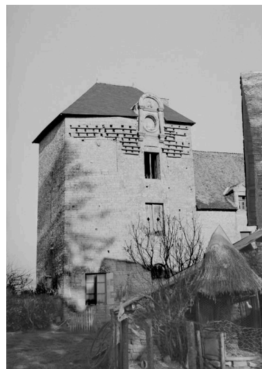
Elévation de la tour sud Phot. Auteur inconnu IVR53_20125600362Z
