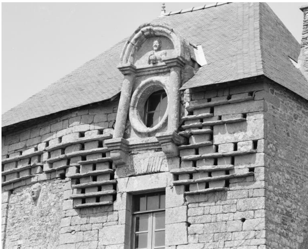
Manoir, élévation sud, lucarne.
