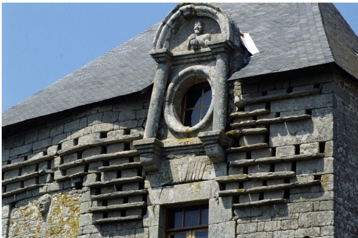
Elévation sud : lucarne
