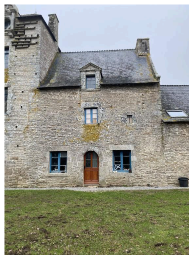
Vue sud Phot. Baptiste Oligo IVR53_20255610662NUCA
