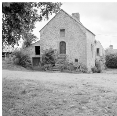
Vue générale nord-est Phot. Marie Berthou IVR53_19745600942X
