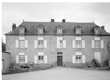
Vue d'ensemble de la façade sud. Phot. Brachet IVR53_19665601101V
