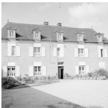
Vue d'ensemble de la façade sud. Phot. Jean-Yves Veillard IVR53_19665600823X
