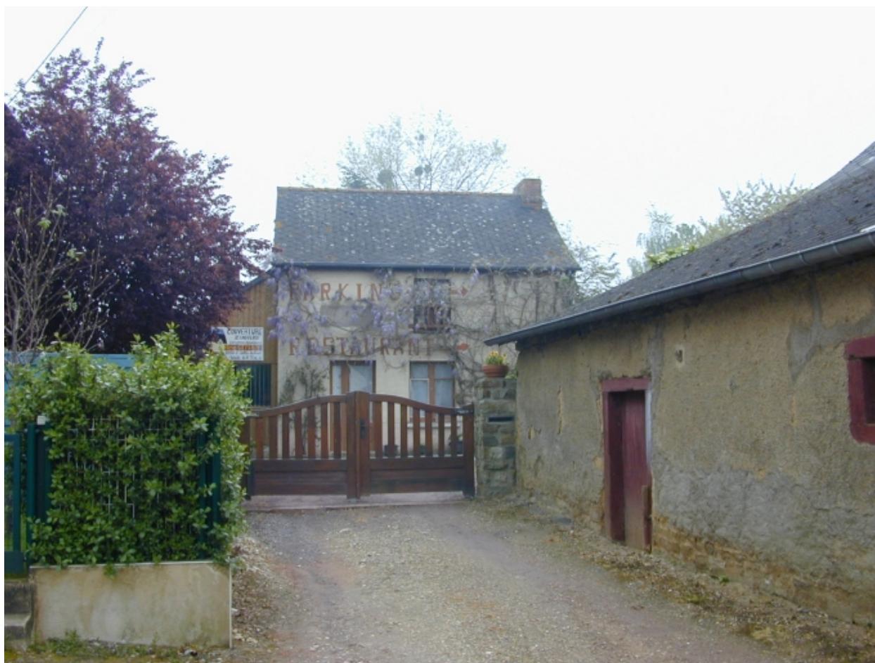
Vue générale ouest
