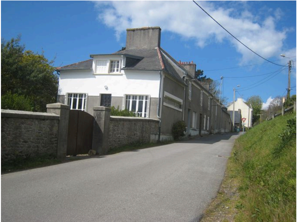
Vue générale de la briqueterie du port (le premier bâtiment a été construit postérieurement)
