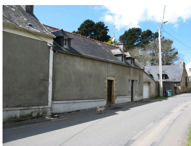
Partie distale de la briqueterie du port Phot. Guillaume Marie IVR53_20082908392NUCA
