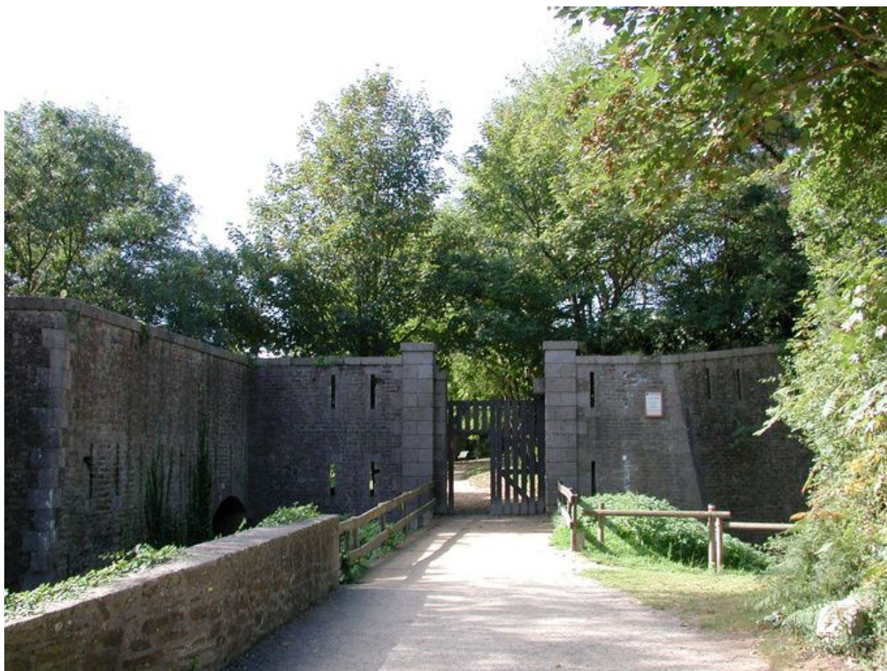
Plouzané : vue de l'entrée du fort du Dellec
