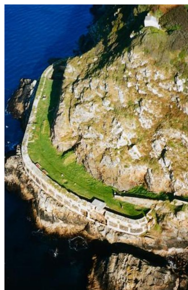
Roscanvel : vue aérienne de la Grande batterie de Cornouailles (Photographie Marine Nationale) Phot. Marine Nationale IVR53_20022902953NUCA
