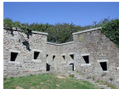
Plouzané : vue du fort du Dellec, le mur d'enceinte est percé de meurtrières et d'assomoirs Phot. Guillaume Lécueillier IVR53_20022903032NUCA
