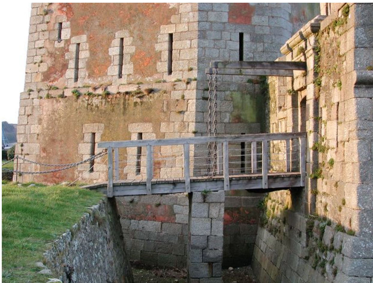
Camaret-sur-Mer : vue du pont-levis flanqué par la tour à gauche
