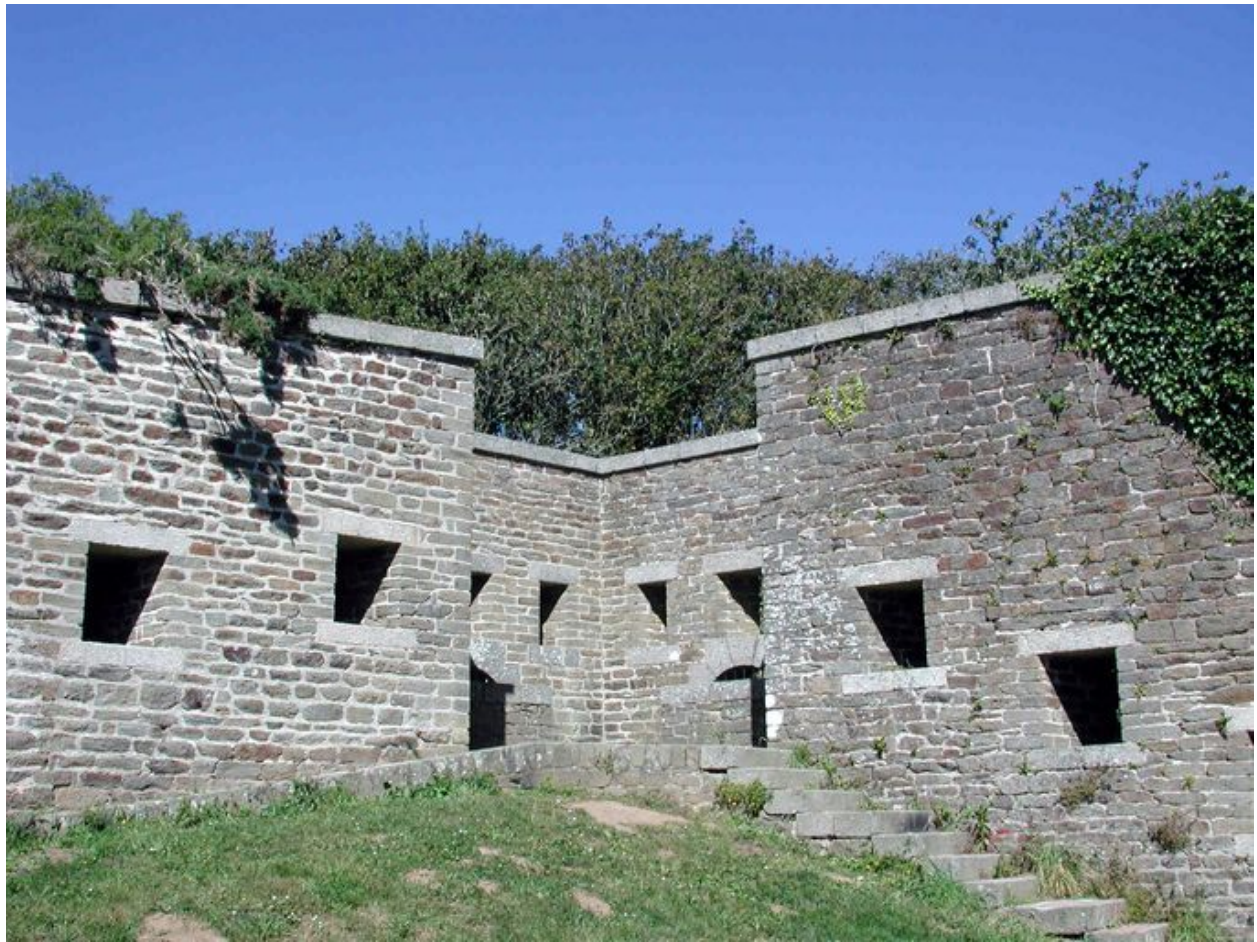
Plouzané : vue du fort du Dellec, le mur d'enceinte est percé de meurtrières et d'assomoirs
