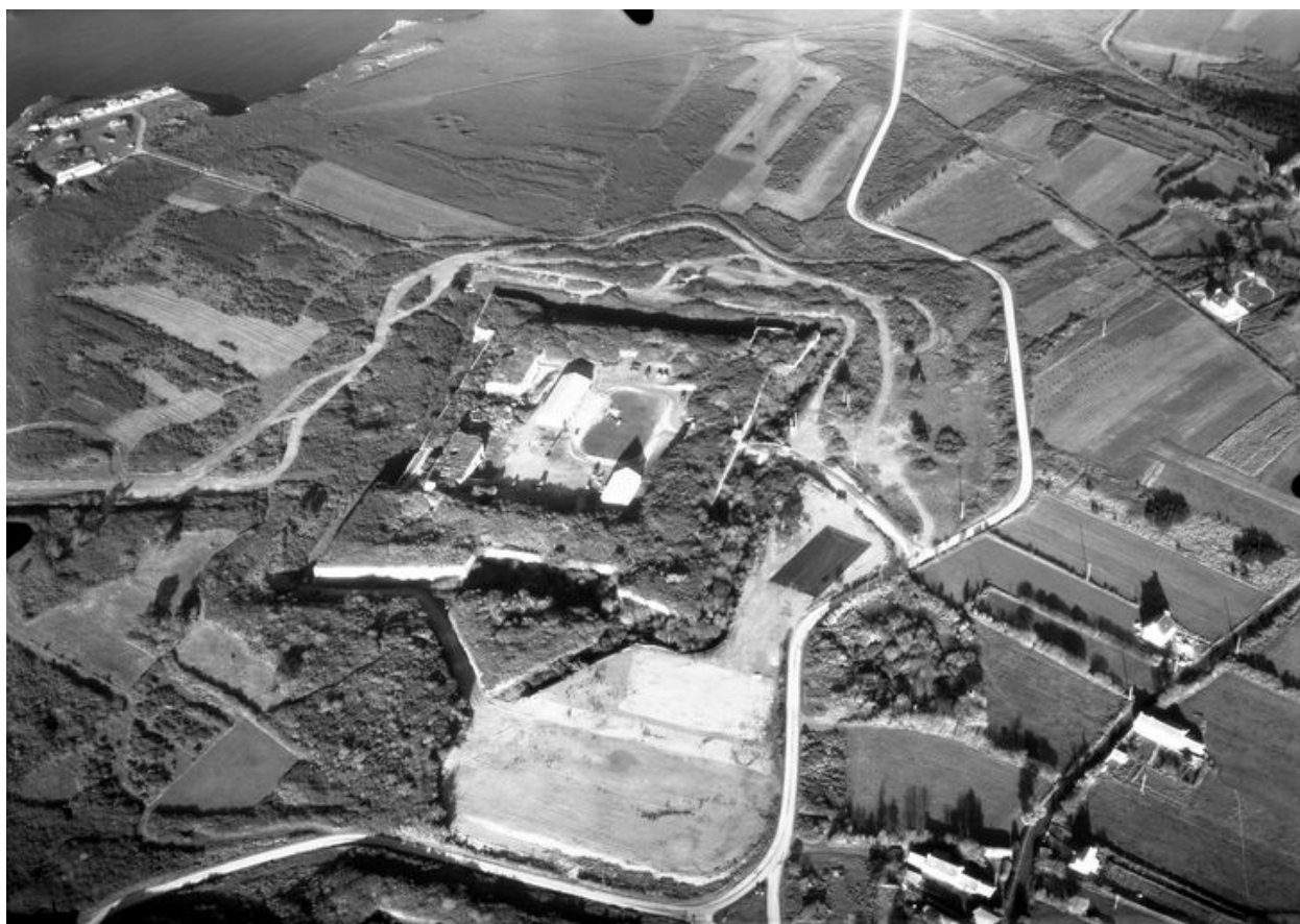
Rosvanvel : vue aérienne du réduit de Quélern en 1971
