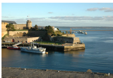
Brest : vue du château de Brest depuis le Jardin des Explorateurs Phot. Guillaume Lécueillier IVR53_20042904274NUCA
