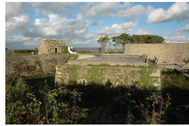
Plougonvelin : vue générale du réduit et du corps de garde de la pointe de Créac'h Meur Phot. Guillaume Lécueillier IVR53_20042903823NUCA
