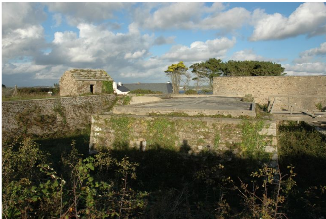
Plougonvelin : vue générale du réduit et du corps de garde de la pointe de Créac'h Meur
