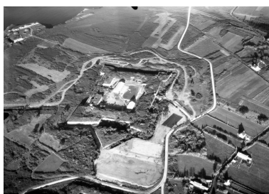
Rosvanvel : vue aérienne du réduit de Quélern en 1971 Phot. Guy Artur, Phot. Norbert Lambart IVR53_19712900617P
