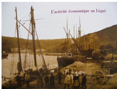
Scène de déchargement dans le bassin à flot, début 20ème siècle (AD 22) Repro. Guy Prigent IVR53_20082213378NUCB
