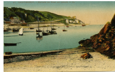
Vue des bateaux de pêche de sous-la-Tour, vers 1920 (AD 22) Phot. Auteur inconnu IVR53_20082212937NUCB
