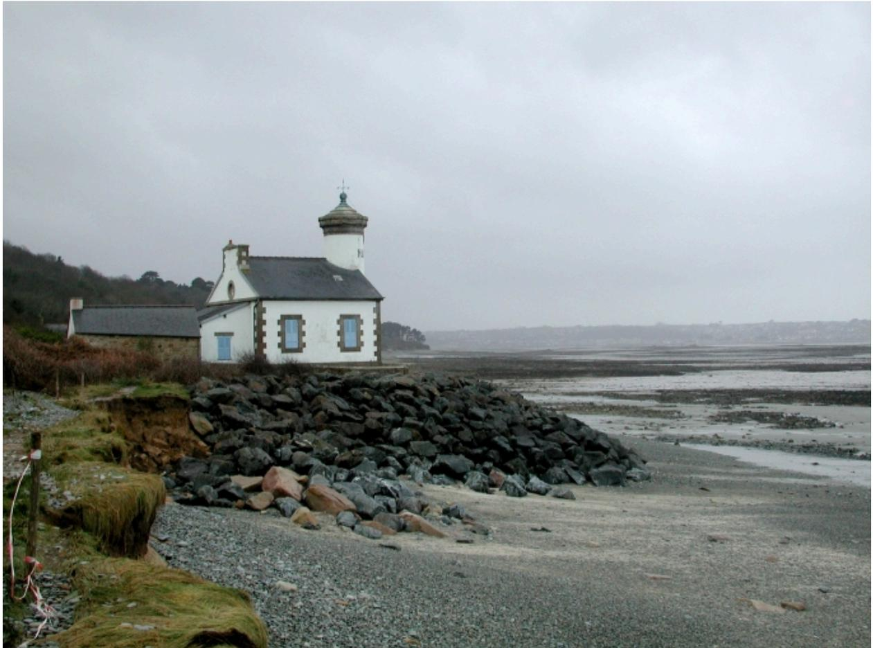
Vue en détail de la brèche dans le sentier de la micro-falaise : la rangée inférieure des blocs est déchaussée
