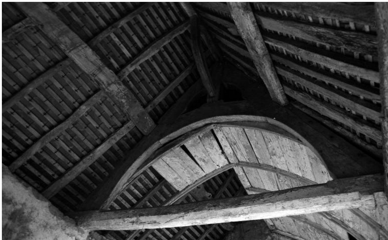
Plouzelambre, le bourg, enclos paroissial : ossuaire, charpente ancienne dépourvue de lambri (l'unique cours de pannes confirme qu'ils s'agit d'un petit volume), photographie de 1974
