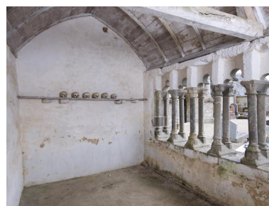
Plouzélambre, le bourg, enclos paroissial : ossuaire, vue intérieure, étagère murale supportant six boîtes crâniennes humaines Phot. Bernard Bègne IVR53_20152200543NUCA
