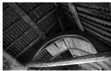
Plouzélambre, le bourg, enclos paroissial : ossuaire, charpente ancienne dépourvue de lambris (l'unique cours de pannes confirme qu'ils s'agit d'un petit volume), photographie de 1974 IVR53_19742205099Z
