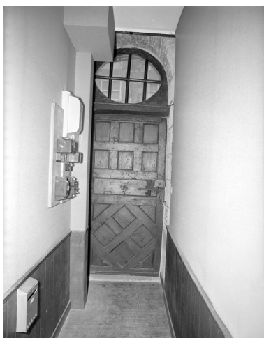
11 rue Nationale, revers de la porte d'entrée. Phot. Guy Artur IVR53_19783500246X
