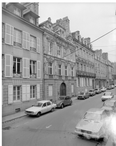
32 rue Nationale, vue de la façade antérieure. Phot. Guy Artur IVR53_19783500259X
