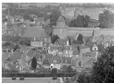
Ville Basse, église Saint Sulpice et château, vue prise du sud. Phot. Guy Artur IVR53_19783500588V
