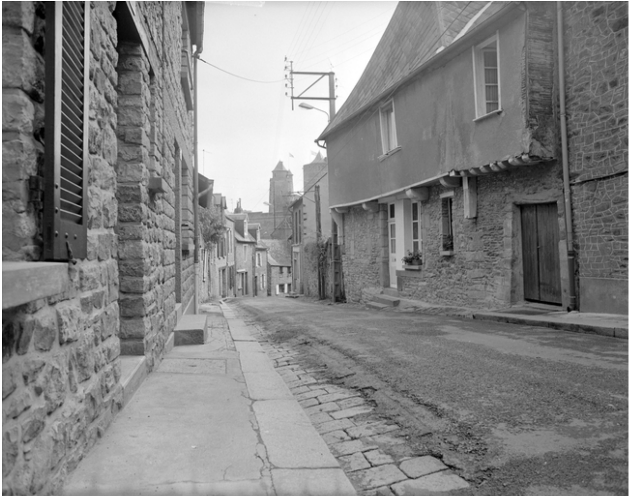
Agglomération, rue des fontaines, vue générale.
