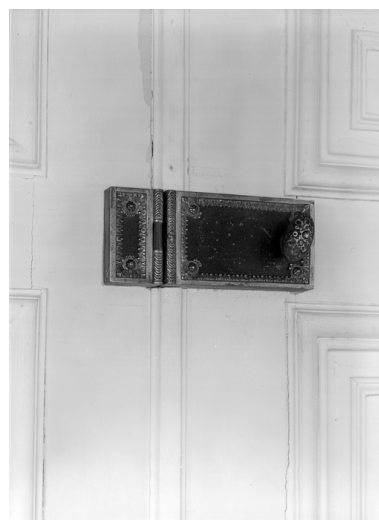
32 rue Nationale, salle à manger, serrure, vue de détail. Phot. Guy Artur IVR53_19853500100V
