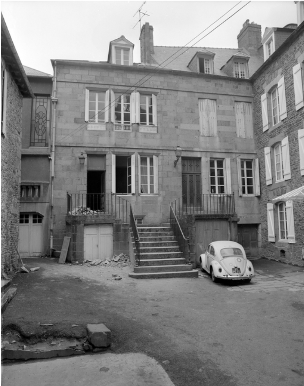
12 rue Nationale, vue générale.
