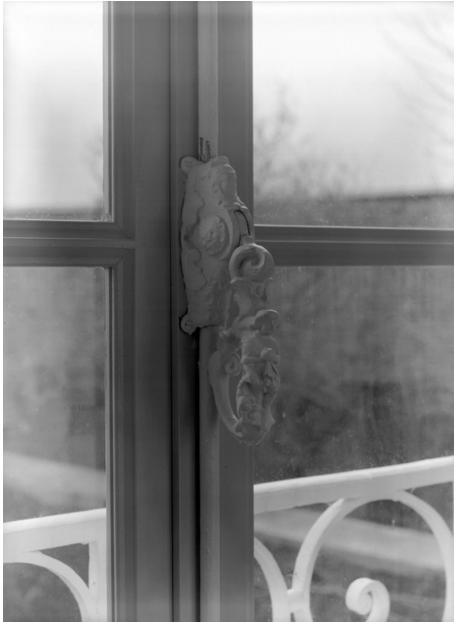
32 rue Nationale, salon, poignée de la porte fenêtre, vue de détail.
