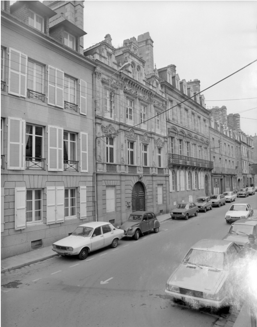
32 rue Nationale, vue de la façade antérieure.
