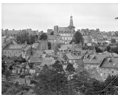
Ville Haute, vue centrée sur la maison 17 rue du Beffroi. Phot. Guy Artur IVR53_19783500595X
