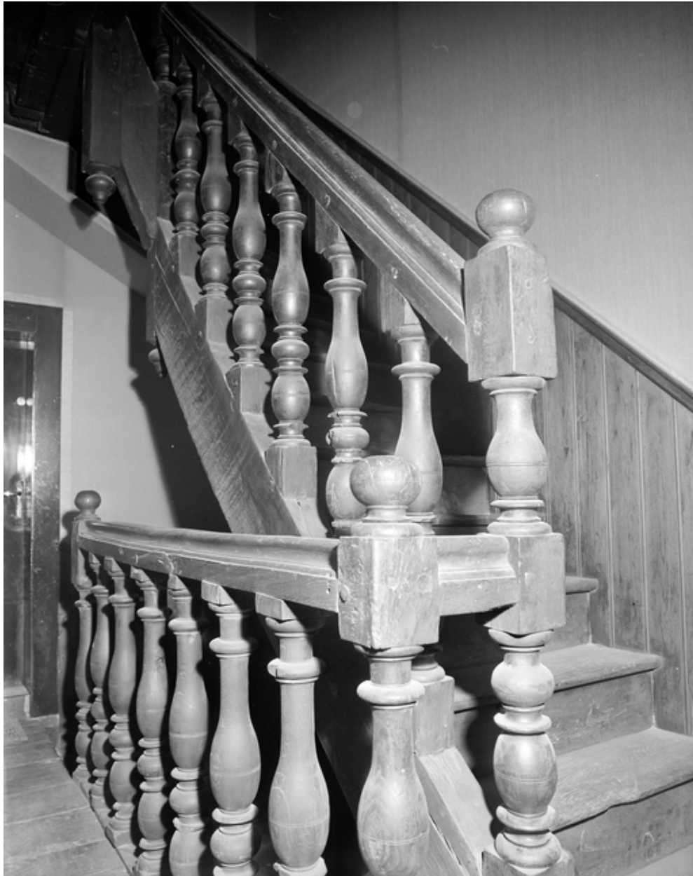
11 rue Nationale, escalier, volées du deuxième étage..
