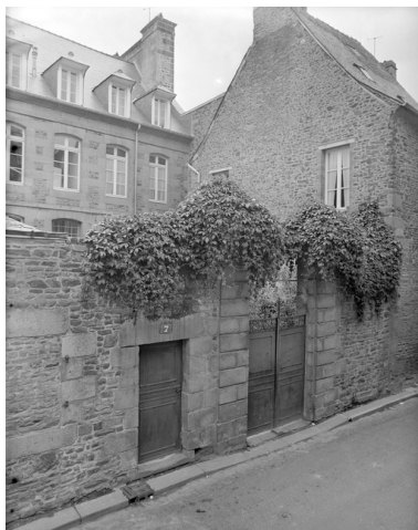
7 rue Lesueur, vue générale. Phot. Guy Artur IVR53_19783500282X
