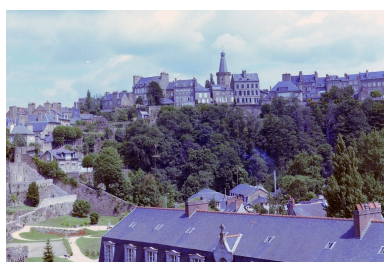
Ville haute intra muros, côté ouest, vue générale. Phot. Guy Artur IVR53_19783500661XE
