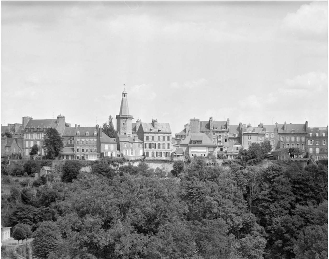
Ville haute intra muros, côté ouest, face ouest des maisons de la rue du Beffroi.
