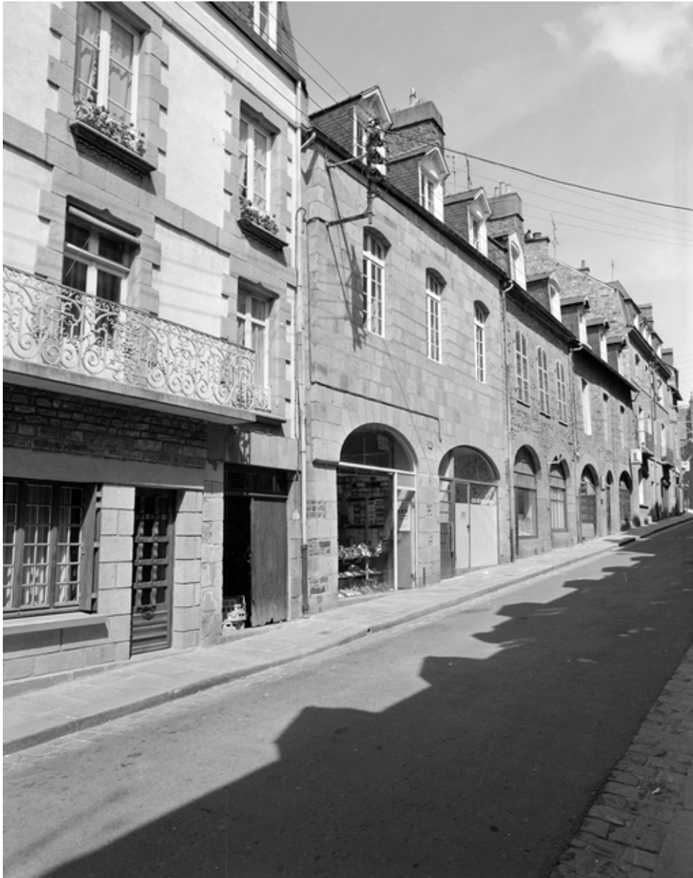
18 rue de la Pinterie, vue générale sud-ouest..
