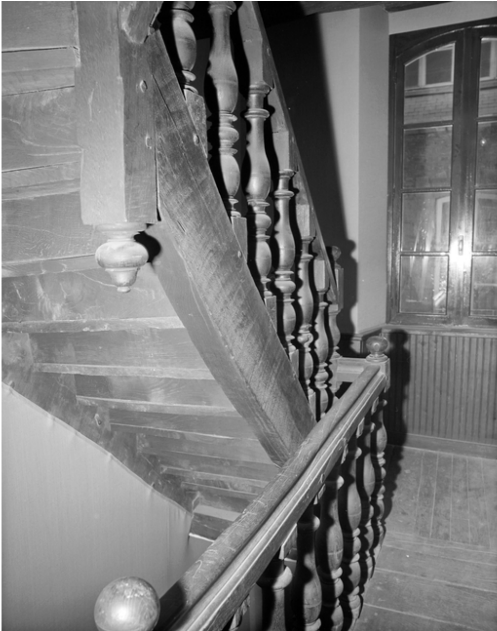
11 rue Nationale, escalier, volées du deuxième étage.
