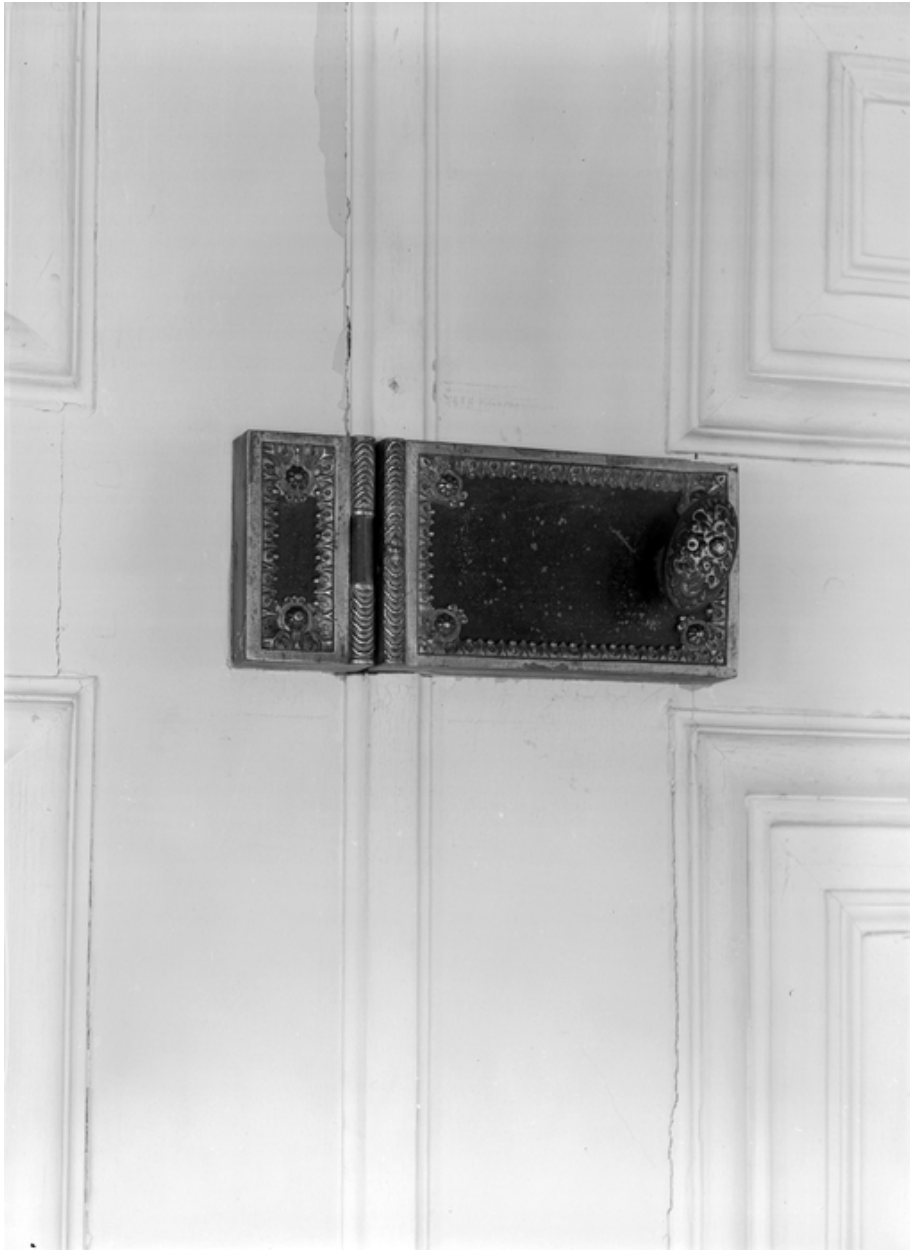
32 rue Nationale, salle à manger, serrure, vue de détail.
