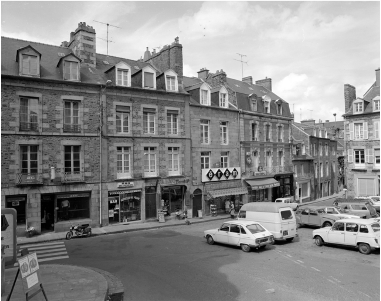
Place du théâtre, vue générale de la place, côté nord.
