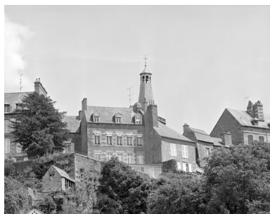
Ville Haute, vue centrée sur la maison 15 rue du Beffroi. Phot. Guy Artur IVR53_19783500591X
