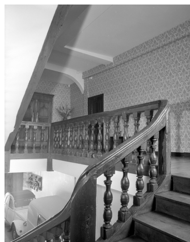
25 rue Chateaubriand, escalier, palier de l'étage. Phot. Guy Artur IVR53_19783500377X
