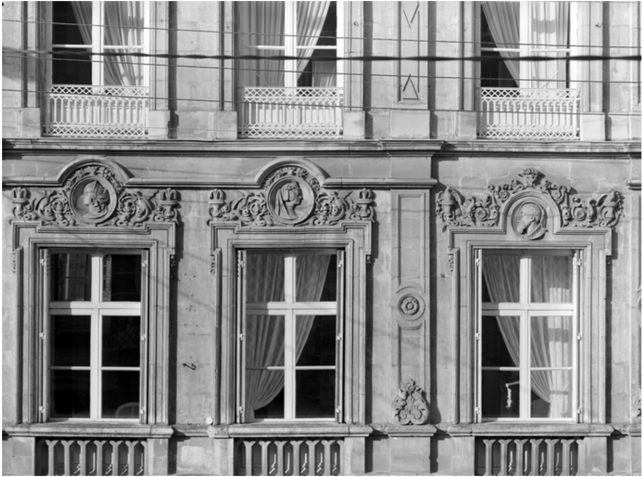
32 rue Nationale, détail d'un linteau à têtes sculptées.
