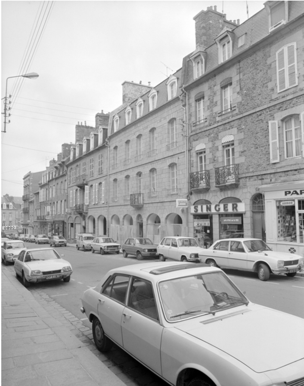
15 rue Nationale, élévation antérieure, vue générale.
