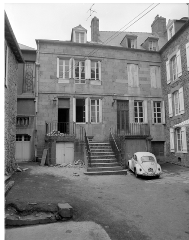
12 rue Nationale, vue générale. Phot. Guy Artur IVR53_19783500238X
