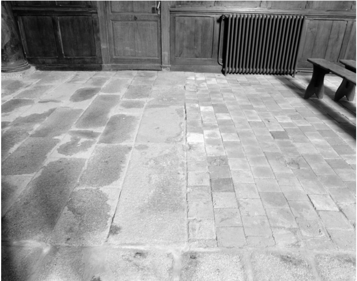
Chapelle des Recollets, 88 rue de la Forêt, vue générale du sol.
