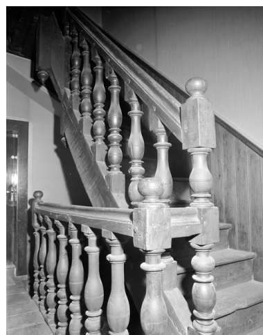
11 rue Nationale, escalier, volées du deuxième étage. Phot. Guy Artur IVR53_19783500247X
