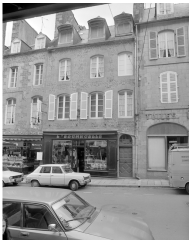
Rue Nationale, vue générale. Phot. Guy Artur IVR53_19783500244X
