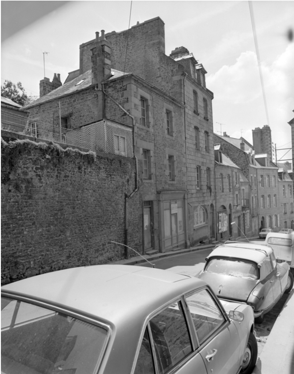
21 rue de la Pinterie, vue générale nord-est.
