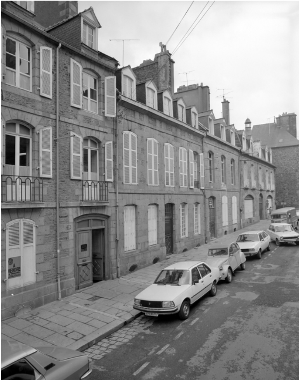
20, 23 et 25 rue Chateaubriand, vue générale nord-ouest.
