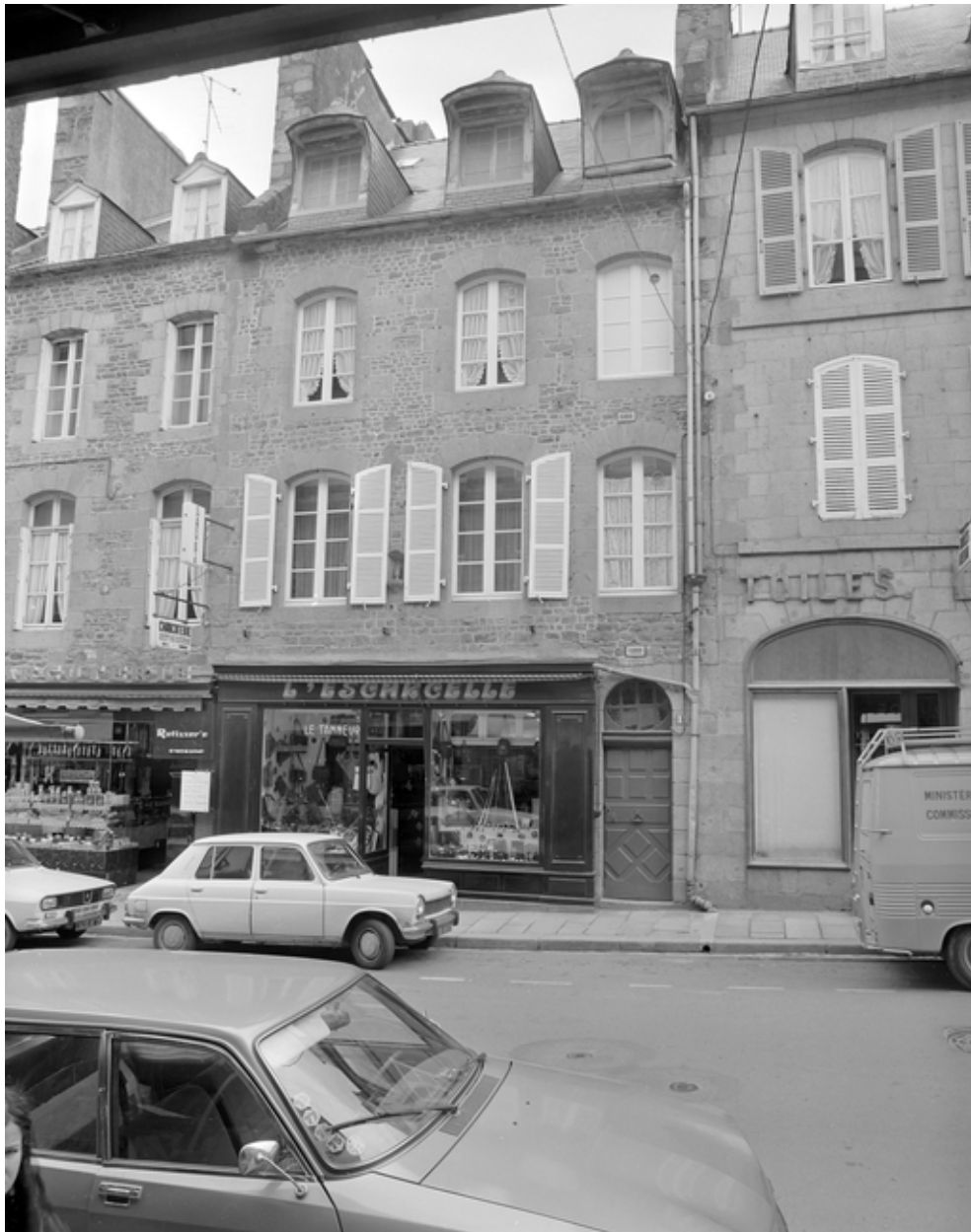
Rue Nationale, vue générale.
