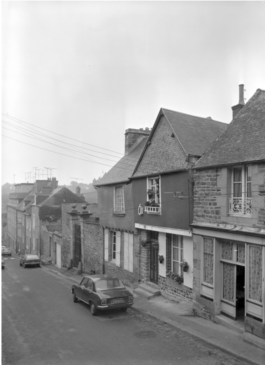
35 rue de Rillé, façade est, vue générale.
