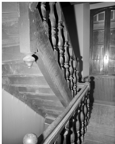
11 rue Nationale, escalier, volées du deuxième étage. Phot. Guy Artur IVR53_19783500248X
