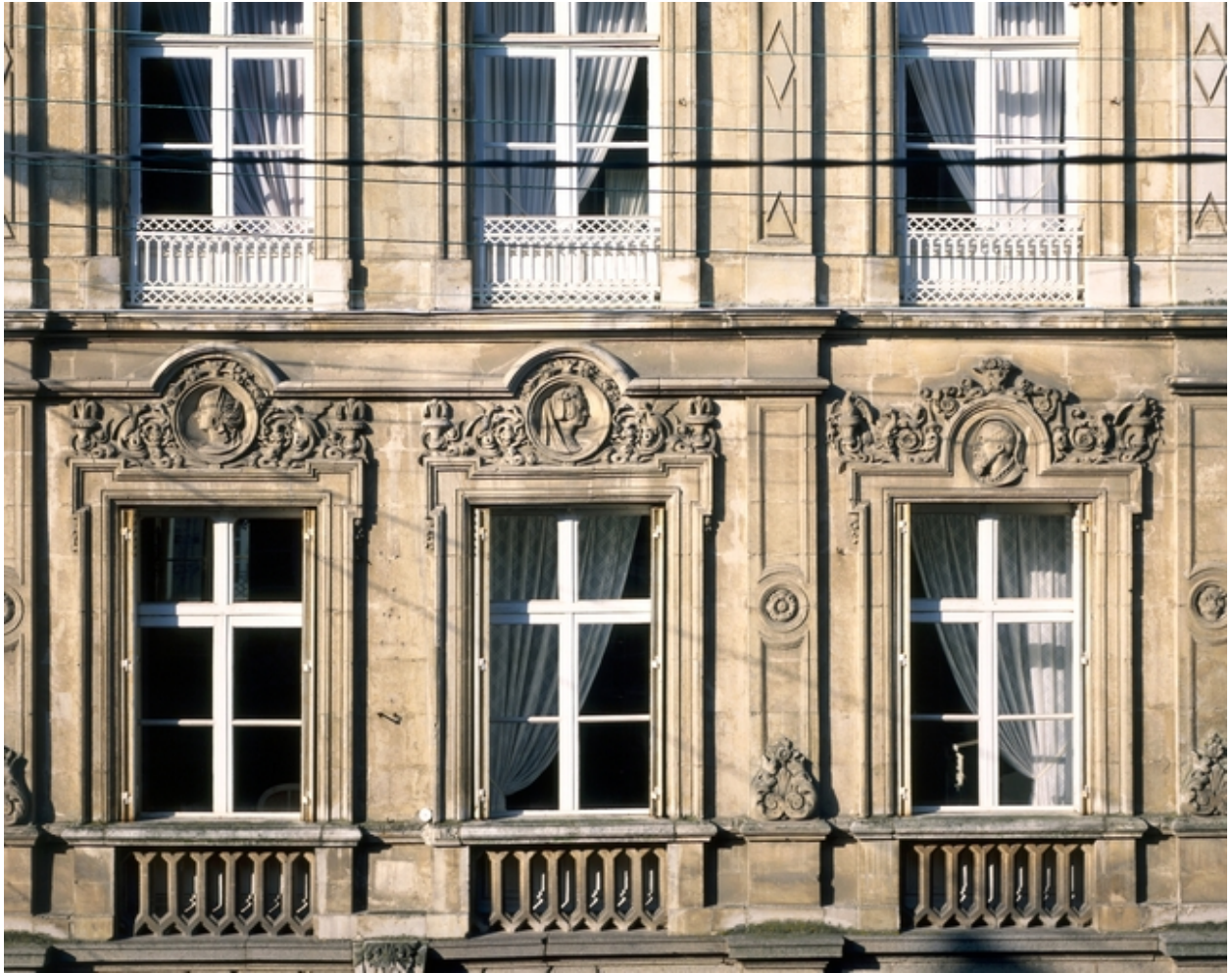
32 rue Nationale, détail d'un linteau à têtes sculptées.
