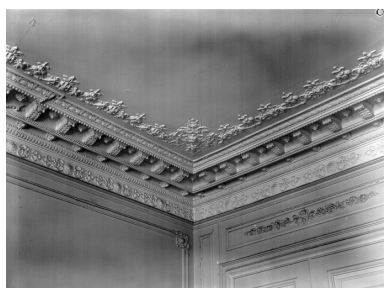
32 rue Nationale, 1er étage, salle sur rue, plafond, décor, vue générale. Phot. Guy Artur IVR53_19853500096V
