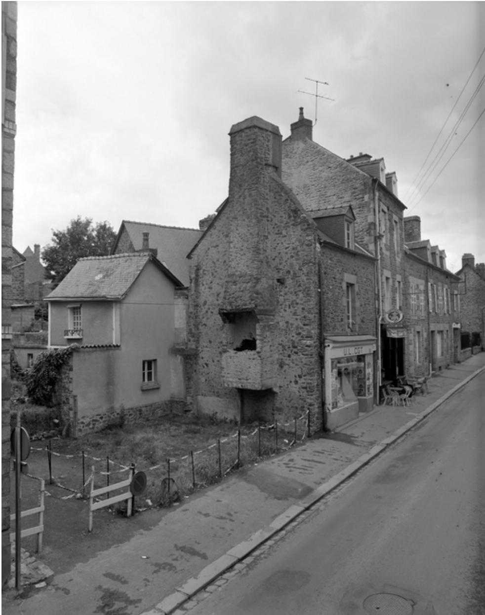
79 rue de la Forêt, cheminée d'une maison détruite, vue générale.
