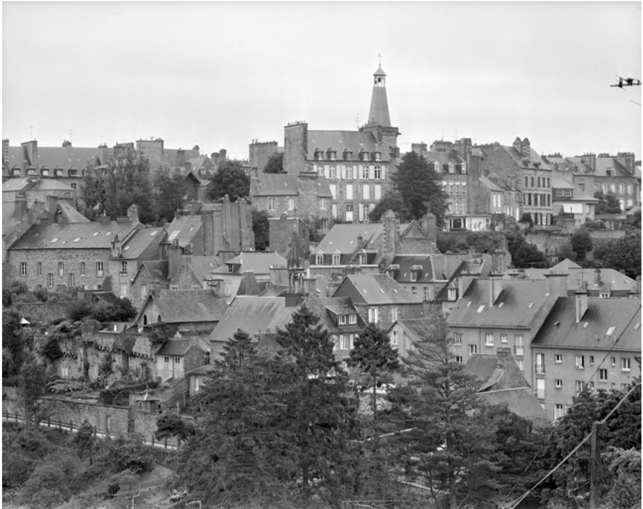
Ville Haute, vue centrée sur la maison 17 rue du Beffroi.
