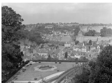
Ville Basse, église Saint Sulpice et château, vue prise du sud. Phot. Guy Artur IVR53_19783500589V
