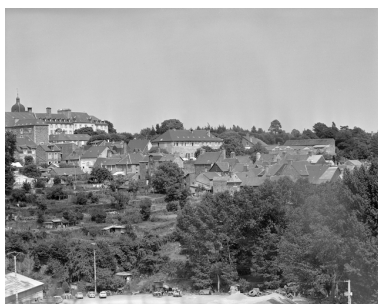
Faubourg de Rillé, vue générale ouest. Phot. Guy Artur IVR53_19783500596X
