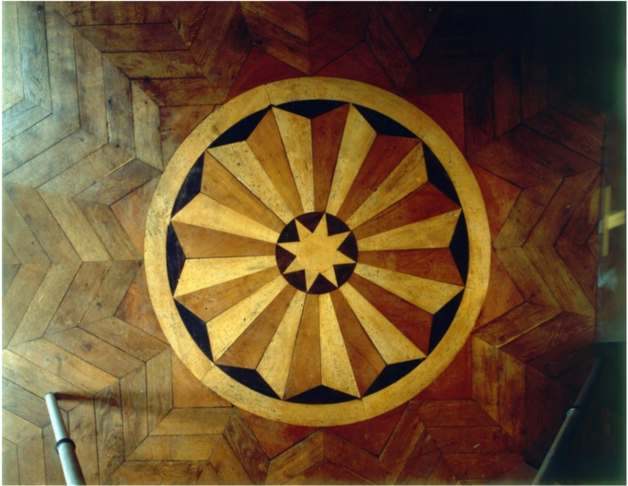
32 rue Nationale, 1er étage, salle sur rue, parquet, motif central, vue de détail.
