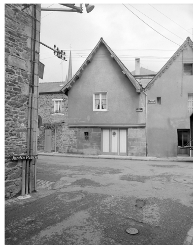
Agglomération, rue Savigny, vue générale. Phot. Guy Artur IVR53_19783500228X
