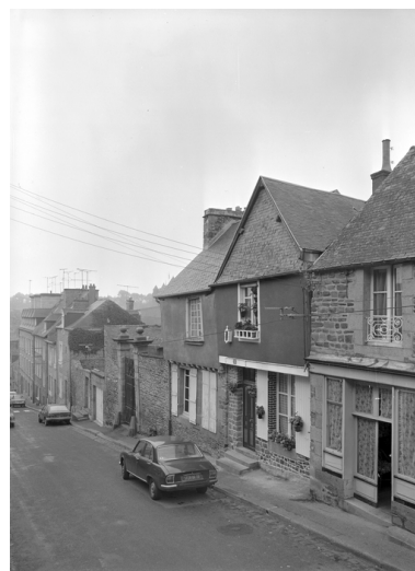
35 rue de Rillé, façade est, vue générale. Phot. Guy Artur IVR53_19783500560V
