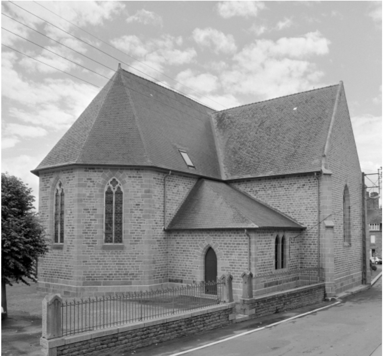
Elévation Nord-Est : vue générale
