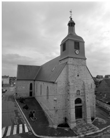
Elévation Ouest : vue générale Phot. Guy Artur, Phot. Norbert Lambart IVR53_19943501308X
