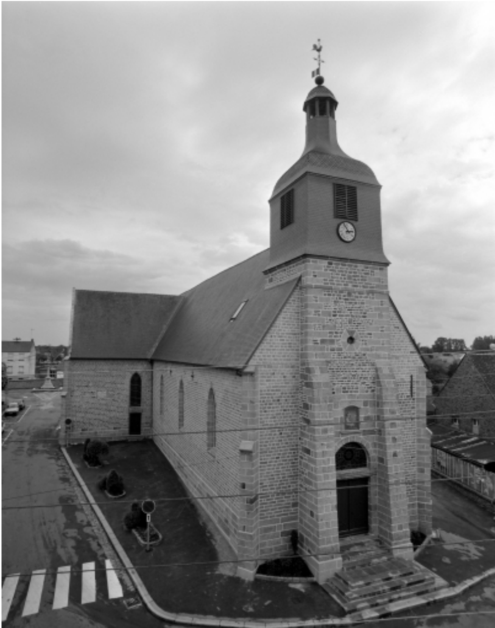
Elévation Ouest : vue générale
