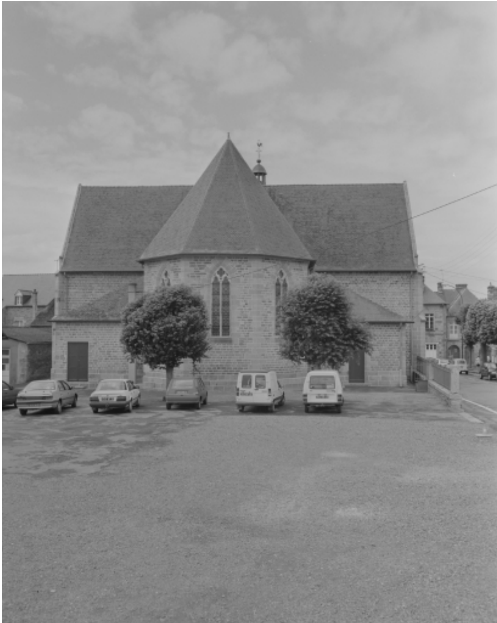
Elévation est : vue générale
