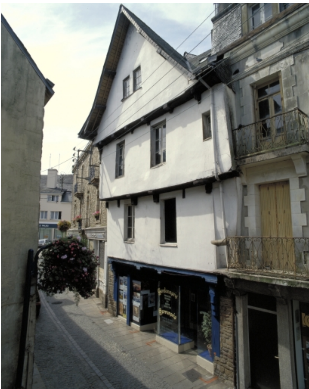
Elévation est sur rue (état en 2001)
