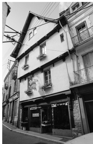
Façade est sur rue, état en 1974 Phot. Marie-Madeleine Tugores IVR53_19742907176Z
