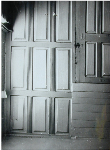
Premier étage, vestiges de boiseries. Etat en 1974 (cl. M. M. Tugorès) Repro. Christel Douard IVR53_20032901398NUCA
