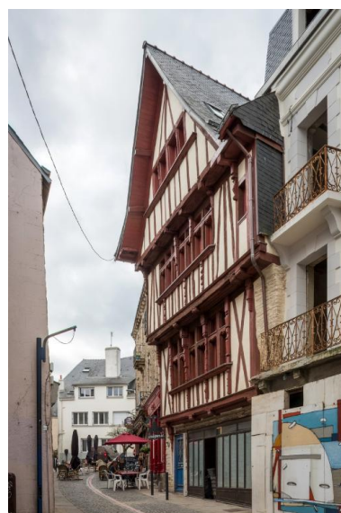
Élévation est sur rue (état en 2022) Phot. Charlotte Barraud IVR53_20222900500NUCA
