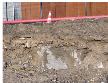
Vue depuis le sud (couverture photographique du 22 janvier 2026). Seul un pan de mur du bunker est visible depuis le chantier de la gare maritime du Naye. Au-dessus du bunker se trouve un transformateur électrique Phot. Bernard Bègne IVR53_20263500075NUCA
