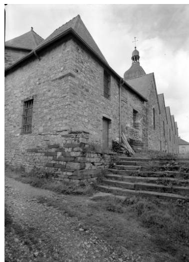
Elévation nord-est : vue générale Phot. Guy Artur IVR53_19683500453V
