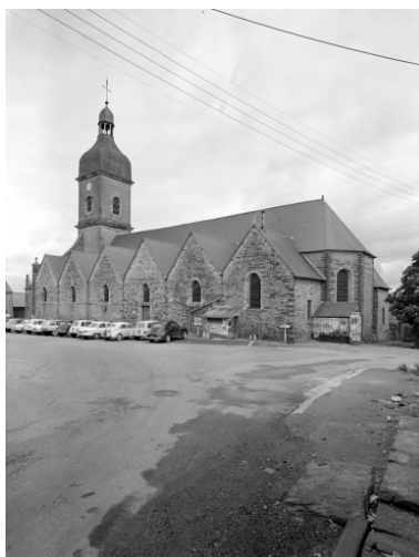
Elévation sud : vue générale Phot. Guy Artur IVR53_19683500452V
