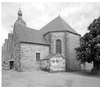
Elévation Est : vue générale Phot. Guy Artur IVR53_19683500410V
