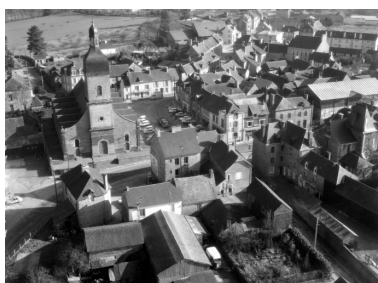
Elévation Ouest : vue aérienne Phot. G.A.L.A.T. IVR53_19713500479V
