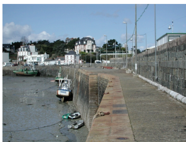
Vue de la jetée de Portrieux : remarquer le quai et le parapet
