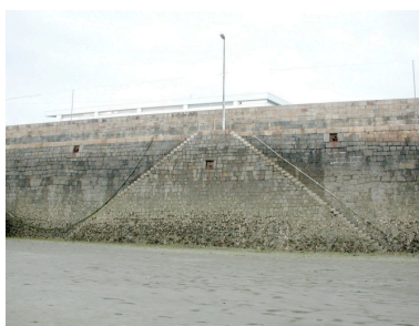
Vue des escaliers Phot. Guy Prigent IVR53_20072207773NUCA
