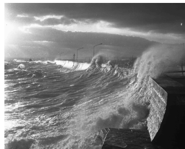
La jetée du Portrieux dans la tempête, 3ème quart 20ème siècle (AD 22, Fonds Jouas Poutrel) Repro. Guy Prigent, Autr. Joël Jouas Poutrel IVR53_20072207761NUCB
