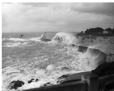
La jetée du Portrieux dans la tempête, 3ème quart 20ème siècle (AD 22, Fonds Jouas Poutrel) Repro. Guy Prigent, Autr. Joël Jouas Poutrel IVR53_20072207760NUCB
