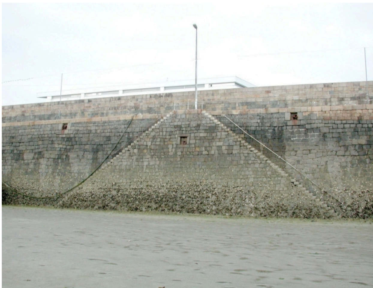
Vue des escaliers
