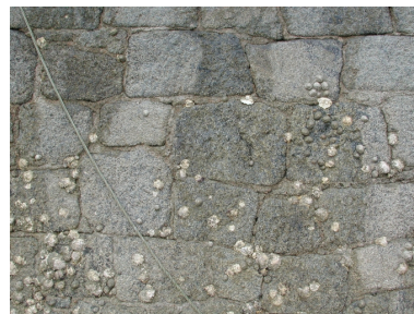
Appareillage des pierres de recouvrement du mur du quai de la jetée Phot. Guy Prigent IVR53_20072207778NUCA
