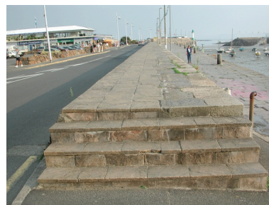
Vue générale du parapet Phot. Guy Prigent IVR53_20072207781NUCA
