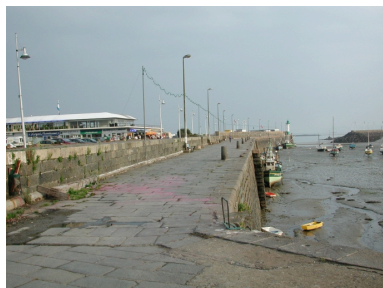
Vue générale de la jetée Phot. Guy Prigent IVR53_20072207780NUCA
