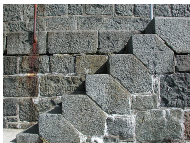
Les escaliers du quai : remarquer leur appareil en pierre hexagonales, avec les marques des tacherons
