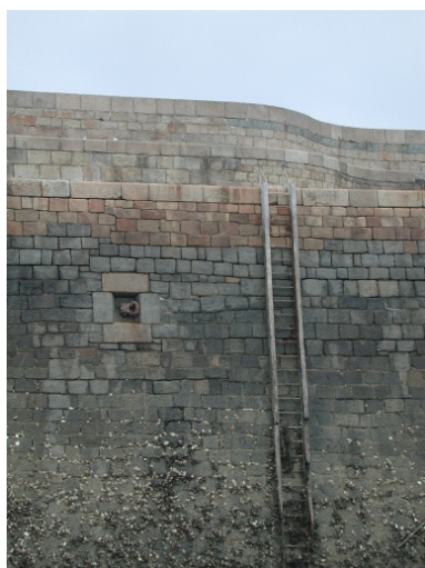
Echelle de la jetée en fer forgé et anneau d'amarrage Phot. Guy Prigent IVR53_20072207774NUCA
