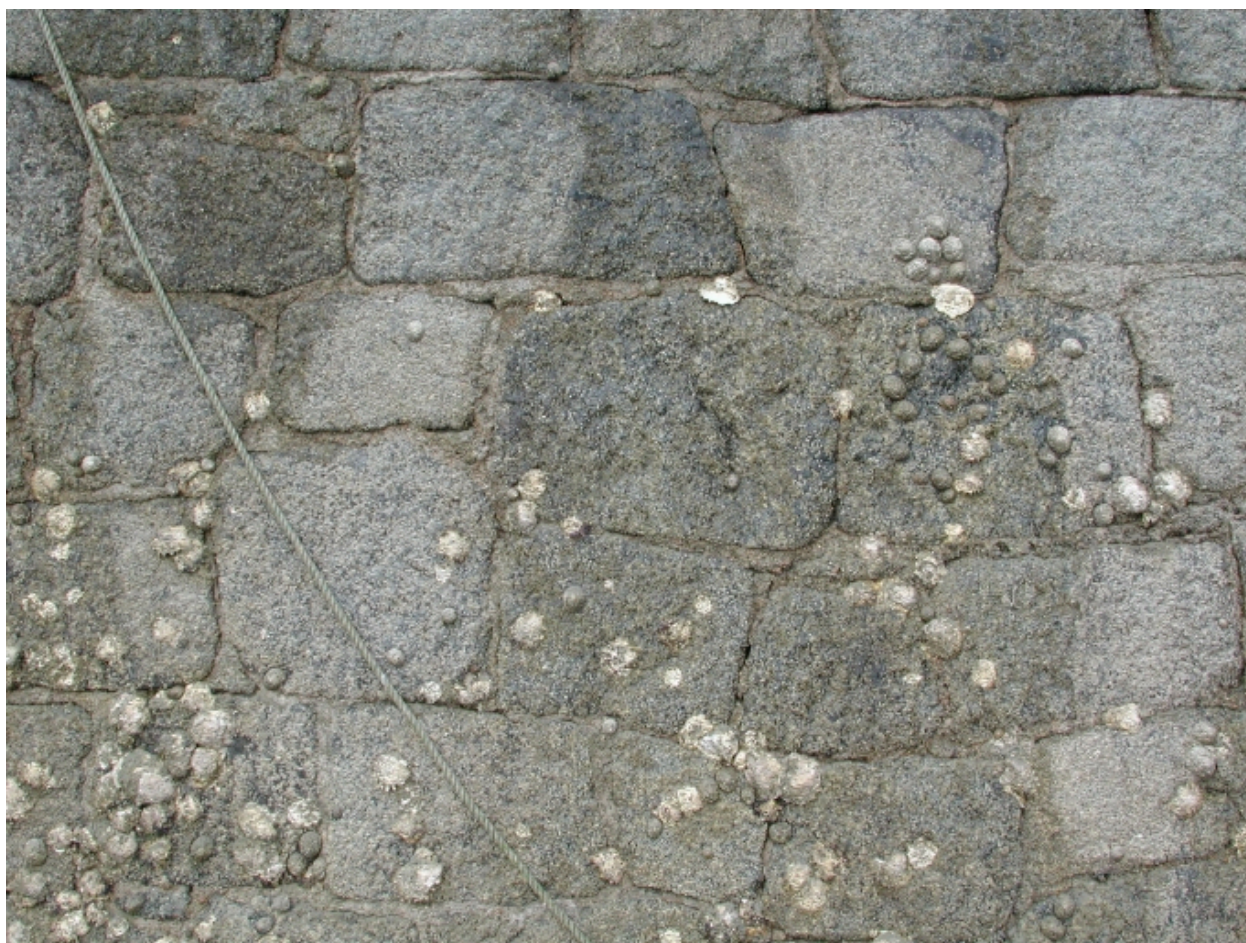
Appareillage des pierres de recouvrement du mur du quai de la jetée
