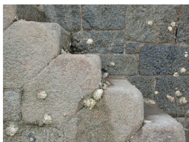
Vue de détail des pierres de l'escalier taillées en losange Phot. Guy Prigent IVR53_20072207777NUCA
