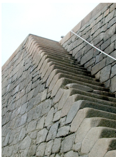
Vue de l'assemblage des pierres de l'escalier avec le mur du quai Phot. Guy Prigent IVR53_20072207776NUCA
