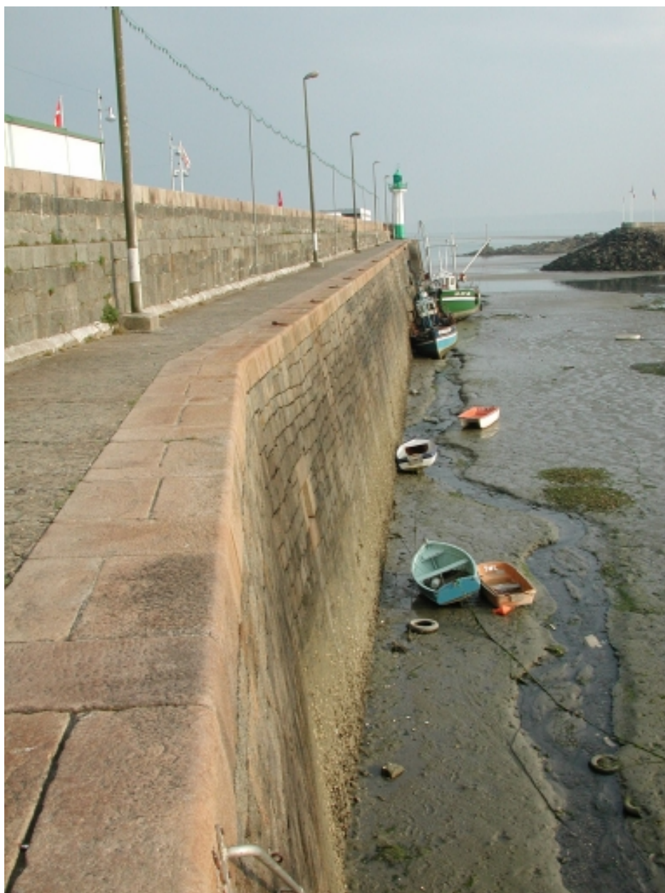
Vue de la forme convexe, rentrante du quai
