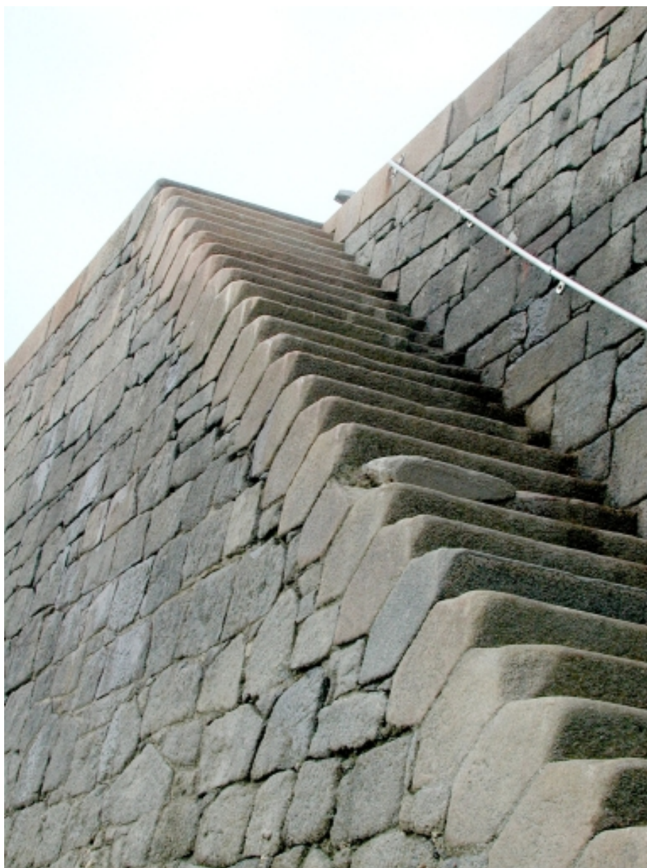
Vue de l'assemblage des pierres de l'escalier avec le mur du quai
