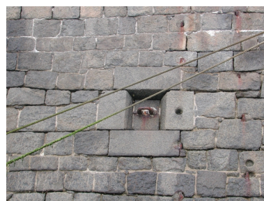
Détail de l'anneau d'amarrage, scellée dans sa cage de pierres taillées Phot. Guy Prigent IVR53_20072207775NUCA
