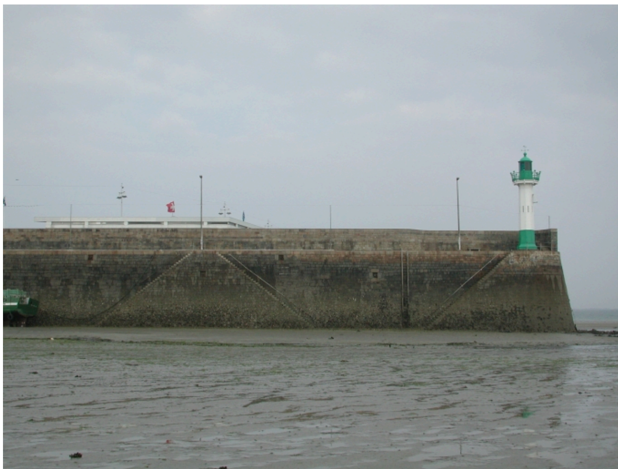
La dernière partie rectiligne de la jetée : remarquer le double escalier au bout du môle
