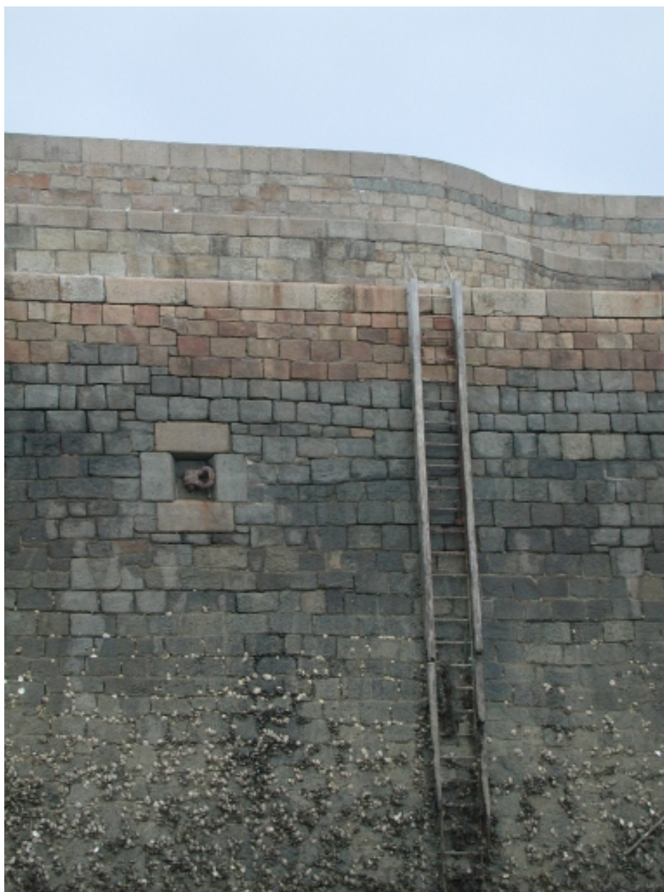
Echelle de la jetée en fer forgé et anneau d'amarrage
