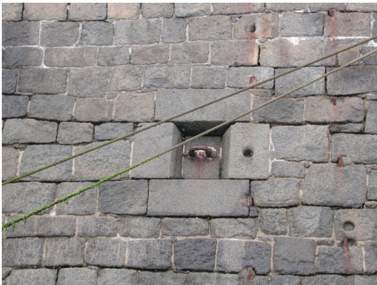
Détail de l'anneau d'amarrage, scellée dans sa cage de pierres taillées
