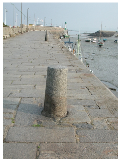
Vue de l'une des 9 bornes d'amarrage du quai (appellation bollards) Phot. Guy Prigent IVR53_20072207784NUCA
