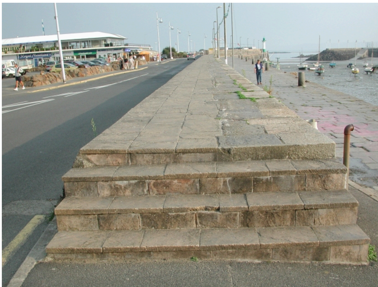
Vue générale du parapet
