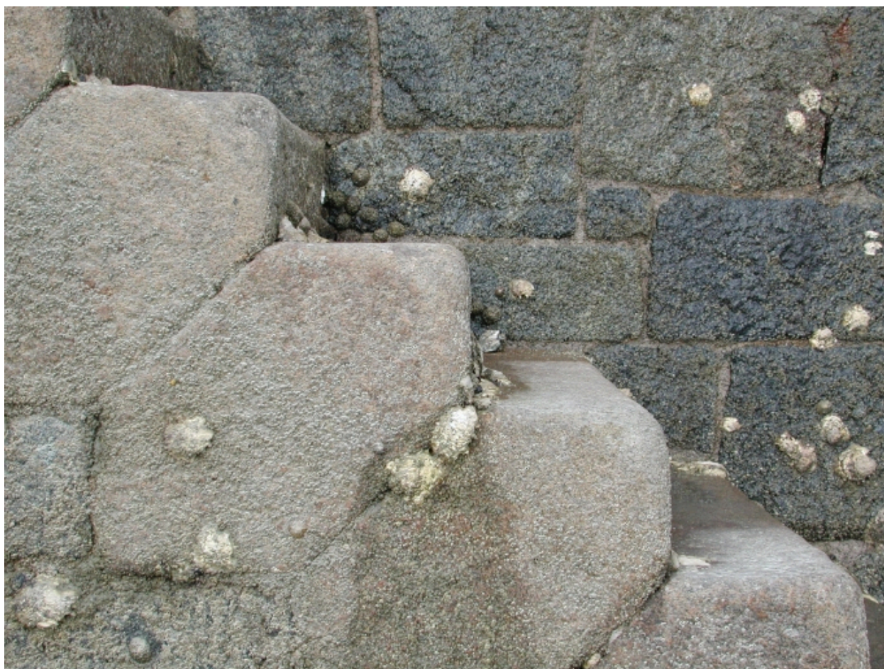
Vue de détail des pierres de l'escalier taillées en losange
