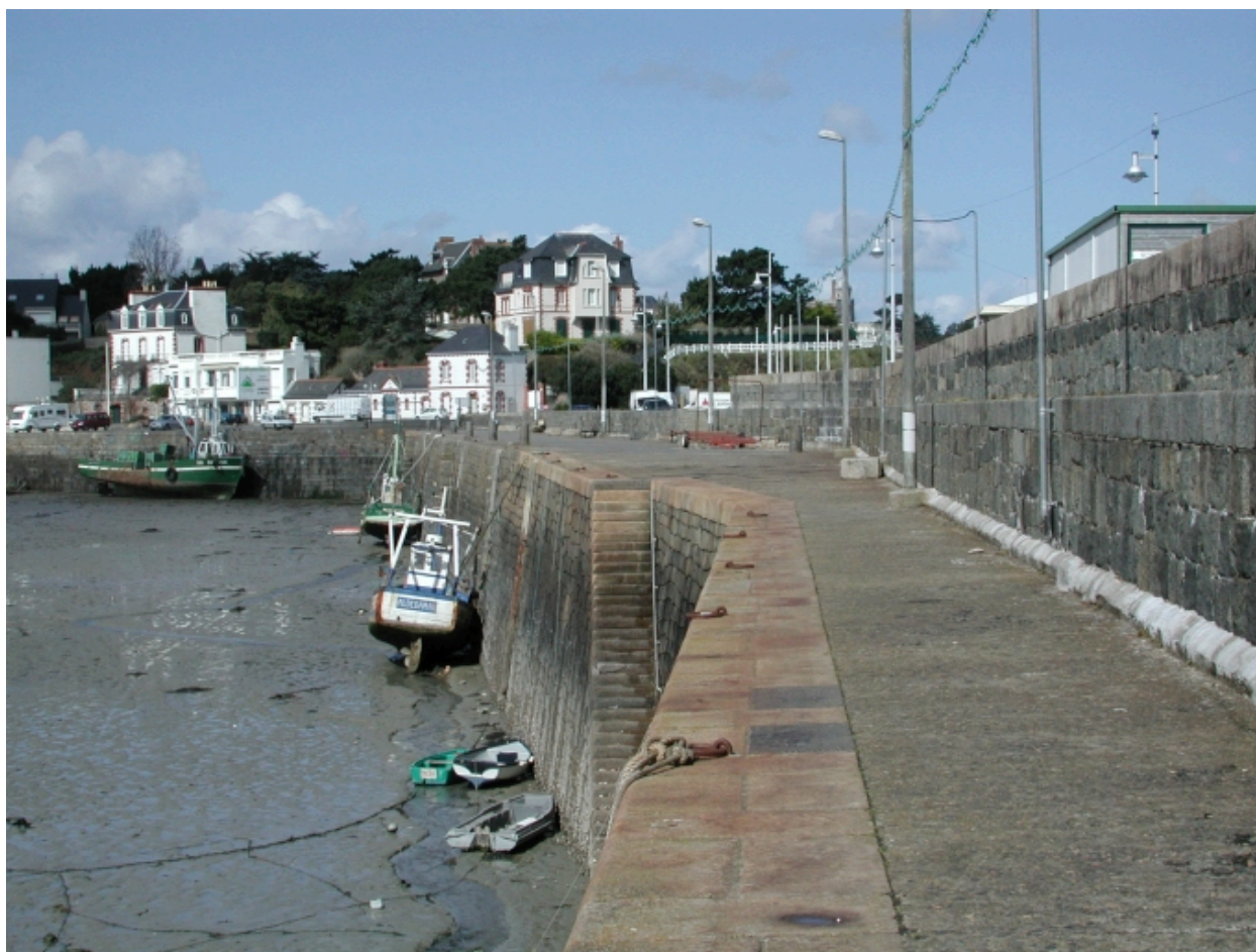
Vue de la jetée de Portrieux : remarquer le quai et le parapet
