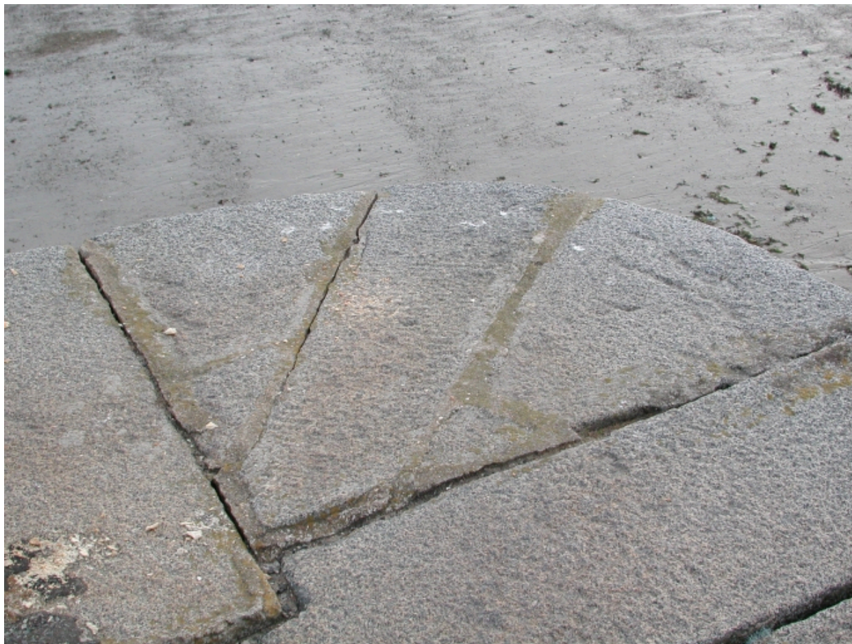
Appareillage des pierres du môle
