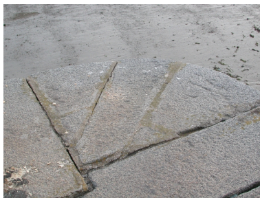
Appareillage des pierres du môle Phot. Guy Prigent IVR53_20072207779NUCA
