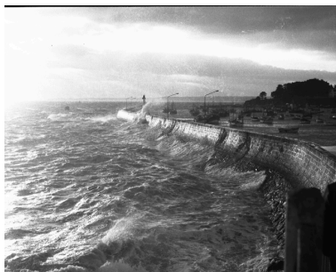
La jetée du Portrieux dans la tempête, 3ème quart 20ème siècle (AD 22, Fonds Jouas Poutrel) Repro. Guy Prigent, Autr. Joël Jouas Poutrel IVR53_20072207762NUCB
