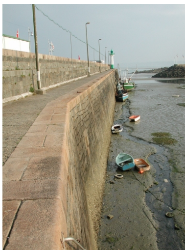
Vue de la forme convexe, rentrante du quai Phot. Guy Prigent IVR53_20072207785NUCA
