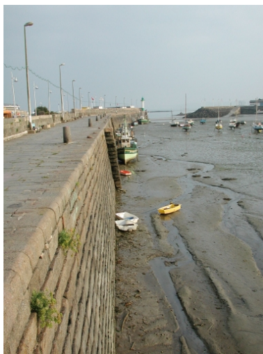
Vue du fruit du mur du quai de la jetée Phot. Guy Prigent IVR53_20072207782NUCA
