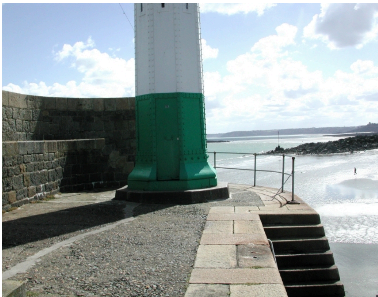
La jetée et le fanal au bout du môle : remarquer l'assemblage des pierres de parement
