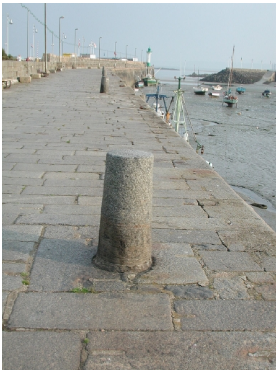
Vue de l'une des 9 bornes d'amarrage du quai (appellation bollards)
